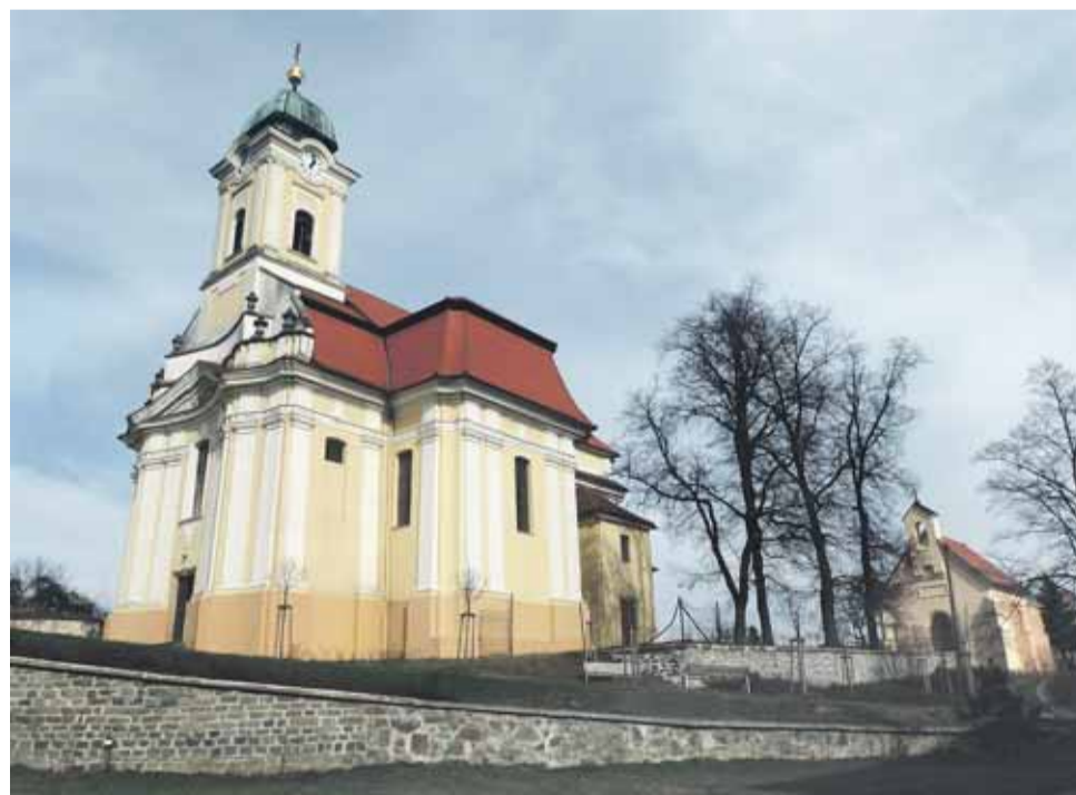
Kostel Všech svatých v Dobromilicích.
