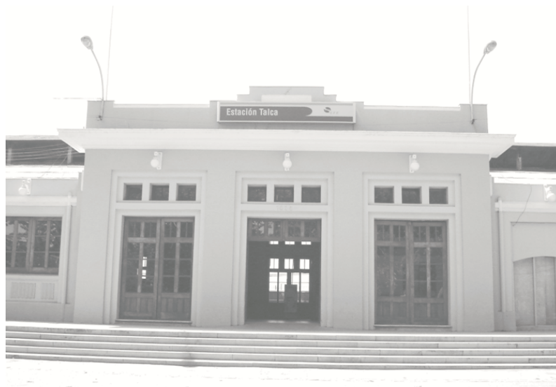
Estación de Talca fotografía año 2005
