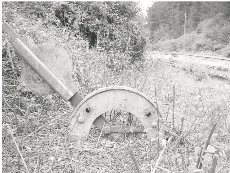
Detalle Ramal Línea Férrea fotografía año 2005
