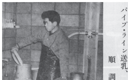
昭和42年 生乳輸送パイプライン完成
