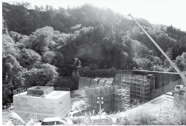
▲ 建設工事が進む升玉水力発電所
