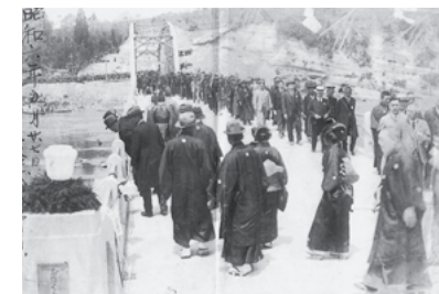
昭和6年 大蔵橋が鉄橋となる
