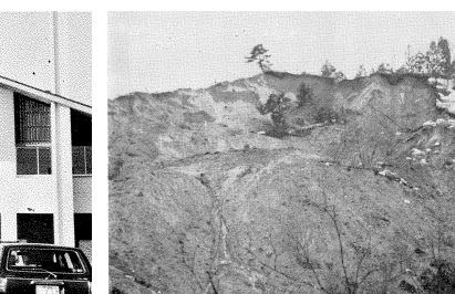
昭和49年 赤松山崩れ災害
