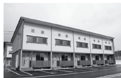
平成24年 子育て支援住宅完成
