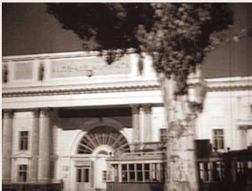
Здание Центральной объединенной киностудии (ЦОКС). г. Алма-Ата. 40-е годы
