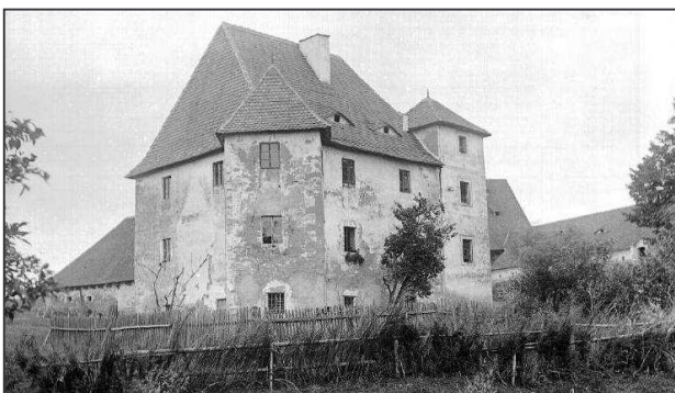
Obr. 5. Horní Hraničná, zámek od jihozápadu (foto A. John 1892).
