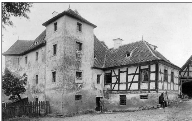
Obr. 10. Horní Hradičná, schodišťová věž a zámecké křídlo (foto J. Haberzettl 1900).
