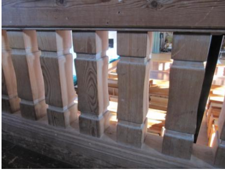
Läktarbalustrad i kraftfulla former.
