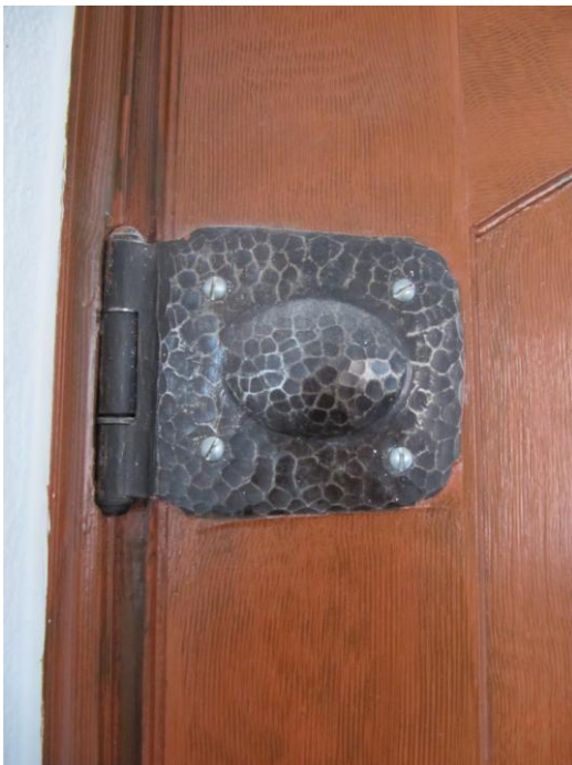
Det nationalromantiska idealet märks in i minsta detalj, till vänster ett dörrgångjärn av svart "hamrat" järn. Man kan se en strävan efter att ge smidet ett "primitivt" uttryck för att kunna skapa en känsla av ålderdomlighet. Förebilden är utanpåliggande gångjärn från 1600-talet och 1700-talet, men fritt omtolkade. Till höger väggarmatur från byggnadstiden med en stramare utformning. Korridorstaket har en elegant indelning som utgår från en hålkälsliknande taklist.
