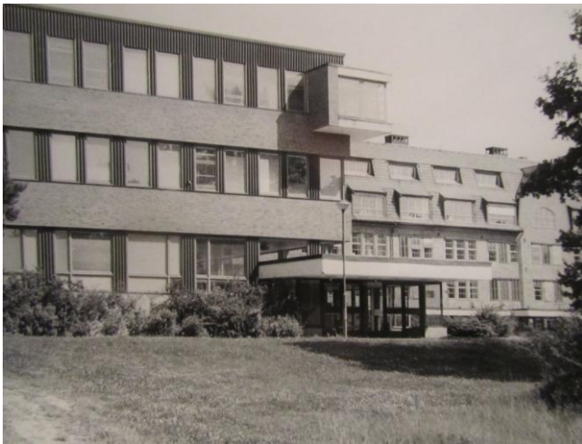
"Nya byggnaden" från 1965 och den äldre delens sydfasad innan tillbyggnaden 1983.
