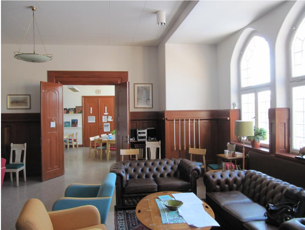
Kollegierummet. Den höga panelen, dubbeldörrarna, det i fasaden utskjutande fönsterpartiet med blyspröjsade glas ger rummet en påkostad karaktär. Snickerierna var av lokal tillverkning, från Moranäs snickerifabrik i Saltsjöbaden.
