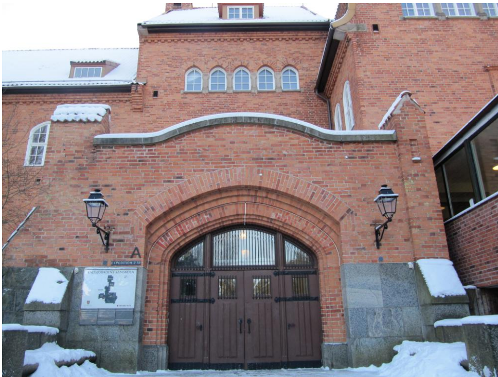
Huvudentré med granitdetaljer, tegelvalv och dörrsnickerier från byggnadstiden. Lyktorna är inte ursprungliga.
