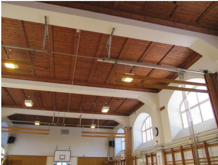
Gymnastiksalens tak är "panelat med spontade bräder samt lacerat och fernissat", enligt beskrivning från 1915.
