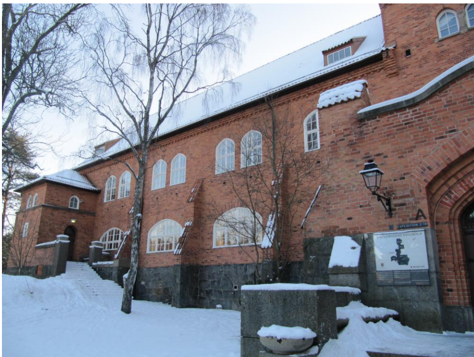
Norra längans västfasad. Karaktärsskapande är gymnastiksalens låga och breda fönster med antydning till spetsbågig avslutning. Aulans kopplade fönster på övervåningen har tydligare spetsbågar. Detta och murarnas strävpelare ger norra längan en närmast kyrklig prägel. Utmärkande är även den höga granitsockeln som förankrar byggnaden med marken och den strama, okomplicerade takytan. Södra längan har en annan takkaraktär med framträdande takkupor.
