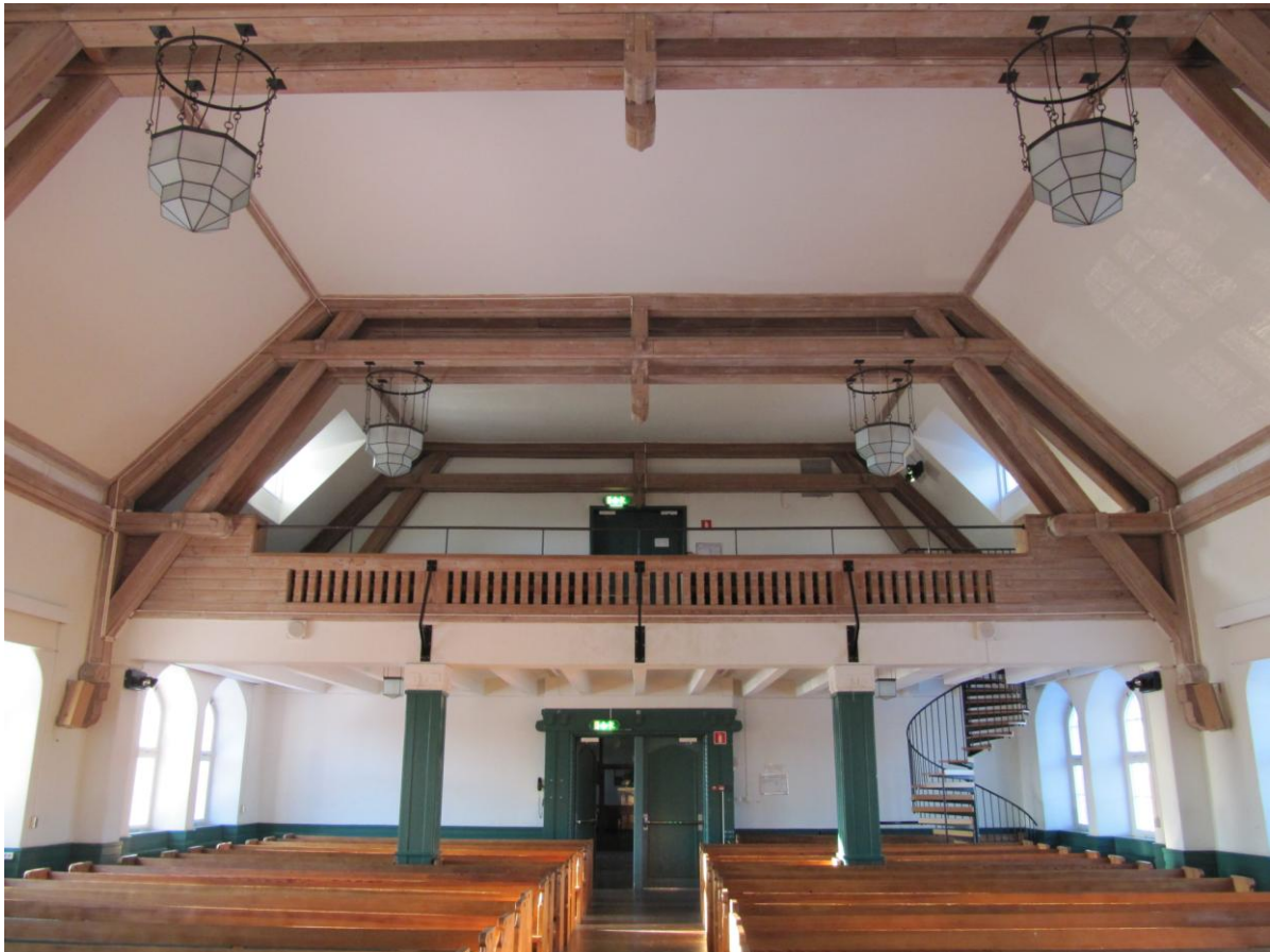
Aulan, högtidssalen, sedd mot entrén med läktare. Den kraftfulla öppna takkonstruktionen sätter stark prägel på rummet.
