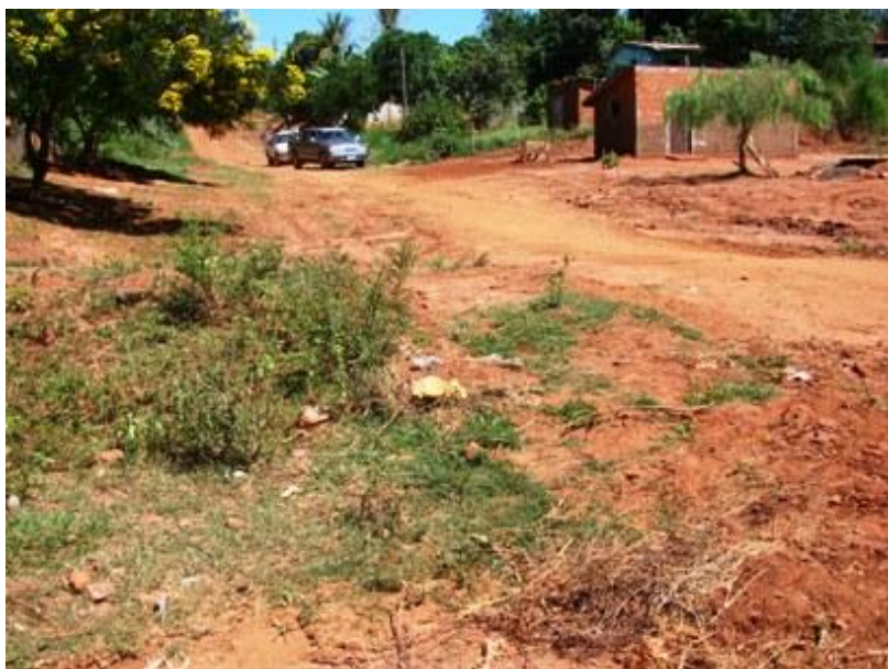
FIGURA 57: VIA SEM PAVIMENTAÇÃO
