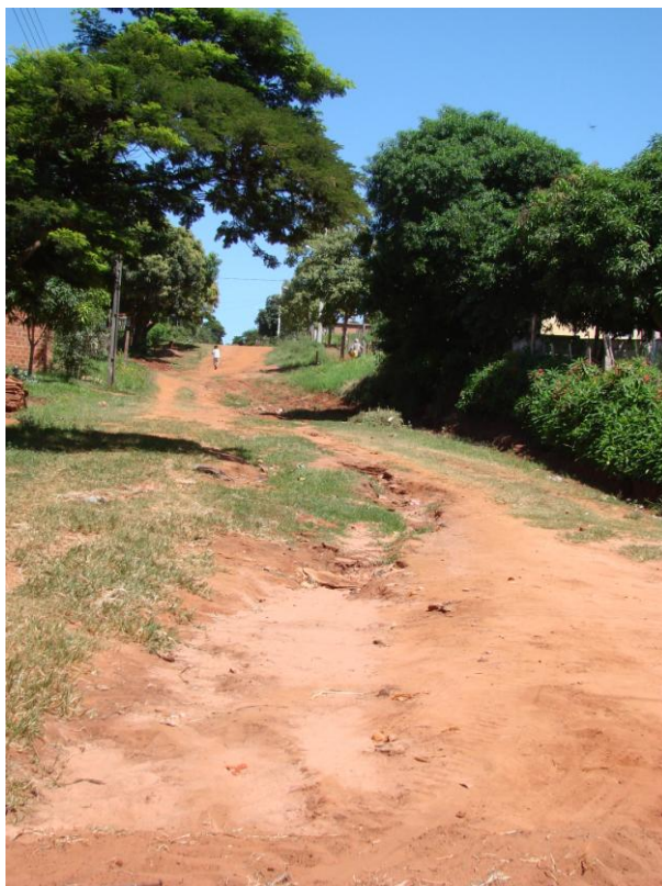
FIGURA 58: EROSÃO NA RUA GEREMIAS GONÇALVES ROCHA
