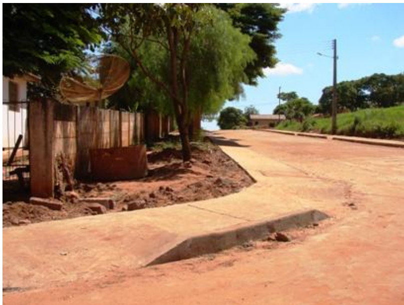
FIGURA 55: PAVIMENTAÇÃO NO CONJUNTO PRINCESINHA DO OESTE
