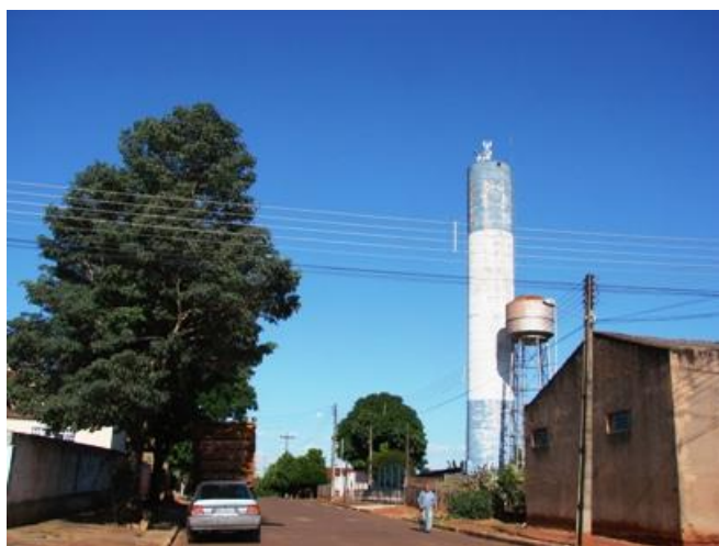
FIGURA 36: RESERVATÓRIO DE ÁGUA SAMAE
