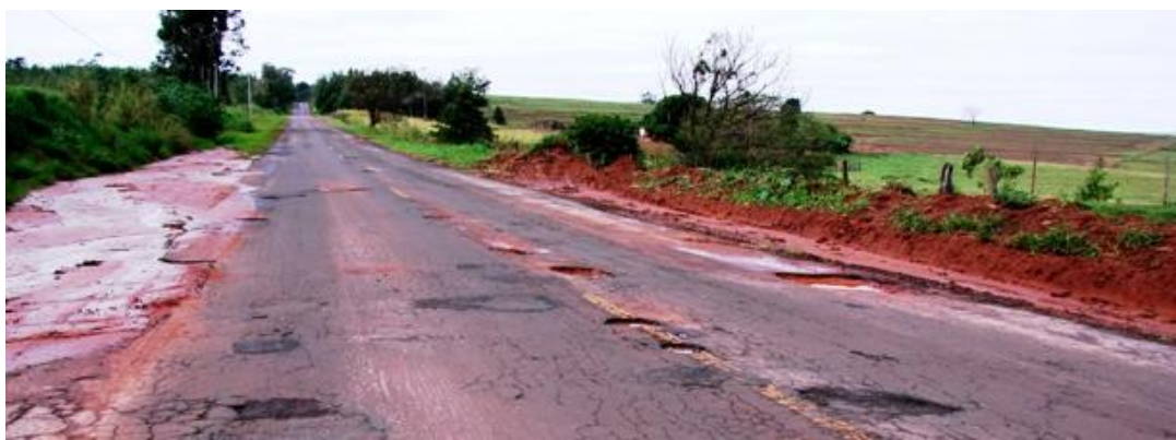
FIGURA 44: ASFALTO PR-468 SENTIDO UMUARAMA - MARILUZ
