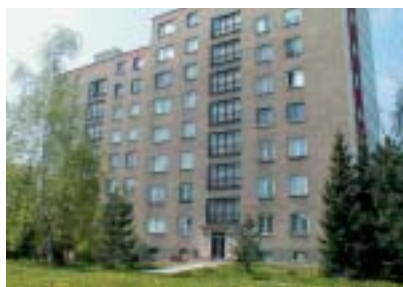
Obr. 1 Panelový dům typové řady T03B-OS Fig. 1 Block of flats – T03B – OS type series prefab building
