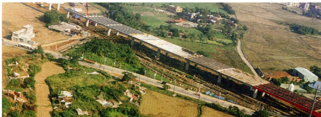
照片 6.4.4-8 觀音大溪線施工
