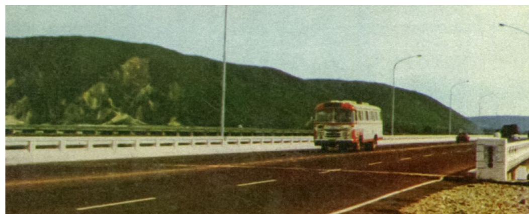
照片5.1.2-34 大安溪橋
