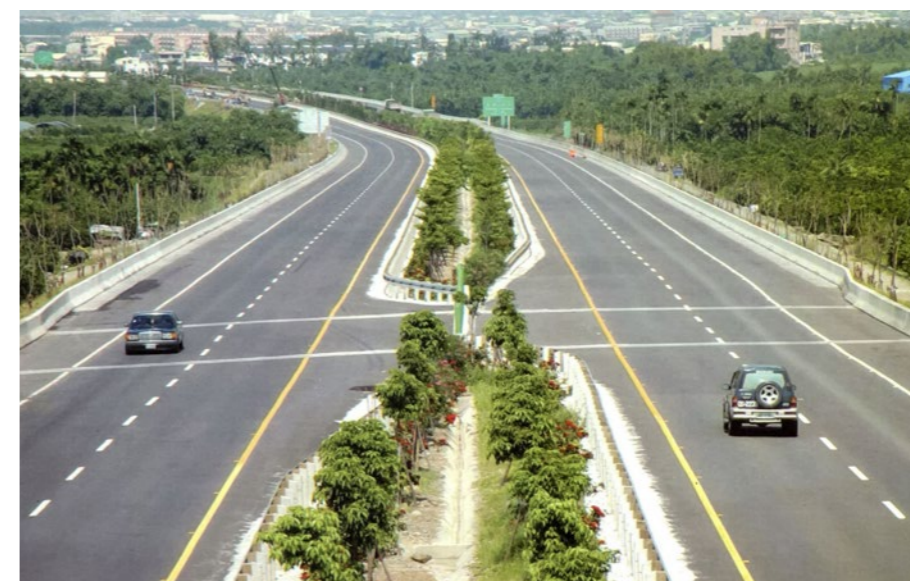
照片6.4.4-22 台西古坑線近古坑端線美化情形
