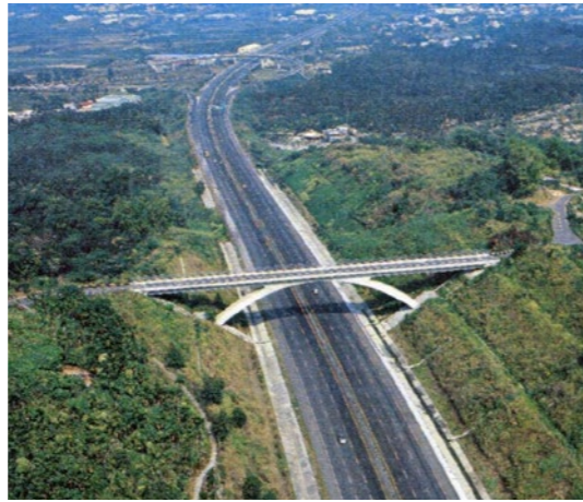
照片7.2.2-4 國道3號水上跨越橋
