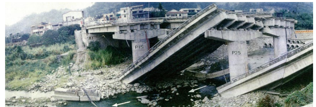
照片 8.2.2-1 台 3 線石圍橋因斷層通過引致落橋情形
