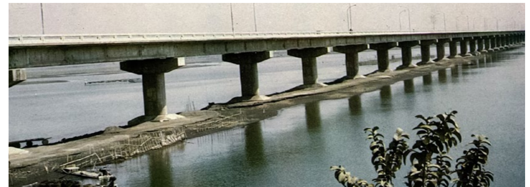
照片 5.5.4-4 民國 65 年 6 月完工之雙園大橋（長 2,083 公尺，寬 7.5 公尺）
