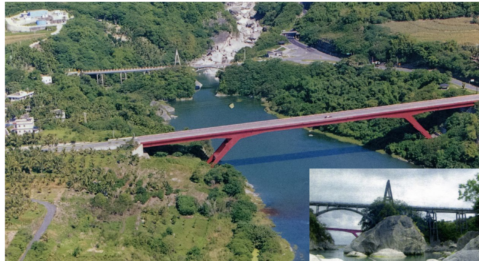
照片5.1.2-4 民國81年1月完工之新東河橋
