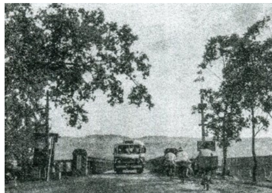
照片8.1.4-1 省道及代養縣鄉公路重建完成之一
