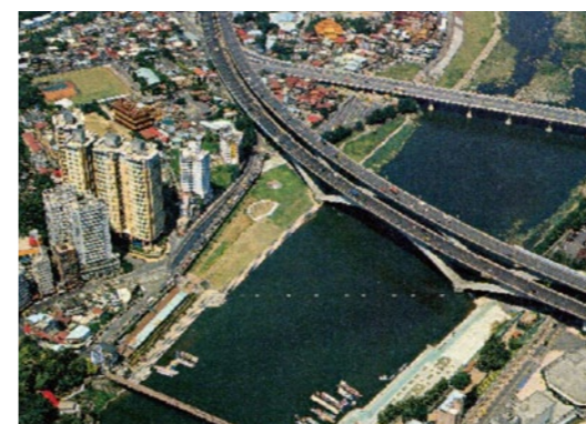
照片7.2.1-1 國道3號碧潭橋
