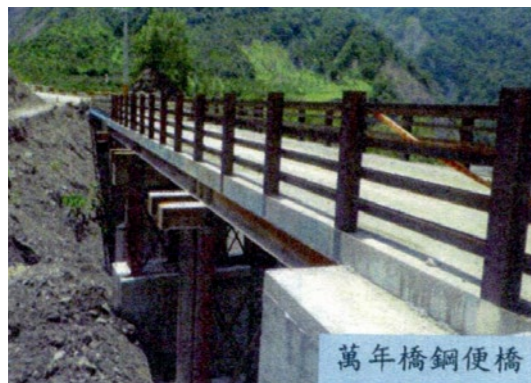
照片8.5.2-9 萬年橋鋼便橋
