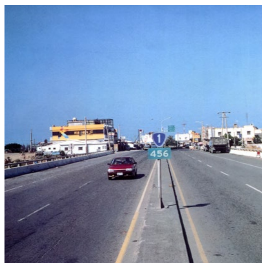
照片5.2.1-6 拓建後的枋山-楓港路段
