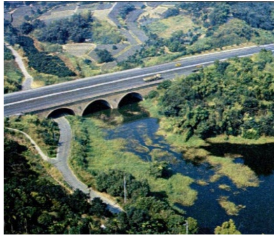
照片7.2.2-2 國道3號內埔子水庫高架橋
