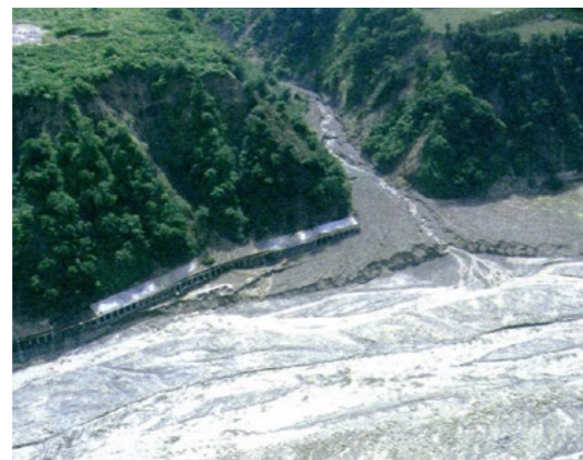
照片8.3.2-5 台21線95K明隧道口遭土石流掩埋
