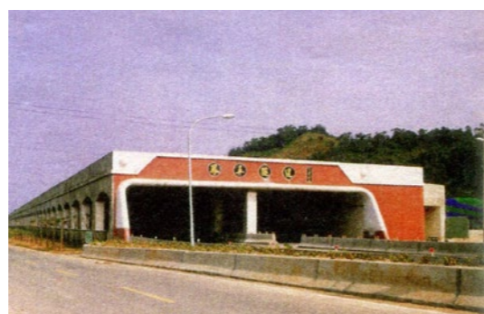
照片6.3.4-2 鳳鼻隧道
