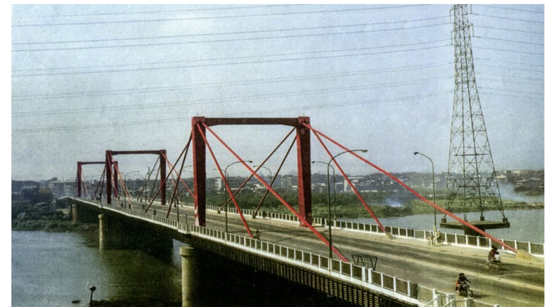
照片5.6.1-9 建於民國66年12月完工的新光復橋
