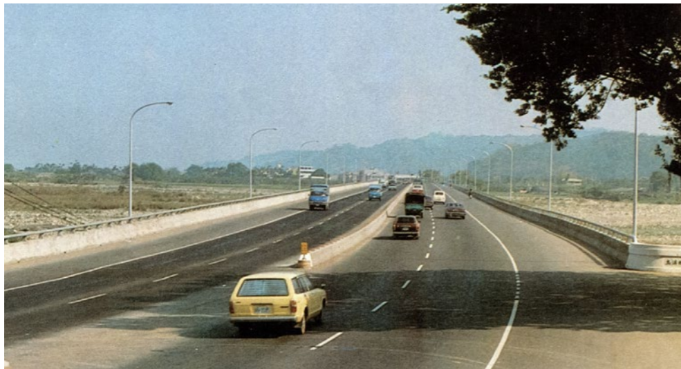
照片5.3.1-6 修復完工之烏溪橋
