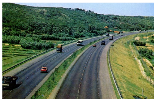
照片7.1.4-6 楊梅路段完工
