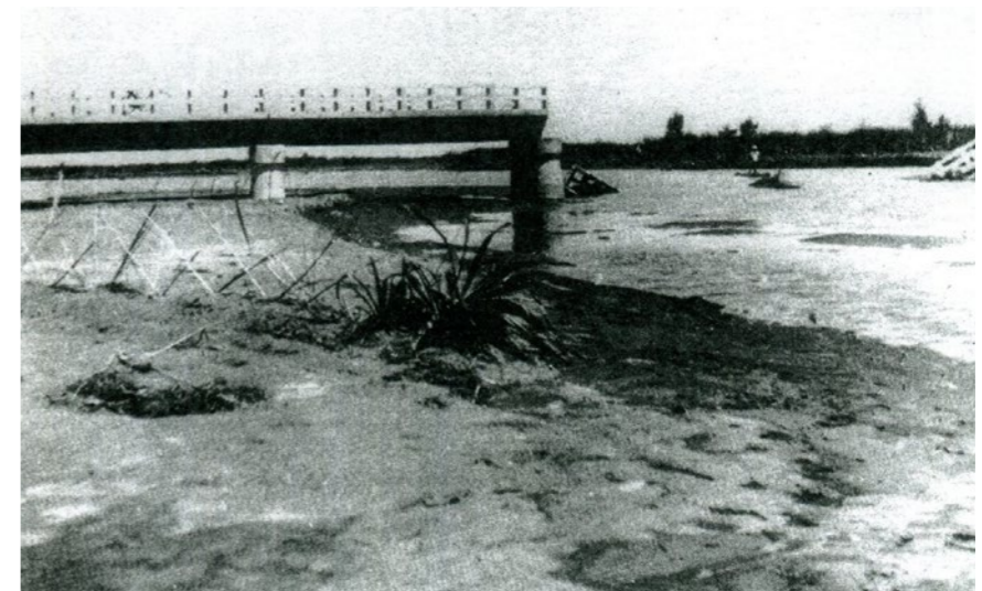
照片8.1.2-4 八七水災公路損失
