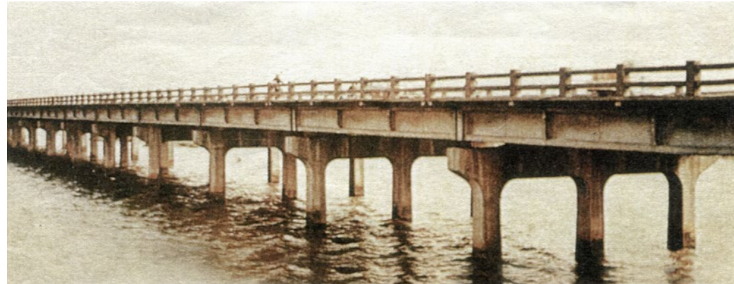
照片 5.1.2-5 民國 47 年 10 月完工之中興大橋
