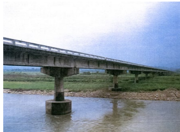
照片5.1.2-11 雲南大橋(新橋)
