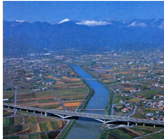
照片 7.3.2-1 國道 5 號冬山河橋
