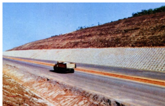
照片7.1.4-3 三義路段道路施工情形
