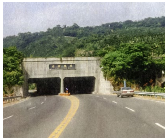
照片5.4.5-4 新水里隧道
