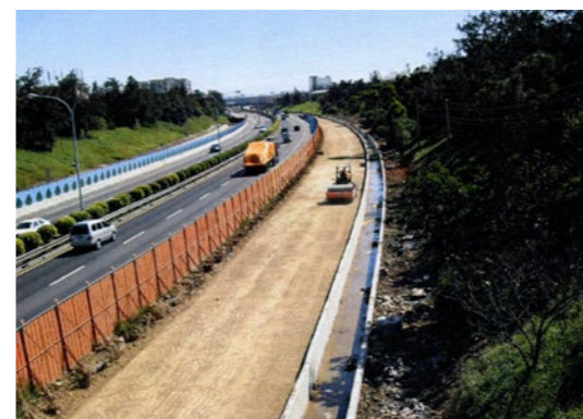
照片7.1.5-1 國道2號(中山高桃園機場支線)拓寬施工
