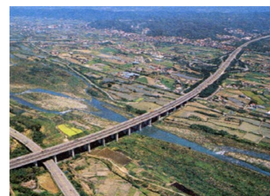
照片7.2.1-3 國道3號頭前溪橋
