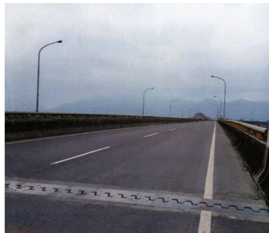
照片5.6.1-16 高樹大橋重建之一
