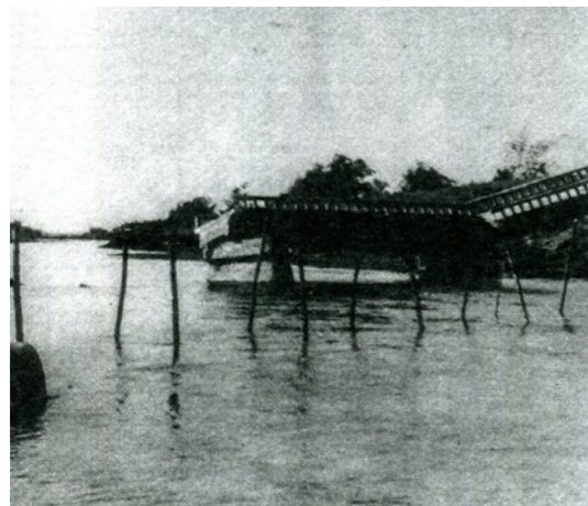
照片8.1.2-5 八七水災橋樑斷裂
