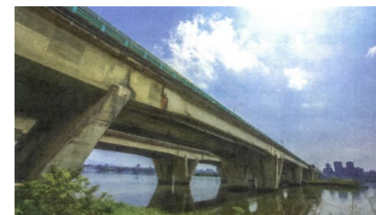
照片5.6.1-4 重建後的中興大橋
