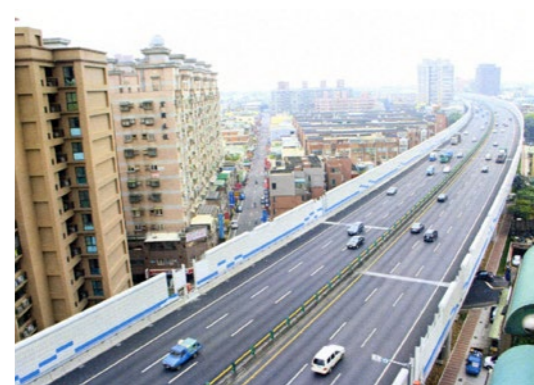
照片7.1.5-2 國道2號(中山高桃園機場支線)拓寬完工
