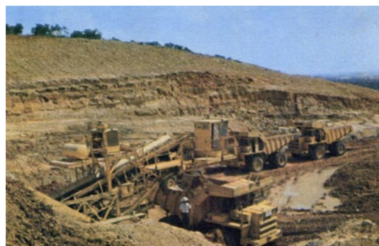
照片7.1.4-1 國道三重-中壢段施工情形
