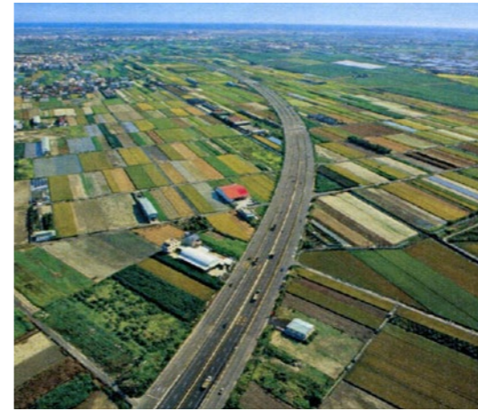
照片7.2.2-9 國道8號安南路段
