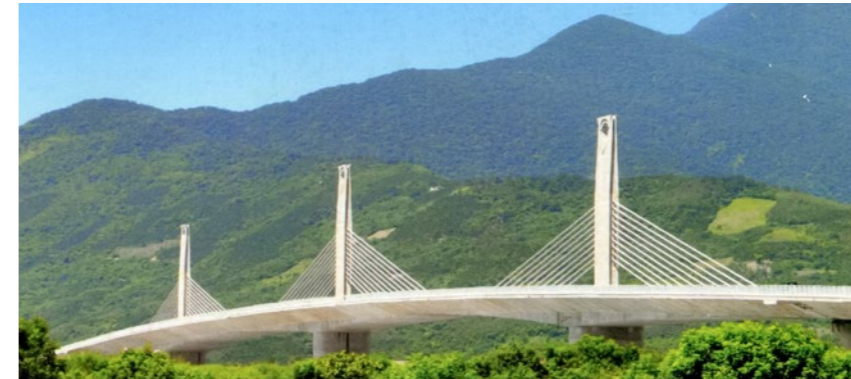
照片5.2.2-9 花東公路新豐平大橋
