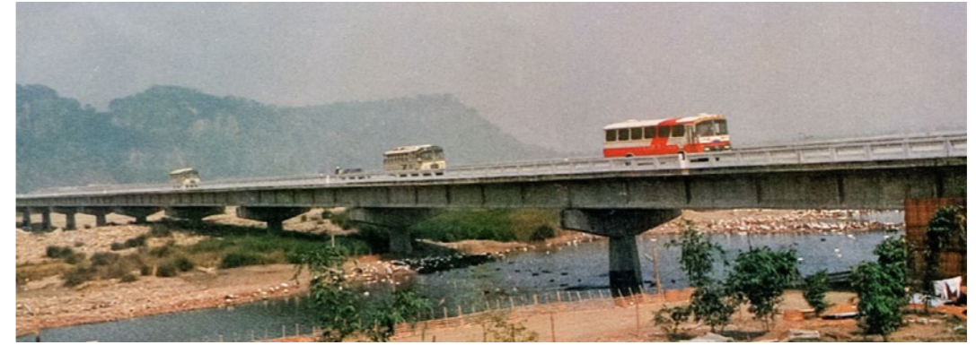
照片 5.5.4-1 民國 68 年 10 月完工之舊中彰大橋
