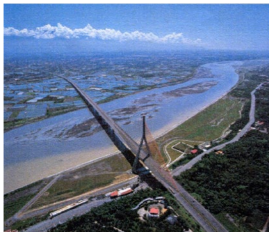
照片7.2.2-5 國道3號高屏溪橋
