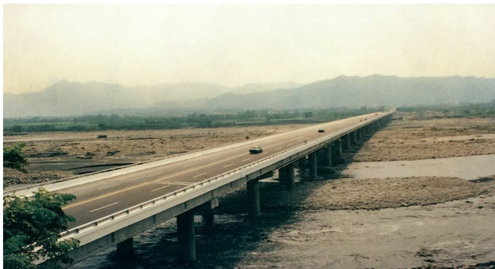
照片5.3.1-7 修復完工之名竹大橋
