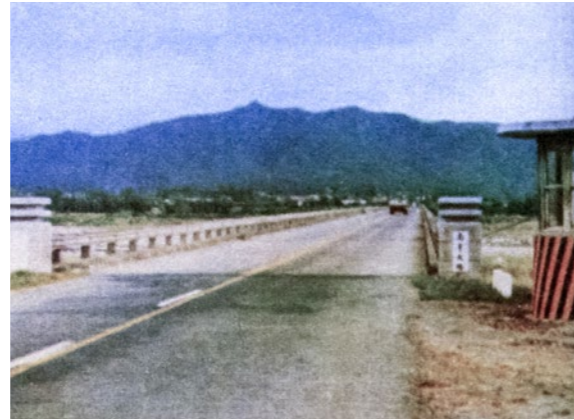
照片5.1.2-10 雲南大橋(舊橋)
