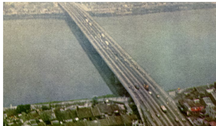
照片5.1.2-21 第四代台北大橋
