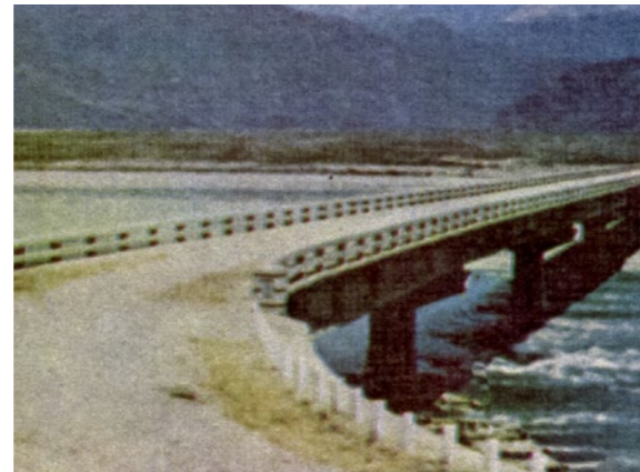
照片5.1.2-15 花蓮溪橋
