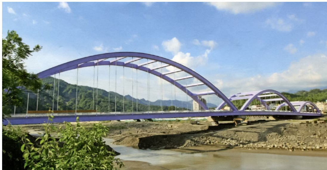
照片5.4.7-6 民國99年6月通車的甲仙大橋
