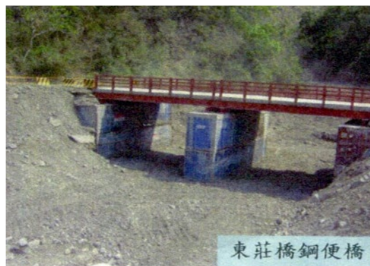
照片8.5.2-12 東莊橋鋼便橋
