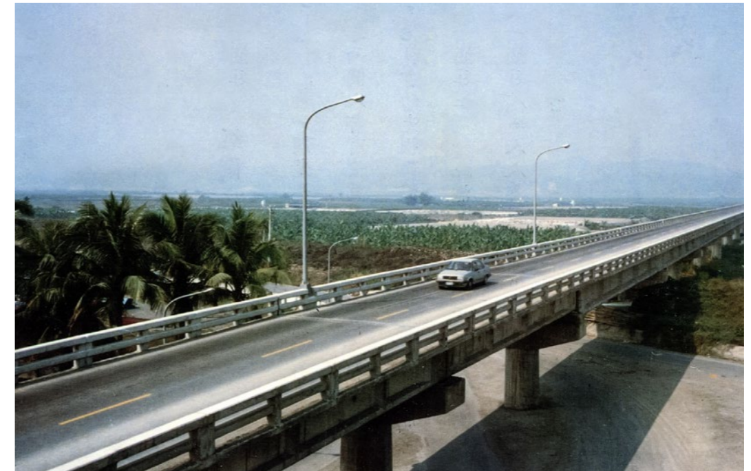
照片5.6.1-18 里嶺大橋(受災前)
