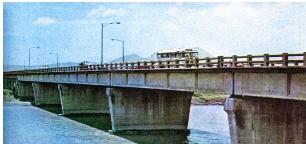
照片 5.1.2-6 第二代中興大橋
