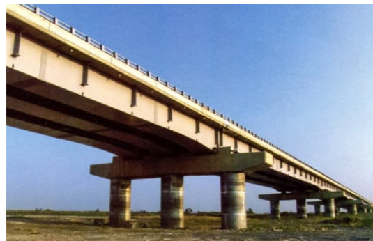
照片 5.3.3-1 自強大橋改建完工
