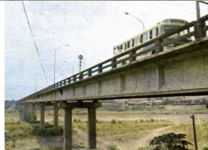
照片5.1.2-25 秀朗橋舊橋
