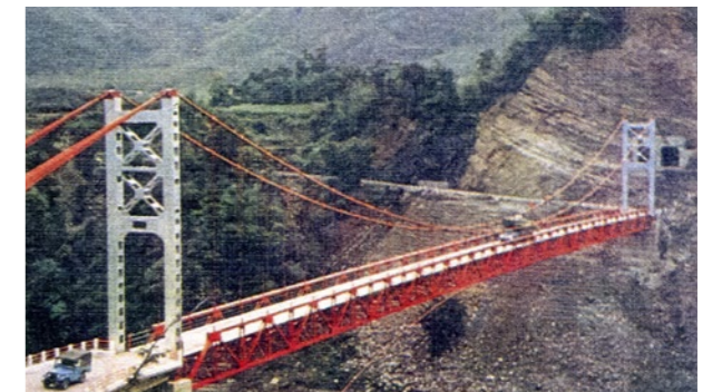
照片5.1.1-8 北橫復興吊橋
