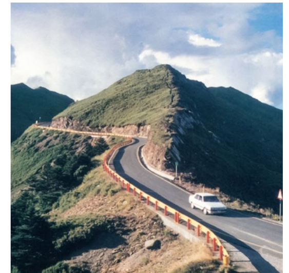
照片5.4.2-6 台8線松雪樓-大禹嶺路段
