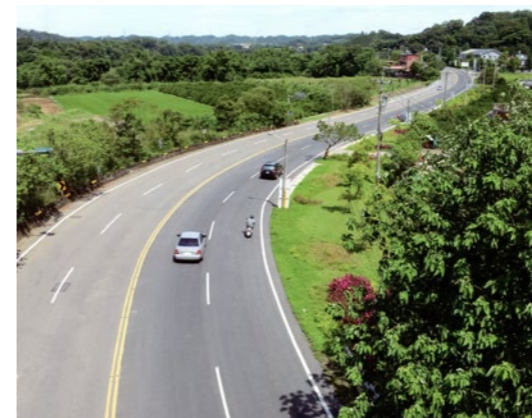
照片5.3.1-3 峨嵋路段拓寬 (四線混合車道)
