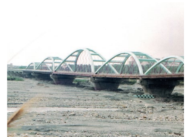
照片5.2.2-5 取代立霧溪上游舊橋之太魯閣橋
