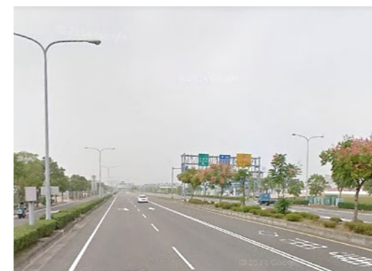
照片 5.6.1-25 台 18 線嘉義 50 公尺道路(高鐵大道)
