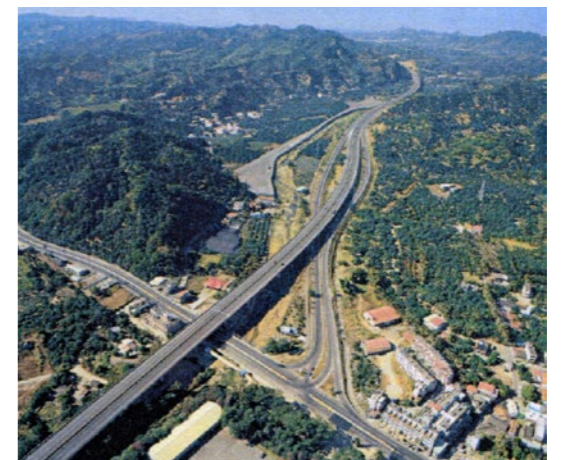
照片7.2.2-12 國道10號嶺口交流道
