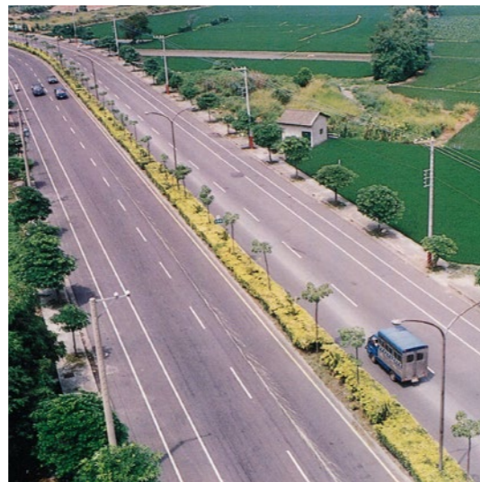
照片5.2.1-4 大甲-甲南段設有人行道之大甲外環線
