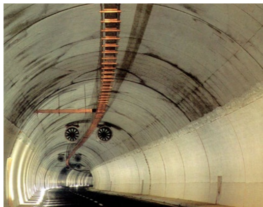
照片6.4.4-20 八卦山隧道
