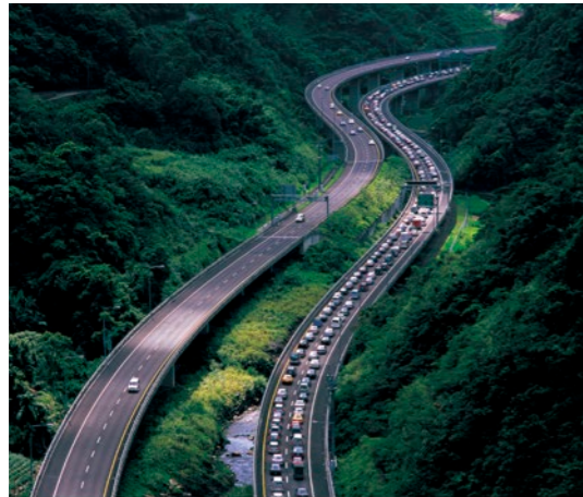
照片 7.3.1-1 國道 5 號坪林高架橋
