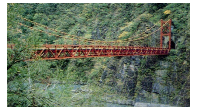
照片5.1.1-9 北橫巴陵吊橋
