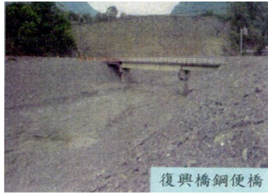
照片8.5.2-8 復興橋鋼便橋
