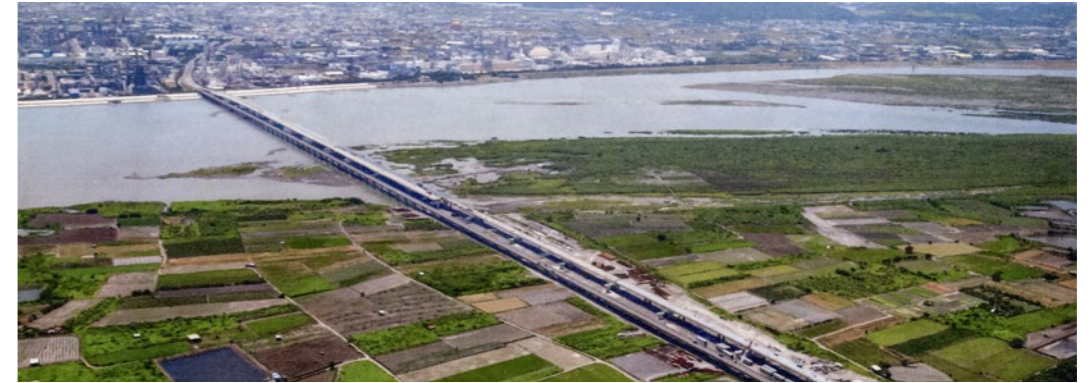
照片5.5.4-7 莫拉克災後於民國100年12月完成的新雙園大橋
