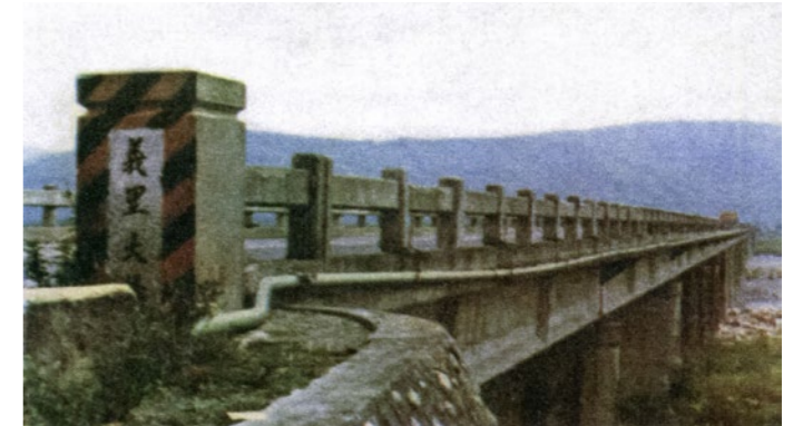
照片 5.1.2-8 義里大橋(舊橋)
