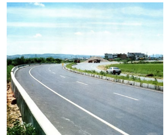
照片5.5.3-4 西濱公路竹圍附近
