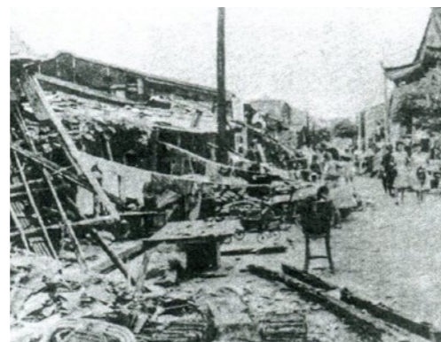
照片8.1.2-2 八七水災房屋損失
