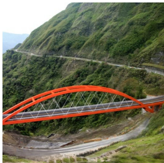
照片5.4.6-5 71K+100芙谷峩橋
