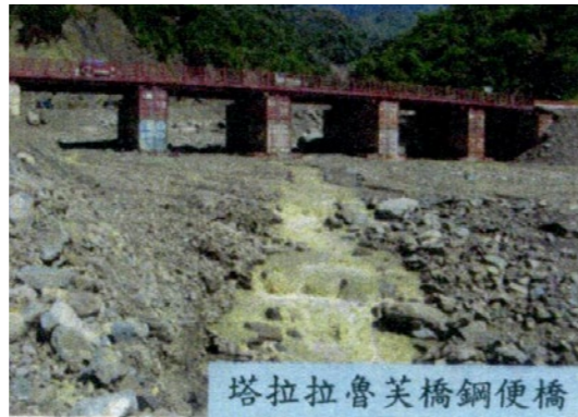
照片8.5.2-6 塔拉拉魯芙橋鋼便橋
