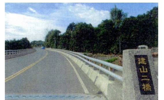
照片8.5.2-4 建山二橋完工
