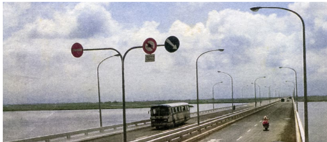
照片5.5.4-5 民國70年10月增建之雙園大橋平行橋
