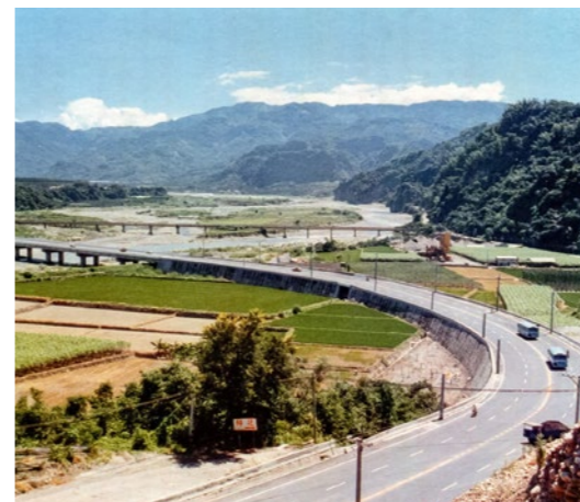
照片5.4.4-3 炎峰橋921地震前
