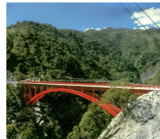
照片5.4.4-6 霧社-蘆山間雲龍橋
