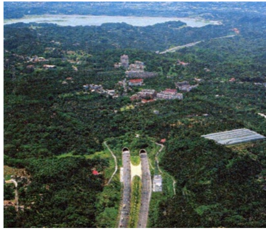
照片7.2.2-3 國道3號蘭潭隧道
