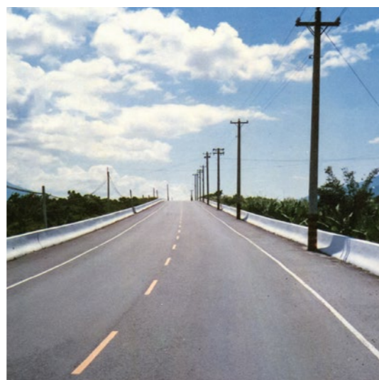
照片5.4.6-8 東段玉里玉山線卓溪橋
