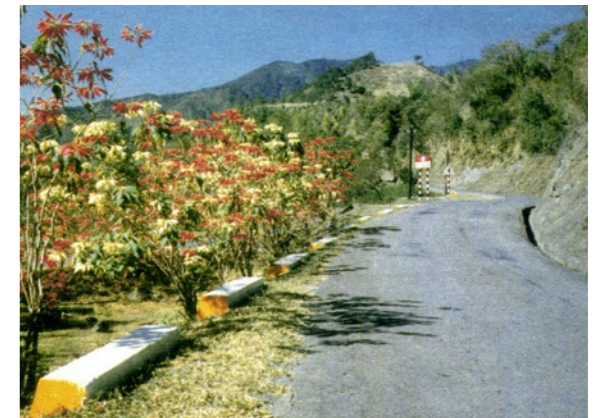
照片5.1.1-12 南部橫貫公路之一
