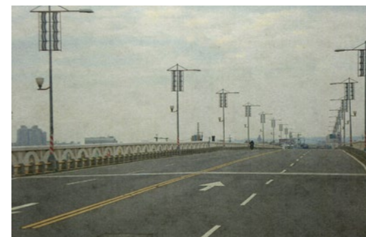
照片5.3.2-3 中港溪橋新建
