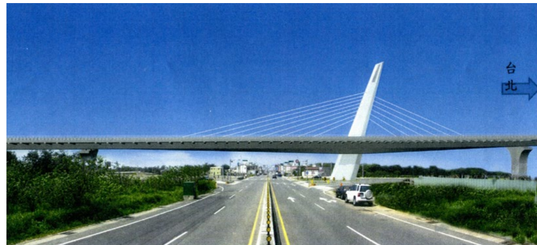
照片6.3.4-3 永安交流道脊背橋
