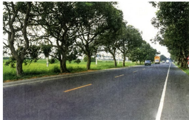
照片3.2.2-3 西部幹線之二（標準雙車道）
