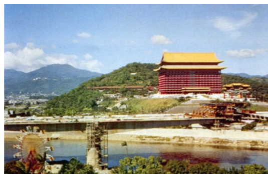
照片7.1.4-2 圓山橋施工情形
