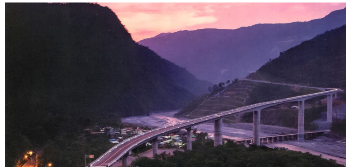
照片5.4.8-2 霧台谷川大橋
