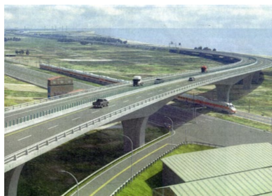
照片6.3.4-7 公鐵路相交處跨越橋
