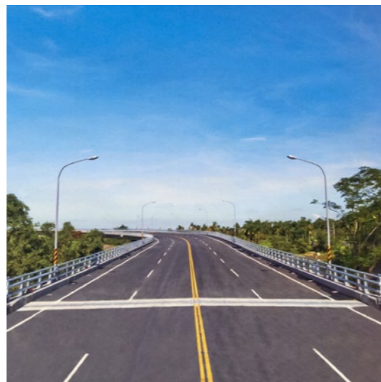
照片5.4.6-4 改建後的五虎寮橋
