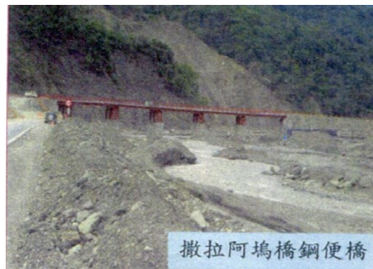
照片8.5.2-10 撒拉阿塢橋鋼便橋
