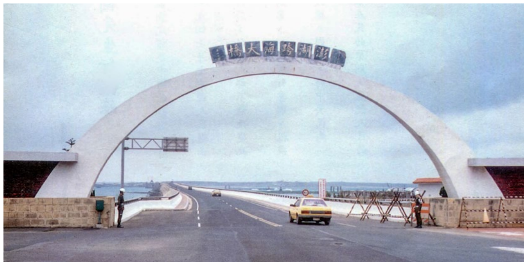
照片5.1.2-29 澎湖跨海大橋舊橋拱門
