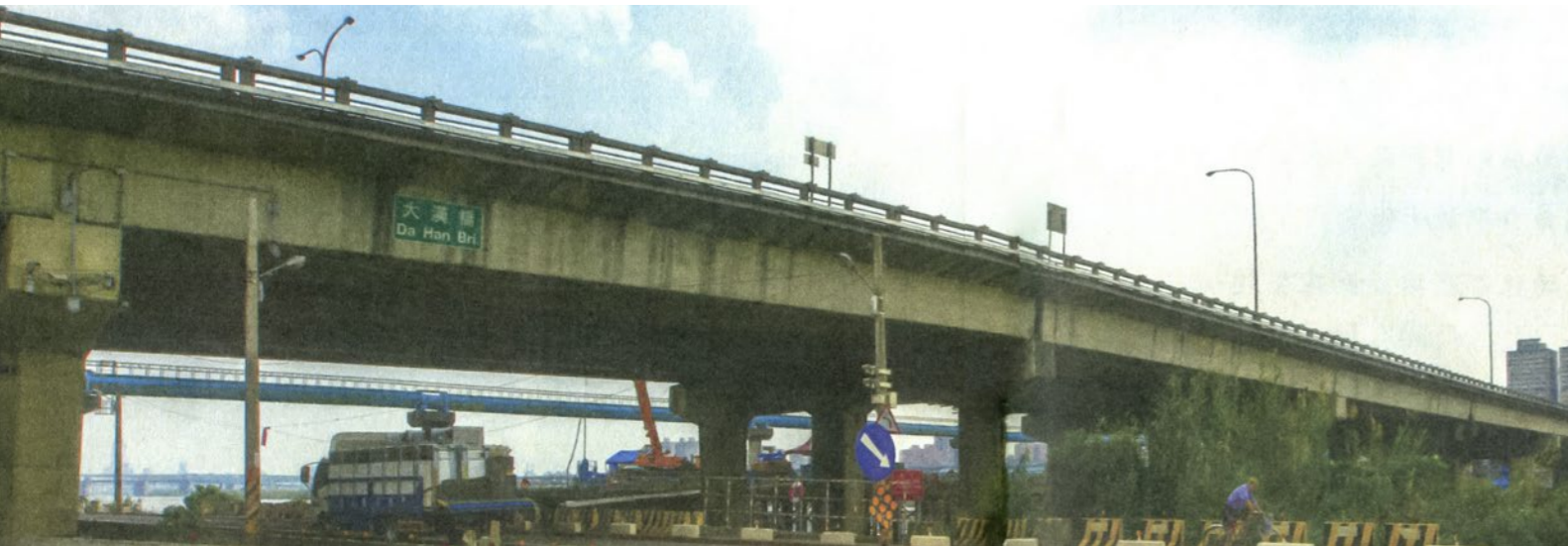
照片5.6.1-6 民國74年6月完工的大漢溪橋
