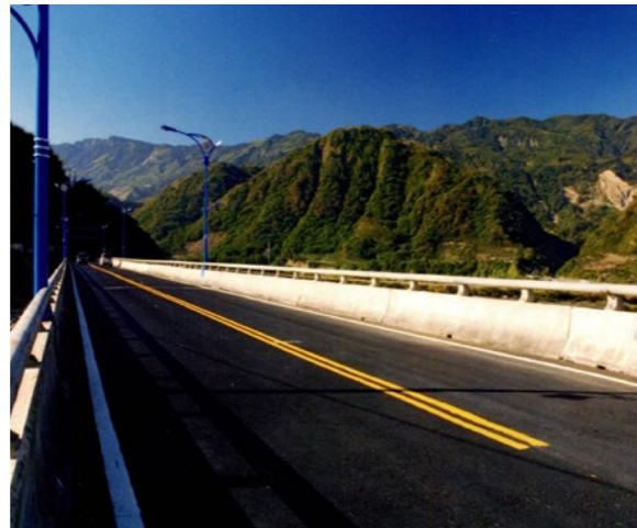
照片5.3.4-4 台21線信義橋
