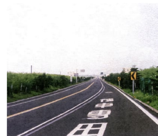
照片5.6.1-14 澎湖道路改善情形
