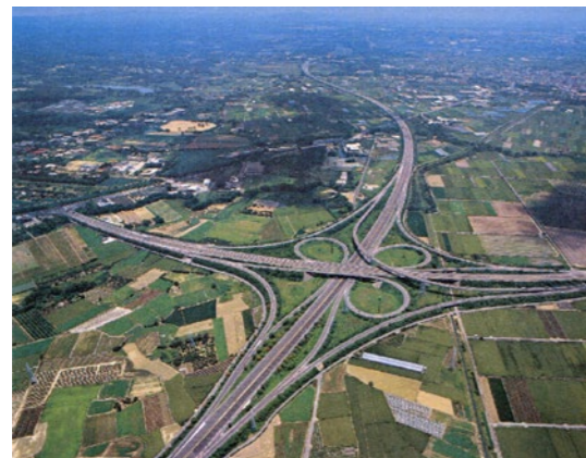
照片6.4.4-26 新化系統交流道
