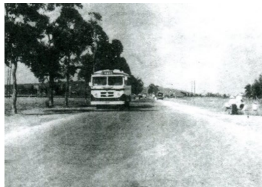
照片8.1.4-2 省道及代養縣鄉公路重建完成之二
