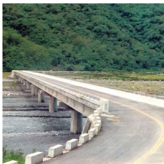
照片5.4.6-7 東段玉里玉山線卓鹿橋
