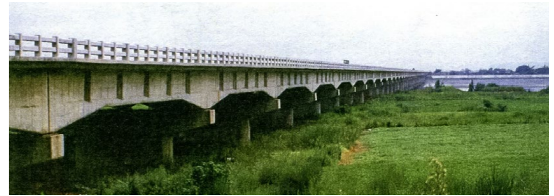
照片 5.5.4-2 民國 96 年 5 月完工之新中彰大橋
