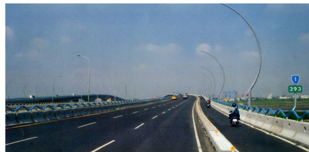
照片5.2.1-8 民國97年10月完工的新高屏大橋之一
