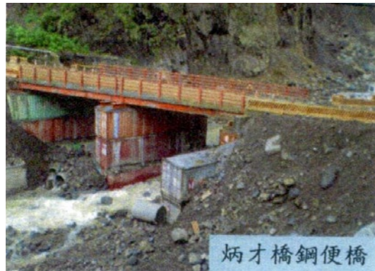
照片8.5.2-5 炳才橋鋼便橋
