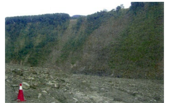
照片8.5.2-2 台20線99K明隧道遭掩埋河床淤高
