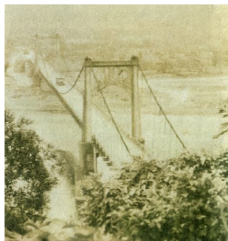
照片5.6.1-2 舊大溪橋
