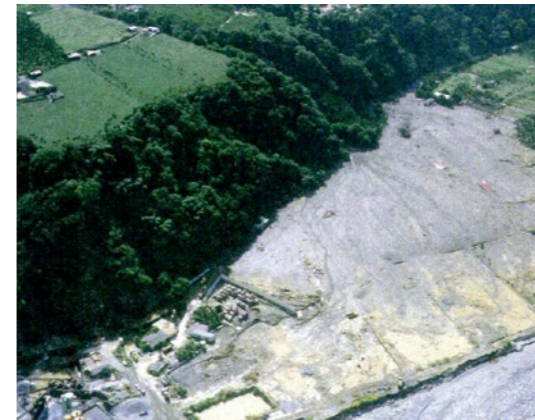
照片8.3.2-6 台21線96K附近路基遭土石流淹沒情形
