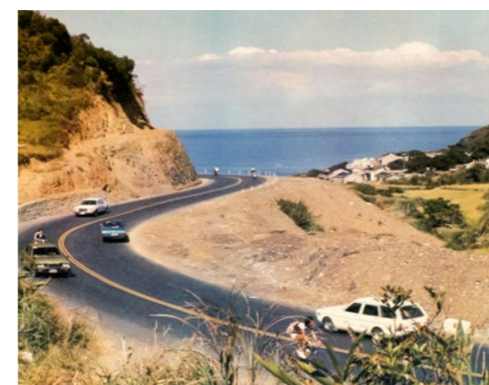
照片5.5.1-7 施工中的北部濱海公路
