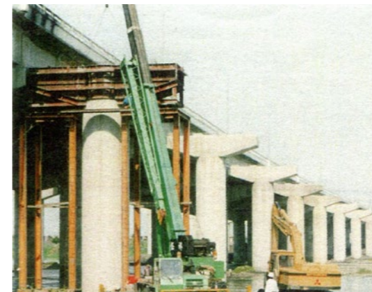
照片6.4.4-28 高雄潮州線高架段施工
