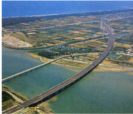
照片7.2.2-1 國道3號中港溪橋
