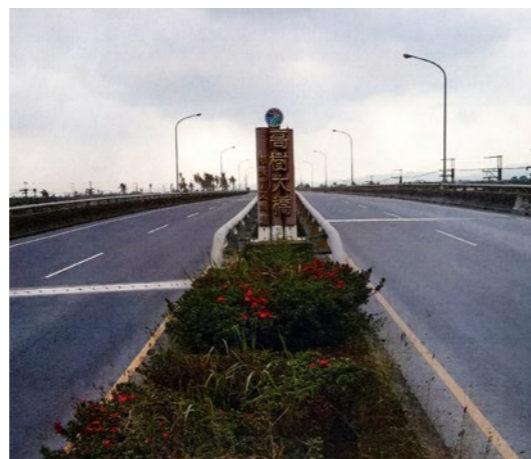
照片5.6.1-17 高樹大橋重建之二
