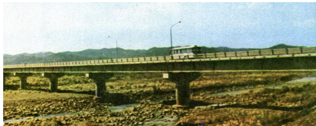
照片5.1.2-32 竹林大橋
