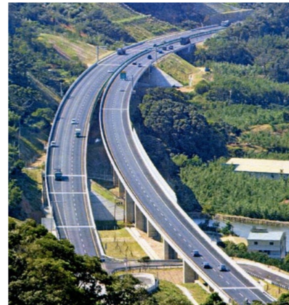
照片6.4.4-6 觀音山隧道西段
