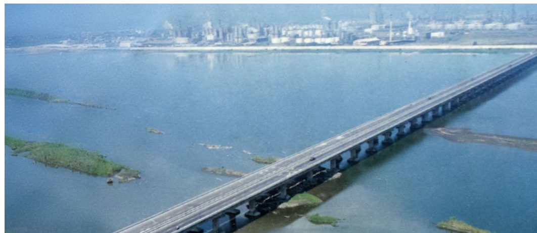
照片5.5.4-6 鳥瞰雙園大橋
