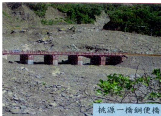
照片8.5.2-11 桃源一橋鋼便橋
