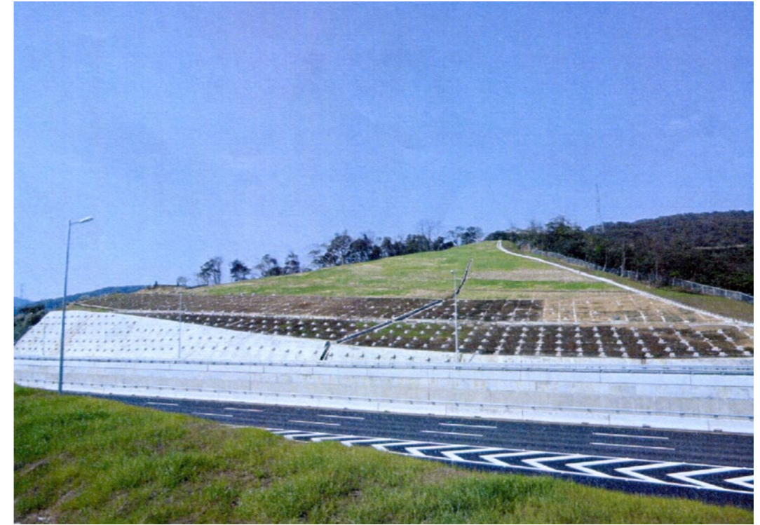
照片8.6.2-5 國道3號3.1K大坍方修復完工
