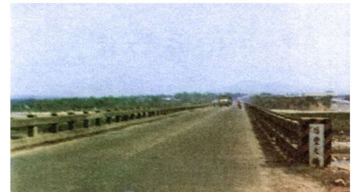
照片 5.1.2-9 后豐大橋(未拓寬前)
