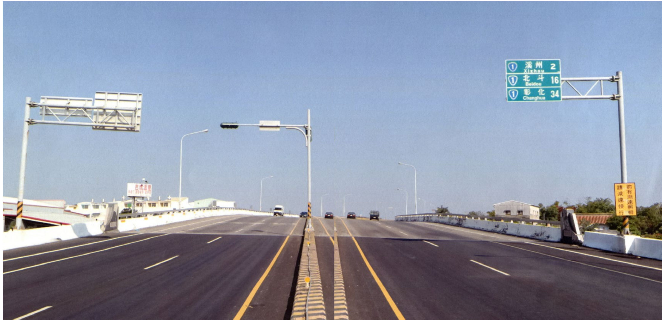
照片5.2.1-12 取代原西螺大橋新建的溪洲大橋
