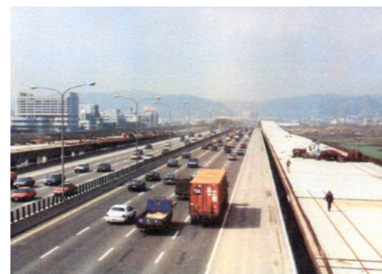
照片7.1.5-5 汐止五股高架拓寬施工
