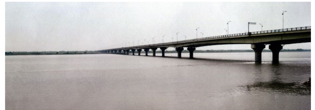
照片5.5.4-8 側看新雙園大橋
