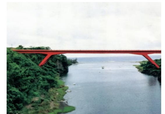
照片5.5.2-6 面海口新東河橋
