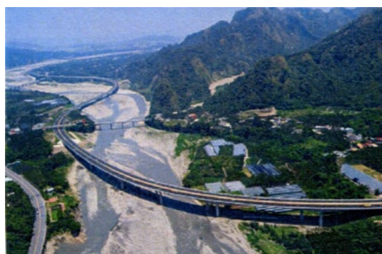
照片 7.4.1-1 國道 6 號石灼高架橋
