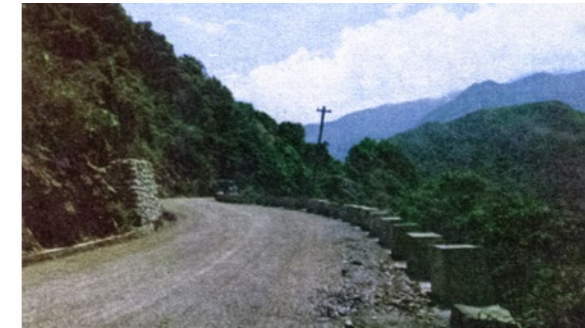
照片5.1.1-18 水門-霧台山地公路
