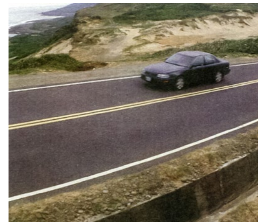
照片5.5.2-3 花蓮縣境內拓寬完成路段
