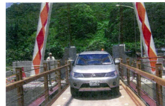
照片8.5.2-3 拉芙蘭吊橋完工試車
