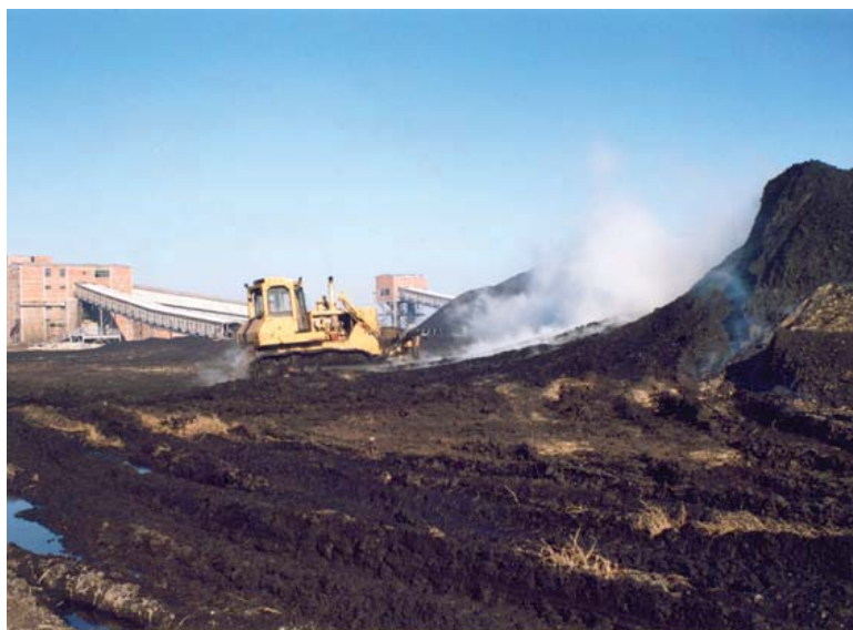
Slika 4.4. Rad buldozera na sabijanju uglja na deponiji
