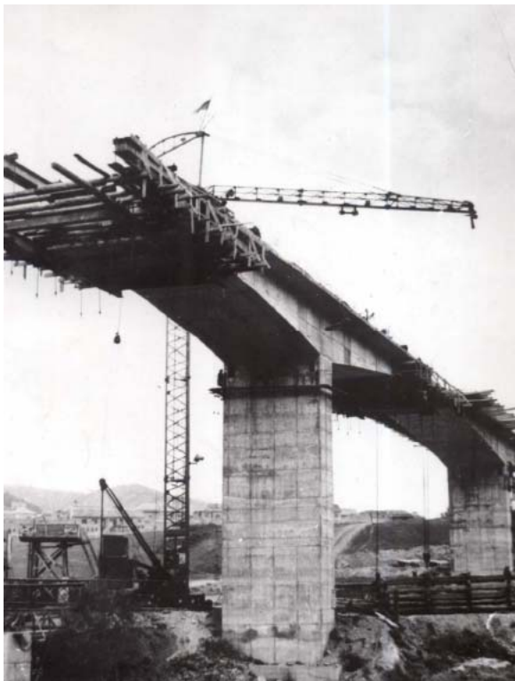
Fig. 9.13 Montaj în consolă la viaductul Cătușa
