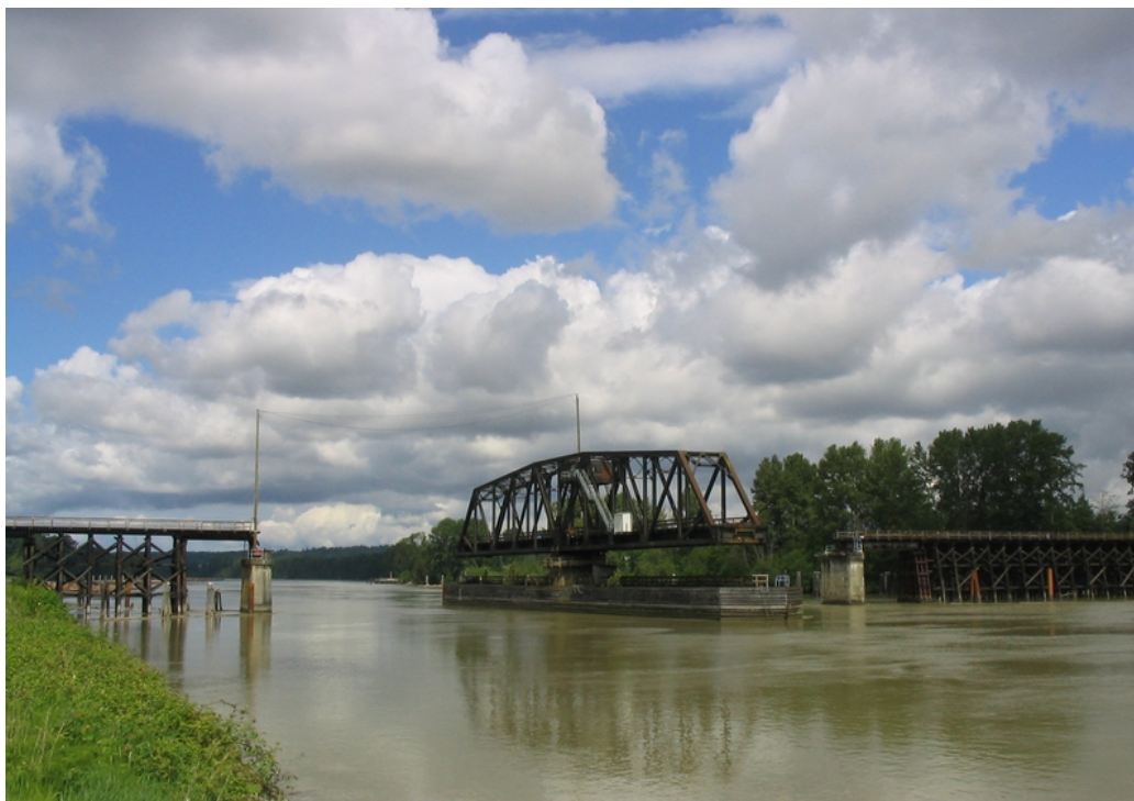
Fig. 6.24 Pod rotitor amplasat în mijlocul unui canal navigabil
