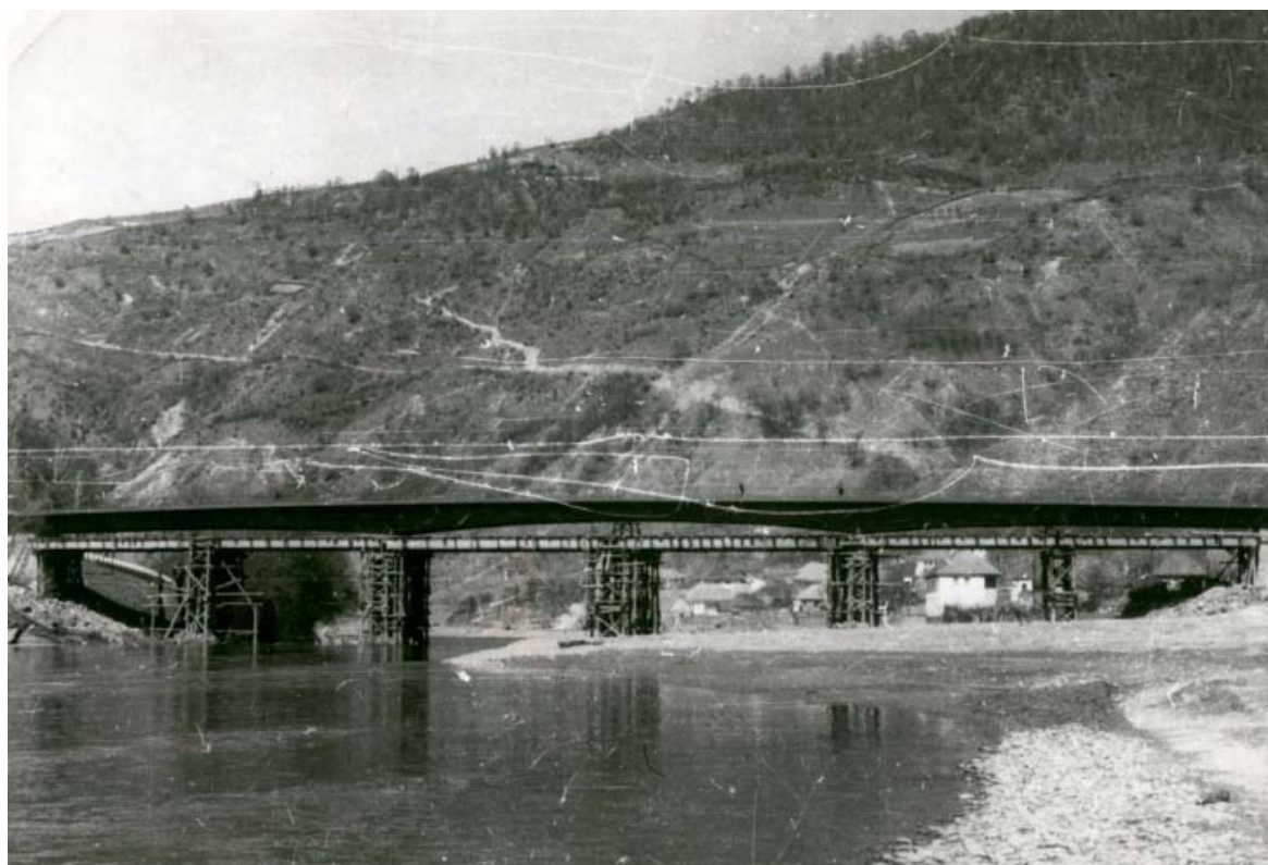
Fig. 9.4 Montarea pe infrastructuri provizorii a podului peste Olt la Căineni
