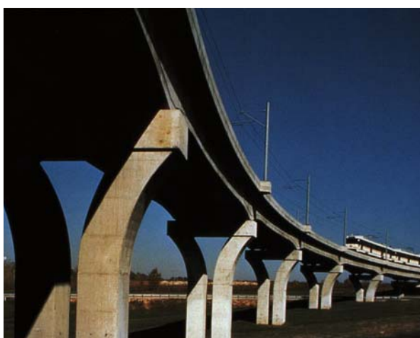
Fig. 3.8 Pile având forma literei “Y”
