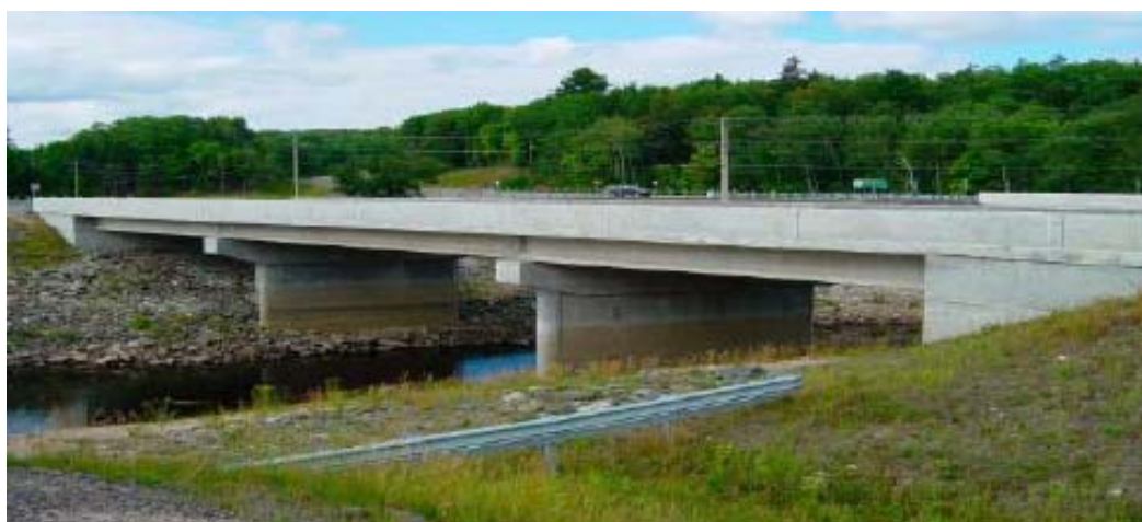
Fig. 3.25 Pod peste râul Big East, SUA, având culeele integrate
