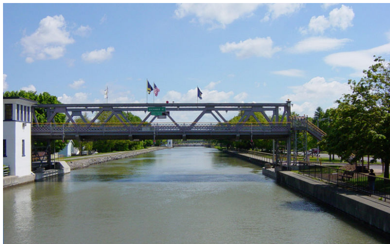
Fig. 6.26 Pod ridicător peste un canal navigabil
