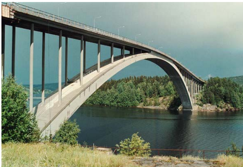
Fig. 1.20 Podul cu arce din beton armat Sandö
