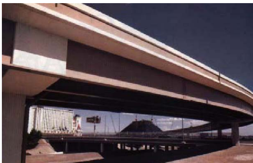
Fig. 3.23 Pile integrate ale pasajului Tropicana, Las Vegas, SUA
