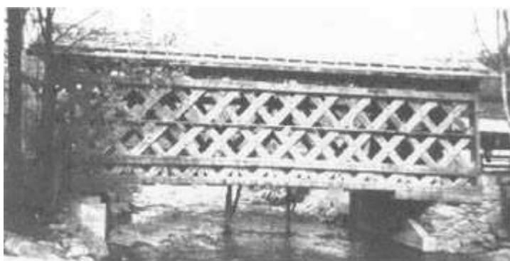
Fig. 1.13 Pod din lemn realizat în sistem Long
