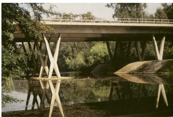
Fig. 3.9 Pile având forma literelor “X” și “V” la viaductul Prater din Viena
