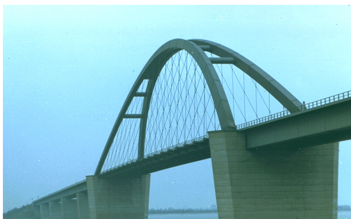
Fig. 6.4 Podul Fehmarnsund din Germania. Pod pe arce cu combinare totală și căi juxtapuse
