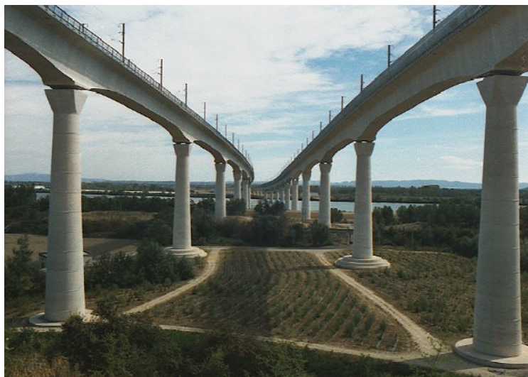
Fig. 5.11 Viaductele Avignon. Suprastructuri cu grinzi continue cu înălțime variabilă
