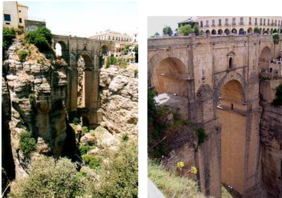
Fig. 1.10 Viaductul roman Ronda din Spania
