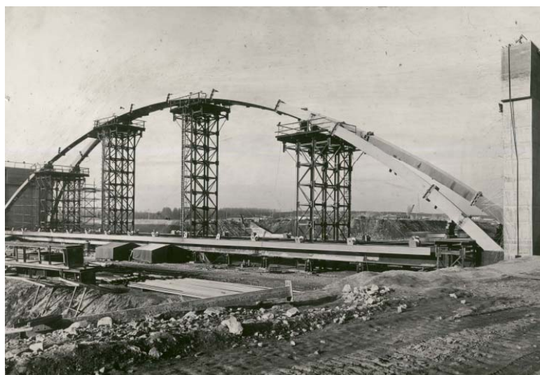
Fig. 9.17 Montaj prin subzidire la podul pe arce metalice de la Basarabi
