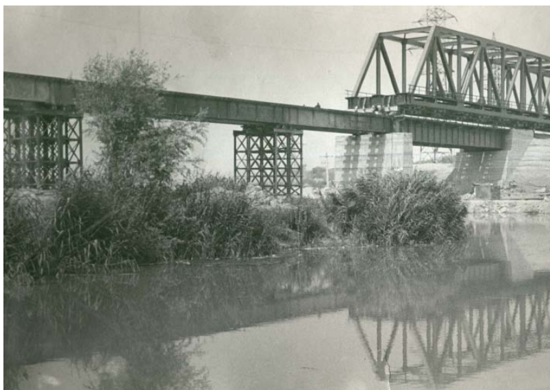
Fig. 9.8 Montaj prin lansare pe cale de lansare la podul de la Nazarcea
