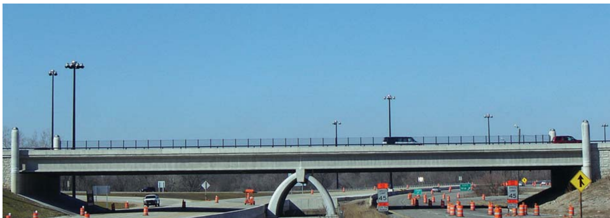
Fig. 3.11 Pilă cu formă specială la un pod de încrucișare
