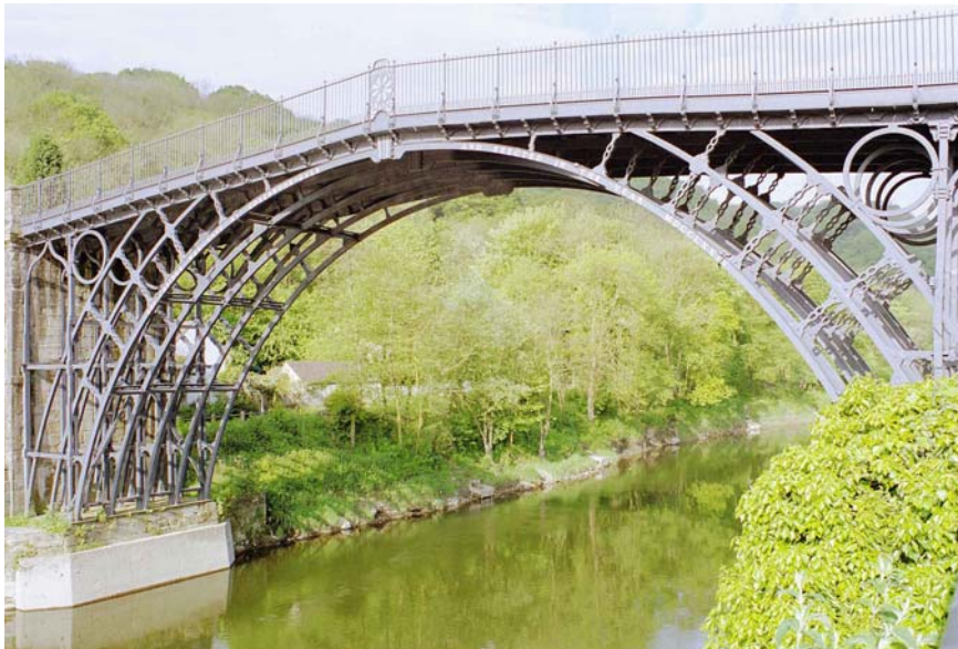
Fig. 1.16 Podul Iron Bridge în localitatea Coalbrookdale, Anglia
