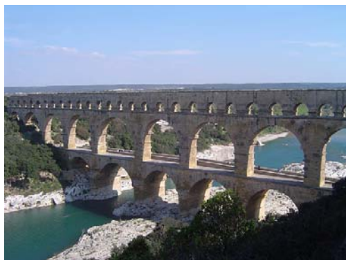
Fig. 1.7 Apeductul roman numit Pont du Gard
