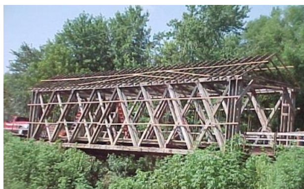
Fig. 1.15 Pod din lemn realizat în sistem Howe
