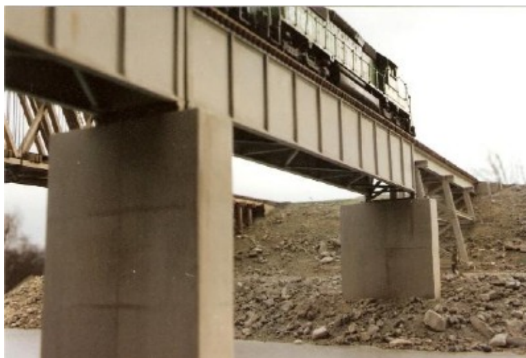
Fig. 5.10 Pod cu suprastructura cu grinzi simplu rezemate cu înălțime constantă
