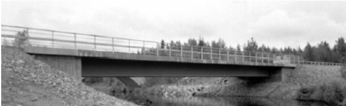
Fig. 3.27 Pod în Suedia având culeele integrate
