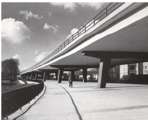
Fig. 3.7 Pile tip cadru cu doi stâlpi înclinați
