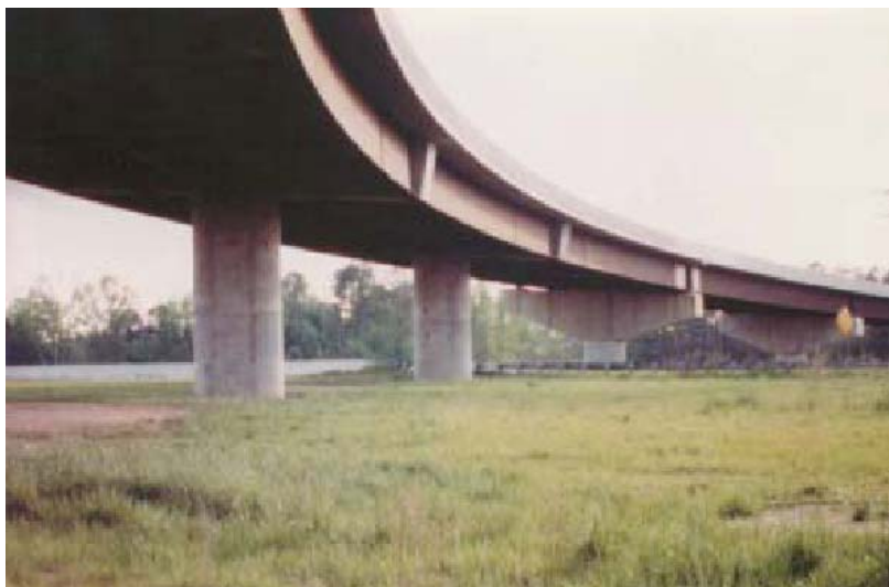
Fig. 3.24 Pile integrate la un pod pe o autostradă în Carolina de Nord
