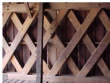
Fig. 1.13 Pod din lemn realizat în sistem Long
