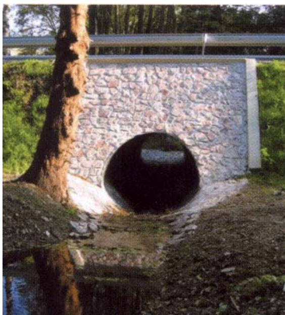
Fig. 2.9 Podeț din tablă zincată ondulantă ce susține un drum
