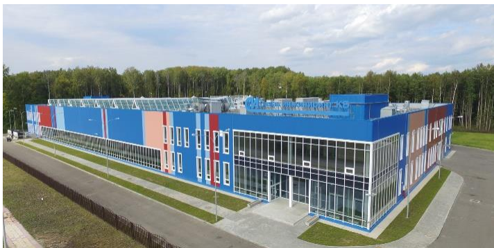
ООО «СВЯЗЬ ИНЖИНИРИНГ КБ»
