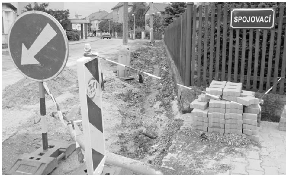
Stavební práce na rohu Spojovací a Okružní. Foto: M. Dřtina
