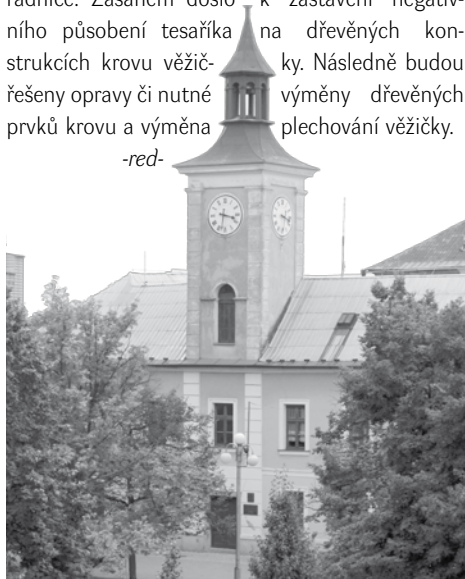
Věžička po ošetření termosanací.
