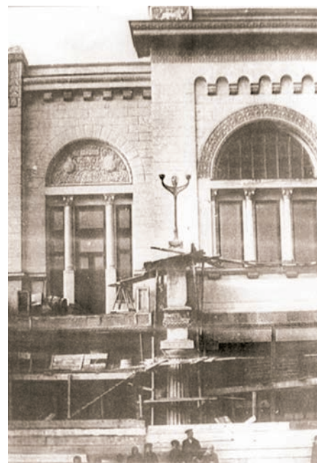
Левый фланг здания ОВК. Процесс восстановления ризалитов. Фото 1911 г.
