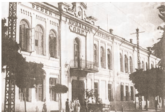
Дом городской управы на улице Пушкинской, где в 1910 г. начинал работу Симферопольский ГОБ
