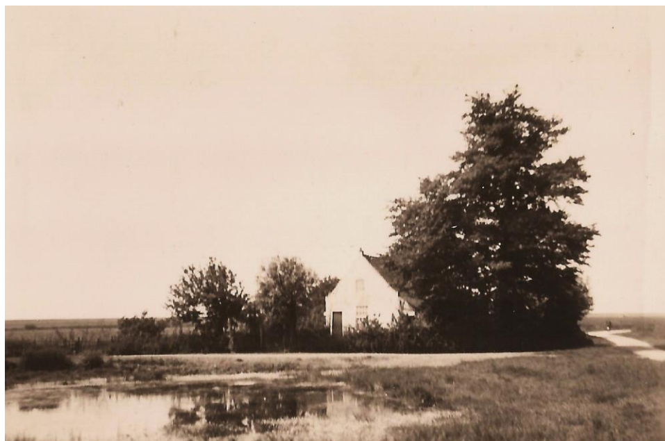
Foto 1935-1938. Huis Schakerloo nr. I 15. Huis afgebroken 1948. Rechts de Schokweg, omstreeks 1955 verwijderd.
