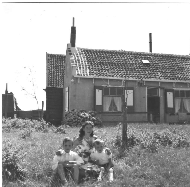
Foto Fam. Braal ca. 1960. Huis en schuur Schakerloo 20 / sinds 1968 Oudeland 1.
