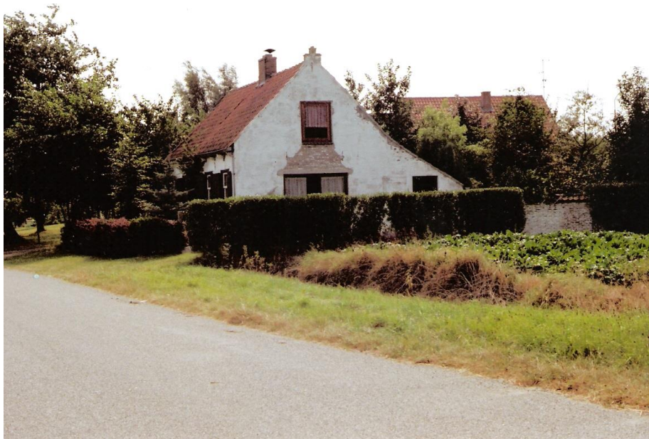
Foto Fam. Verkerke. Schakerloopolder 7 / Oudlandsedijk 16 huis afgebroken en vervolgens nieuwbouw.
