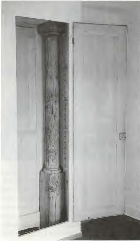
Versteckt in Wohnzimmerschränken standen bis zuletzt die tragenden Holzsäulen der alten Schulstuben.
