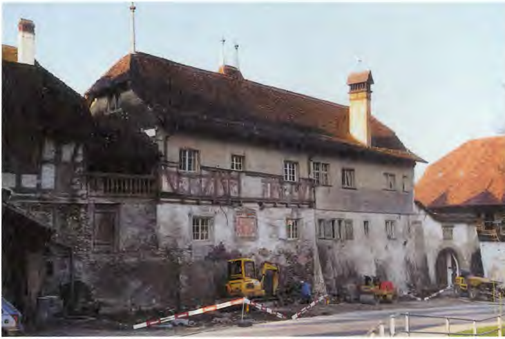
Oben: Die Aussenseite des Schlosses, wie sie nach der Entfernung der Scheune und der Bühne zum Vorschein kam, trägt die Spuren mehrerer ganz unterschiedlicher Fassadengestaltungen. Rechts im Bild der Tor- eingang von 1569.
