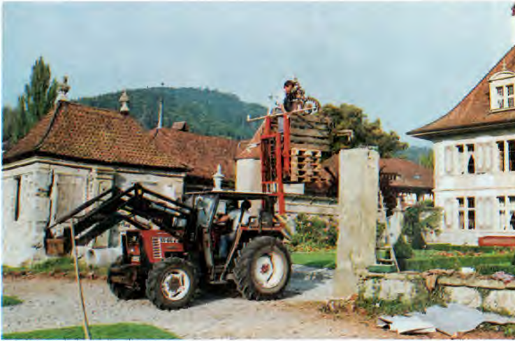
Oben: Renovationsarbeiten an der Eingangspartie, Herbst 2000.
