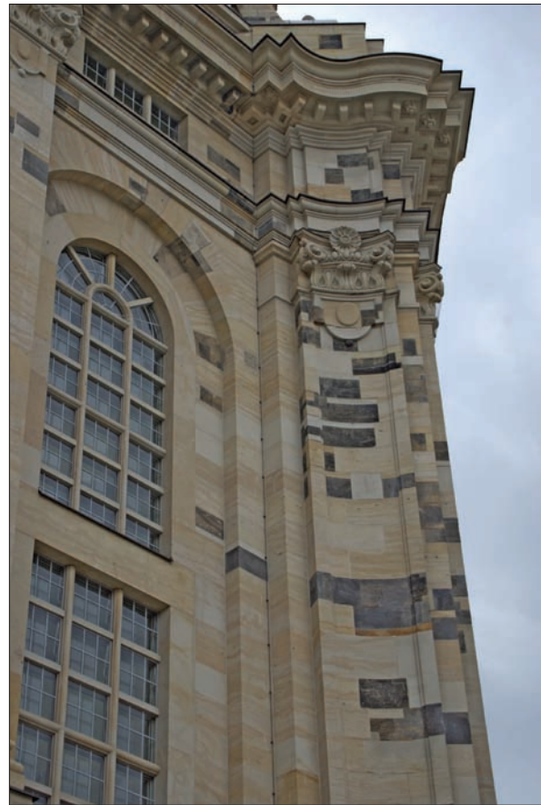
Abb. 17: Mauerwerk der Frauenkirche mit „patinierten“ Altsteinen und hellen bruchfrischen Neusteinen.
