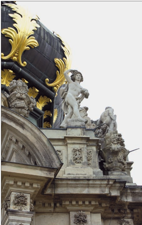
Abb. 16: Figur vom Kronentor des Zwingers, die bereits 1990/91 mit Silikonharzfarbe gestrichen worden war.
