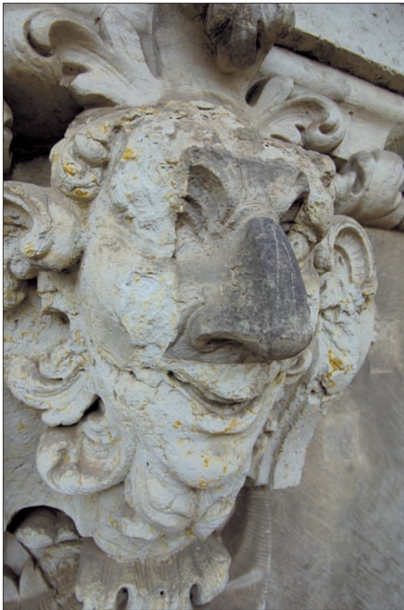
Abb. 14: Verwitterte Faunfigur von der Bogengalerie M des Zwingers mit Ergänzung aus der Zeit der vierten Zwingerrestaurierung.
