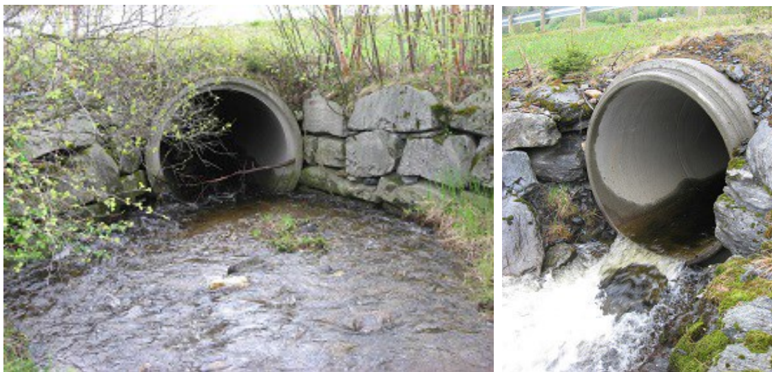
Figur 8. Kulvert under FV 30 i Remna. Foto. Statens Vegvesen.
