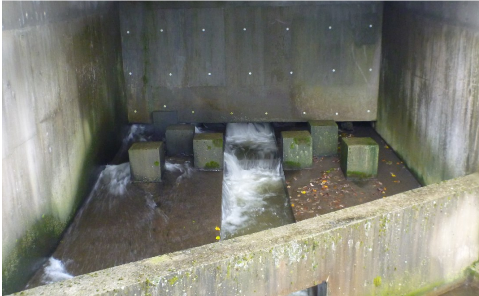
Figur 47. Kulvertutløp nedstrøms Fv 950 (Nr. 87) i Vikhammerelva. Foto: Morten Bergan.
