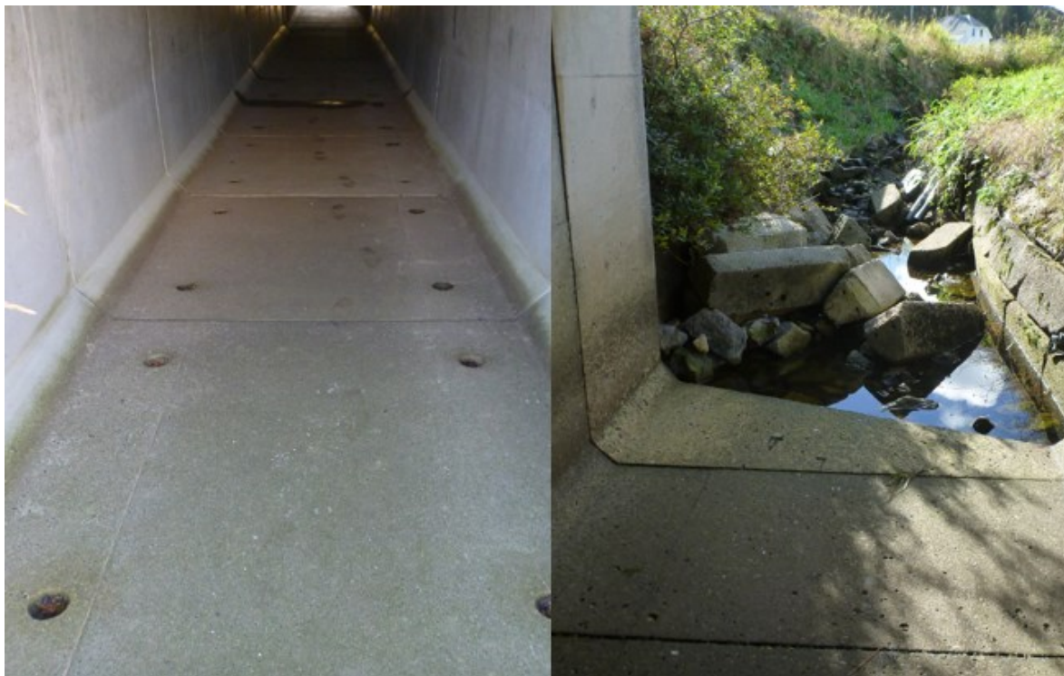
Figur 100. Kulvert under Fv 714 i Ervikelva. Foto: Morten Bergan.
