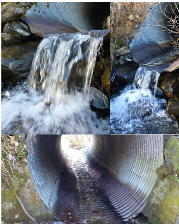
Figur 58. Veikrysning under Fv 65 i Myrhaugbekken. Foto: Morten Bergan.
