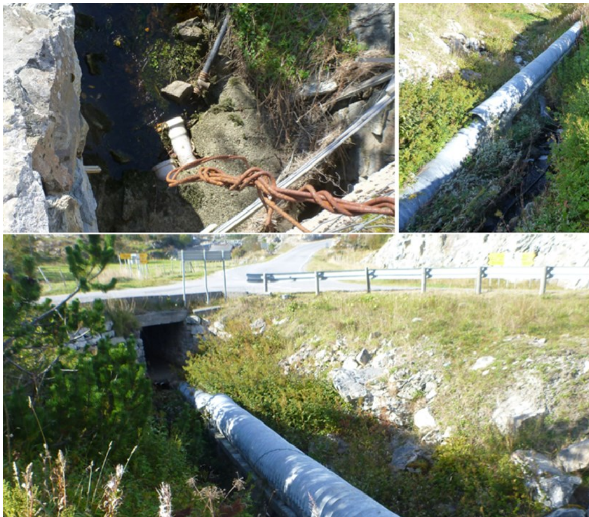
Figur 78. Veikulvert under Fv 411 i Hallarelva. Foto: Morten Bergan.
