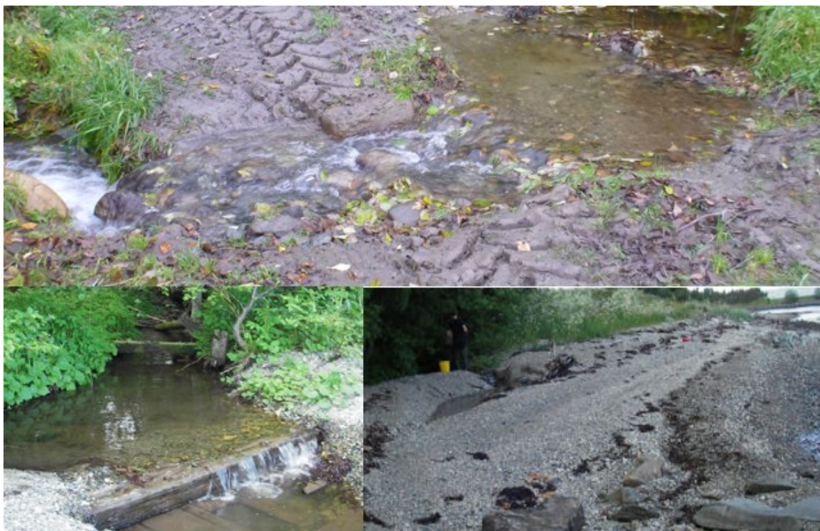
Figur 23. Traktorvei rett over bekken (øverst), trebjelke på tvers (nederst t.v.) og avsnørt utløp fra sjøen (nederst t.h.; vannet renner under bakken på middels og lav vannføring) gjør oppgangsforholdene i Grøsetbekken varierende og sterkt vannføringsavhengig også nedstrøms Fv 707. Foto: Morten Bergan.
