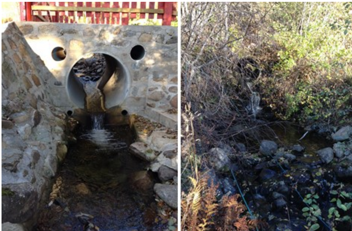
Figur 55. Veikrysning under Fv 926 i Kvernbekken (t.h.), og kulvert under privat veikrysning (t.v.). Foto: Hans Mack Berger.
