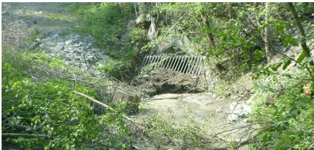
Figur 3. Innløp til kulvert under Fv 707 i Søra. Foto: Morten Bergan.
