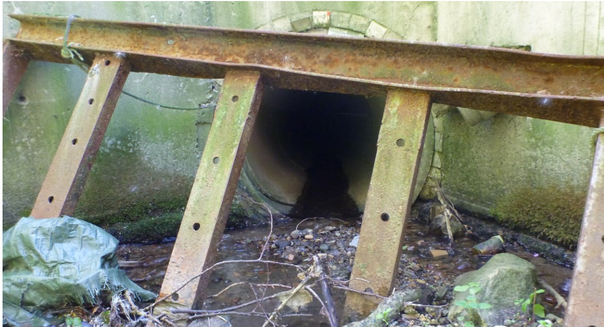
Figur 41. Overside (innløp) av kulvert under Fv 707 i Elsetbekken. Foto: Morten Bergan.
