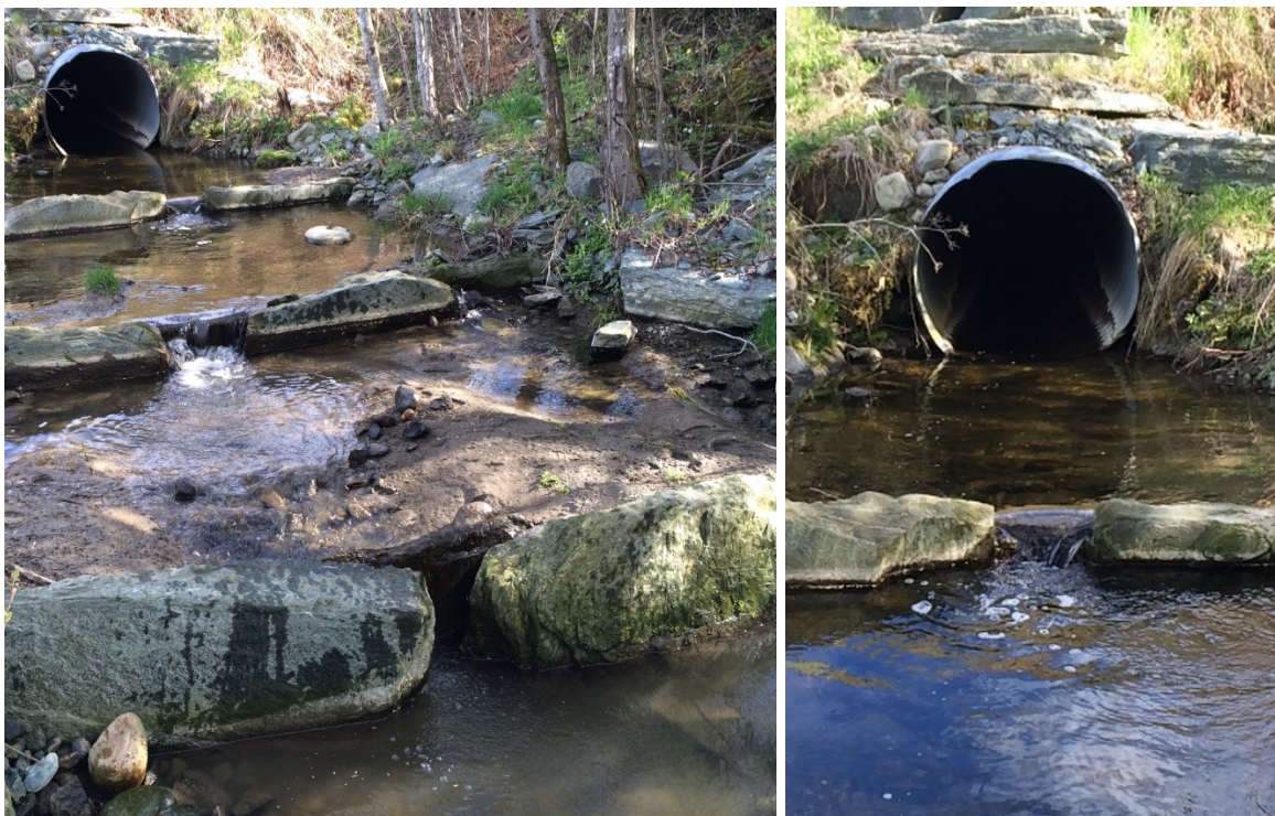
Figur 19. Alle terskler og kulvertutgang ved befaring i mai 2015. Foto: Morten Bergan.
