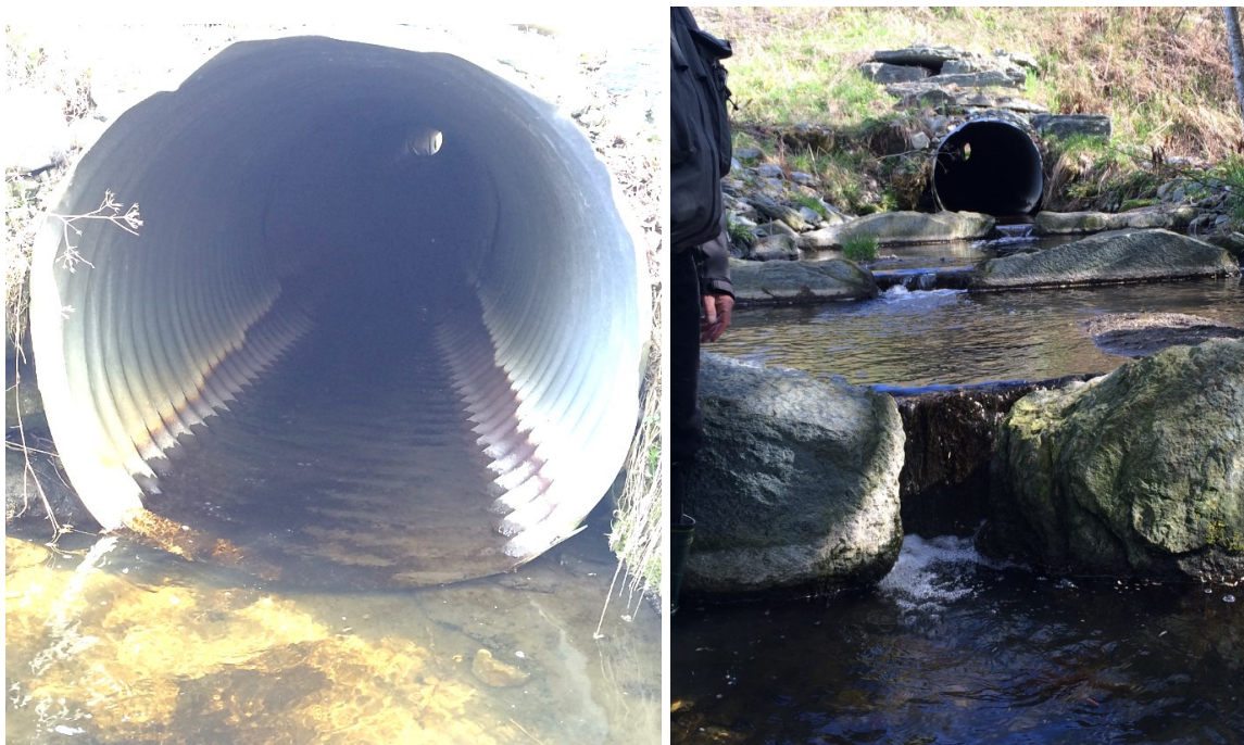
Figur 20. Kulvert ved befaring i mai 2015 (t.v.) Enkel inngang for oppvandrende fisk nedstrøms fylkesveien, men noe brattere stigning fra midtveis i kulverten og opp mot kulvertinngang ovenfor veien, som gir lavere vanddybde og høyere vannhastighet over et ukjent antall meter. Uavklart status, men potensielt vandringshindrende eller -stoppende. Foto til høyre viser terskler opp mot kulvert i mai 2015. Foto: Morten Bergan.
