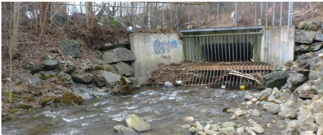
Figur 45. Vikelva ned mot kulvert under Ev 6. Oppstrøms Ev 6. Foto: Morten Bergan.
