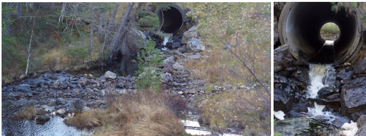
Figur 77. Veikulvert under Fv 381 i Merkesåa. Foto: Morten Bergan.
