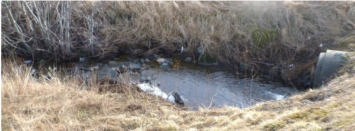
Figur 79. Foto av kulvertutløp og kulp nedstrøms Fv 710. Foto: Morten Bergan.
