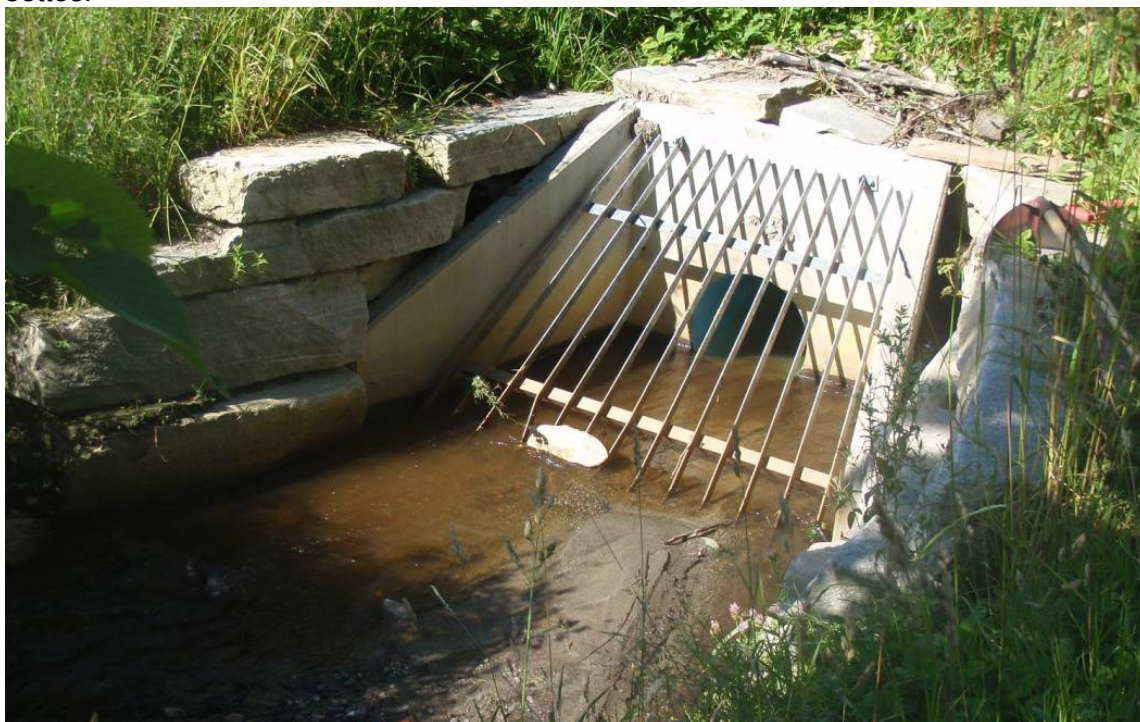
Figur 30. Inngang til veikulvert under EV 6 i Storvassbekken til Lundesokna. Foto: Morten Bergan.
