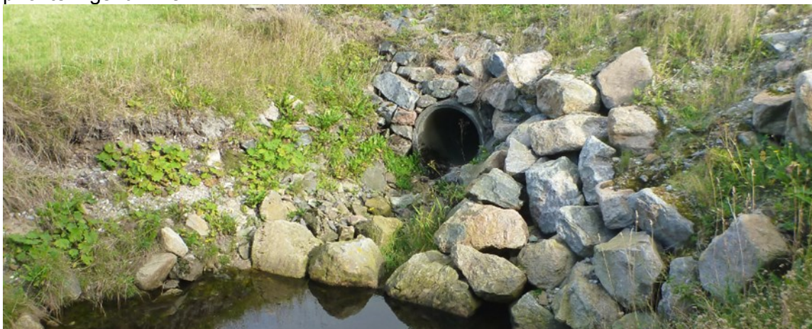
Figur 92. Veikrysning under FV 716 i tilløpsbekk til Litlvatnet/Littljønna. Foto: Morten Bergan.
