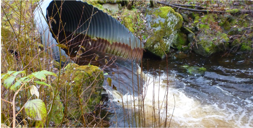
Figur 71. Kulvert under Fv 721 i Okla, på vannføring som antas å være fiskeførende for denne veikrysningen. Foto: Morten Bergan.
