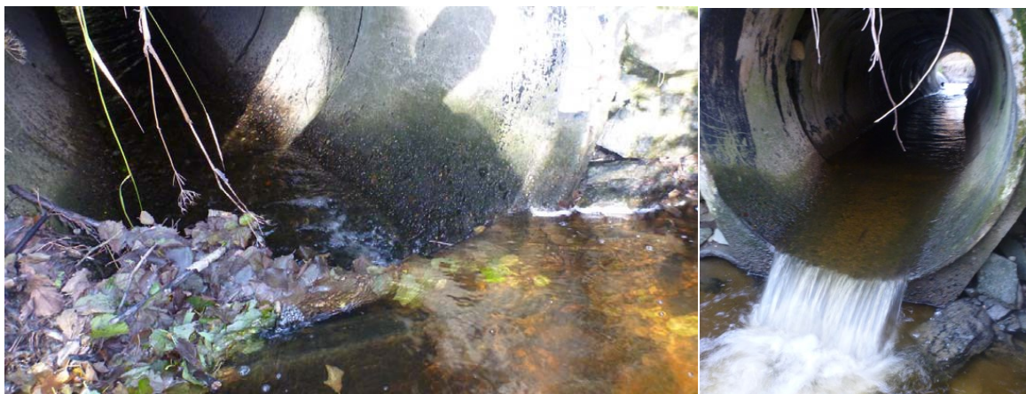
Figur 64. Gjentettet kulvertinngang som medfører høydeforskjell ved inngangen til veikrysning nr.17 under Fv 231 i 2013 (t.v.), men fjerning av trestamme og annet trevirke ga tilfredsstillende vandringsmuligheter gjennom kulverten i 2014. Foto: Morten Bergan.
