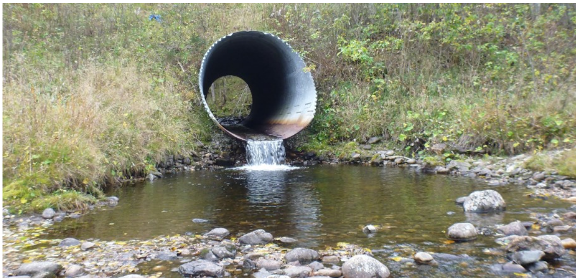
Figur 36. Kulvert under Fv 30 i Plassbekken. Foto fra nedsida av veikulverten. Foto: Morten Bergan.
