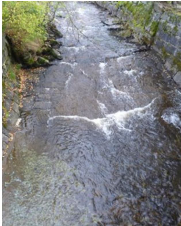
Figur 10. Flate steinheller lagt i elvebunnen under brukrysning ifbm Fv 633. Foto: Morten Bergan
