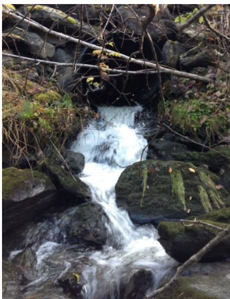
Figur 51. Kulvert under Fv 941 i Fjølstadbekken, en sidegrein av Vikhammerelva. Foto: Morten Bergan.
