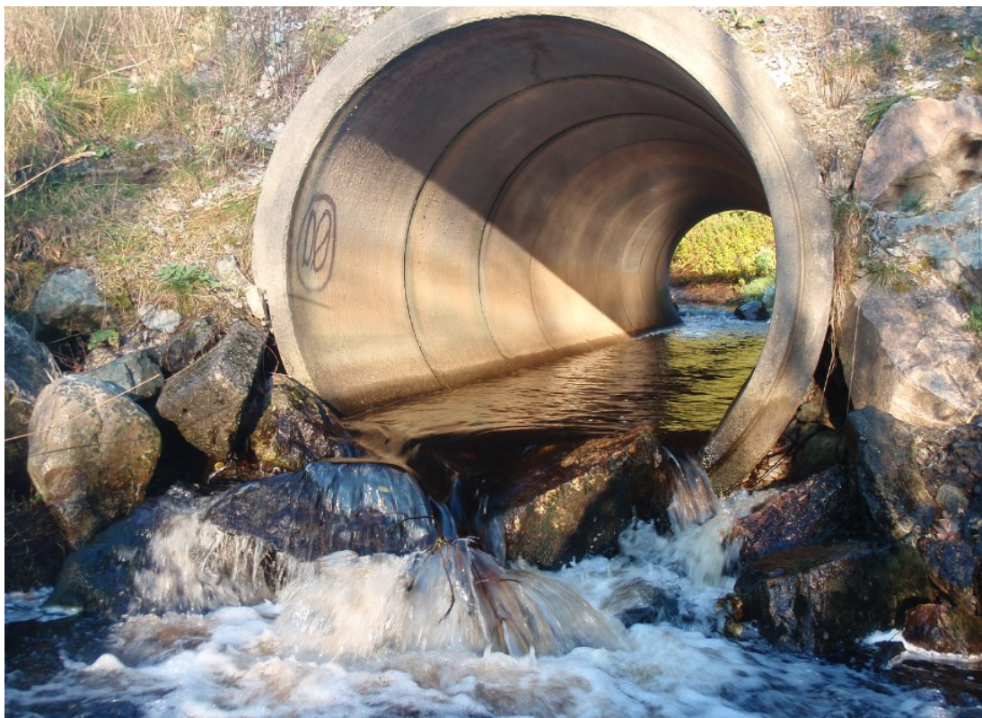
Figur 75. Veikulvert under Fv 714 (nr. 56) i Sandstadelva. Foto: Morten Bergan.
