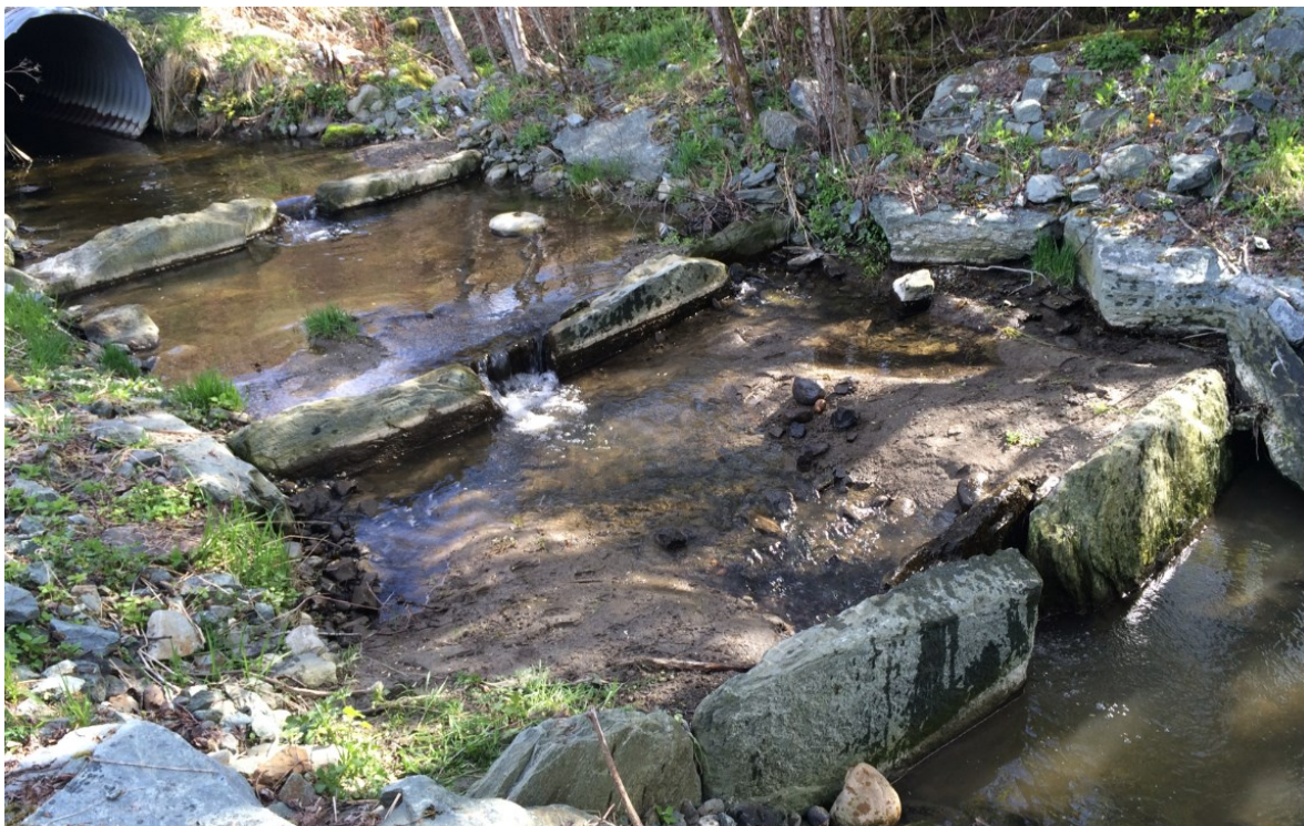
Figur 18. Alle terskler ved befaring i mai 2015. Foto: Morten Bergan.
