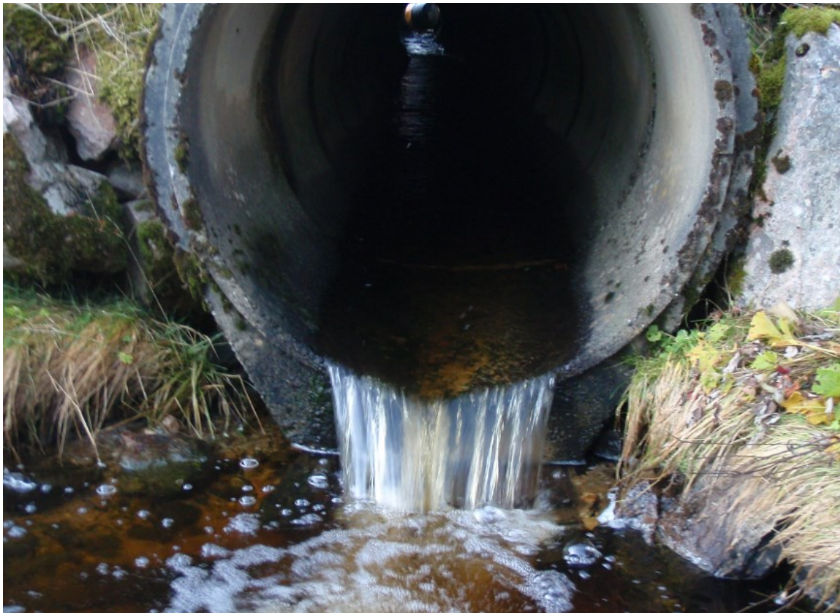
Figur 90. Kulvert under Fv 714 i Leirvågbekken. Foto: Morten Bergan.
