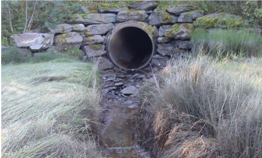
Figur 24. Veikulvert under E39 i 2007. Foto nedstrøms veien. Foto: Morten Bergan.
