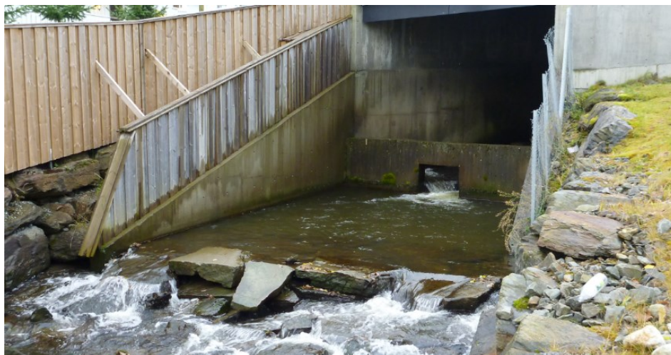
Figur 46. Kulvertutløp nedstrøms Fv 950 (nr. 87) i Vikhammerelva. Foto: Morten Bergan
