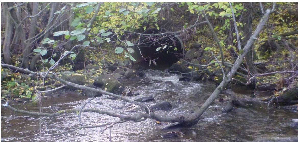
Figur 57. Grilstadbekken går i bakken gjennom en rekke kulvertløsninger fra den går i bakken ved Brundalen og åpen igjen (bildet) om lag 70 meter før munning i Trondheimsfjorden; en strekning på rundt 1,5 kilometer i luftlinje. Foto: Morten Bergan.
