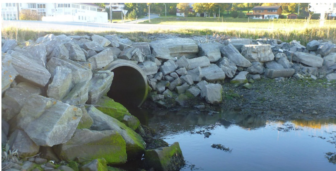
Figur 97. Utløp til sjø i kulvert i Selvabekken. Foto: Morten Bergan.
