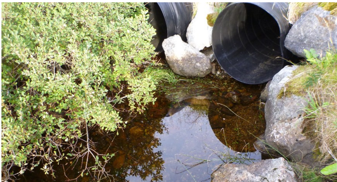
Figur 104. Kulvertkrysning under Fv 716 i utløpsbekken fra Tuvnesvatnet.
