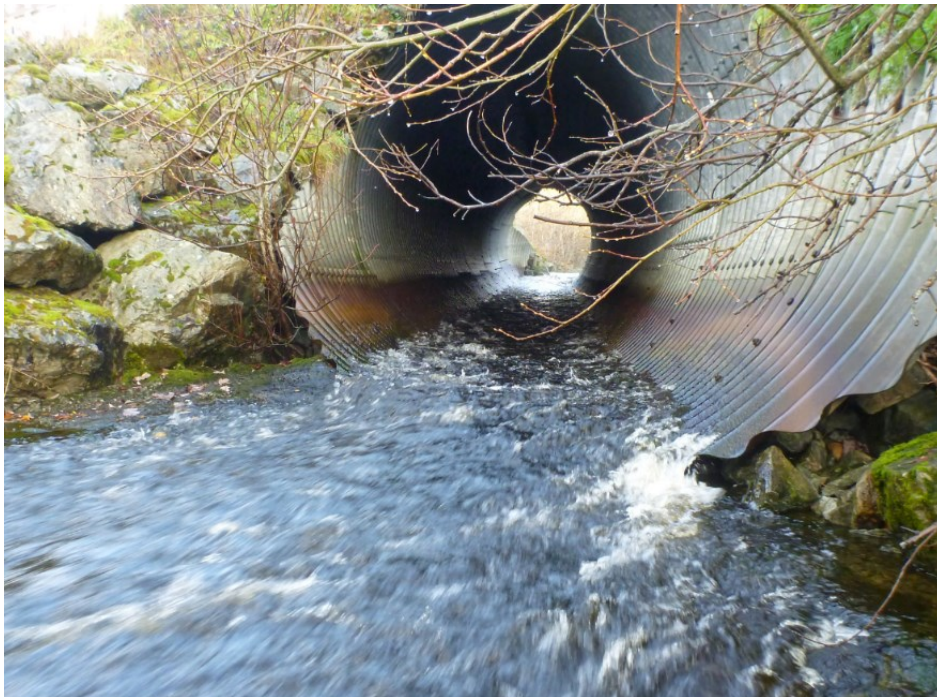
Figur 68. Kulvert under Fv 710 i Botnelva. Foto: Morten Bergan.
