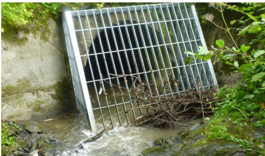
Figur 32. Inngang til veikulvert under Ev6 i Langbekken. Foto: M.Bergan.
