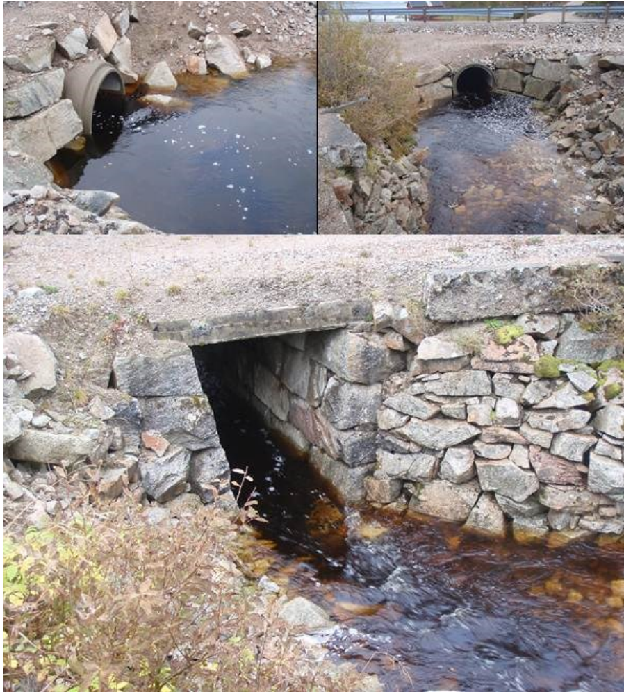
Figur 85. Kulvert under Fv 713 (over) og privat veikrysning (under). Foto: Morten Bergan
