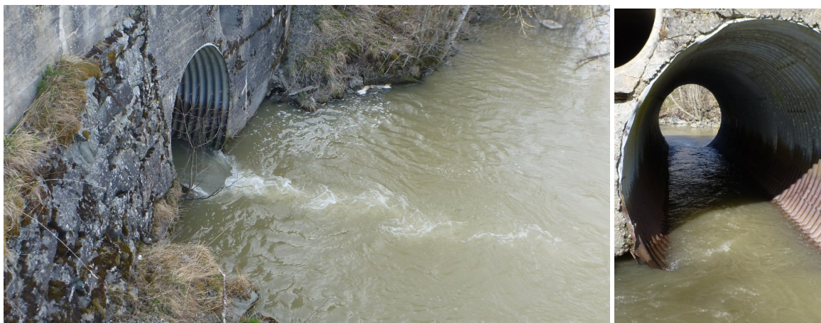
Figur 43. Amundbekken og kulvert like før munning til Nidelva når Nidelva går på høy vannføring. Foto: Morten Bergan.
