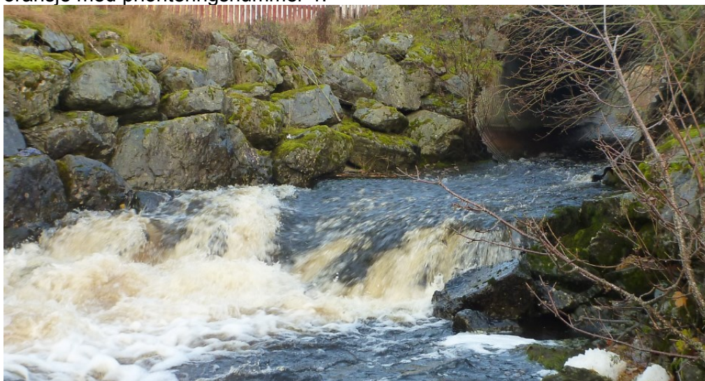
Figur 67. Kulvert under Fv 710 i Botnelva. Botnelva med høy vannføring på fototidspunktet. Foto: Morten Bergan.
