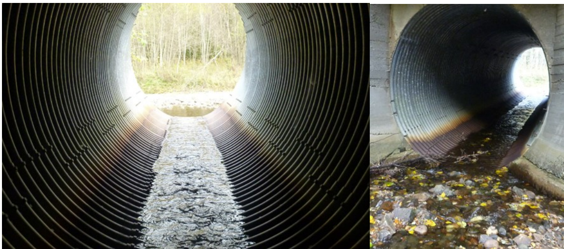
Figur 35. Innside ned mot utløp (t.v) og innløp (t.h.) ovenfor veien i kulvert under Fv 30.
