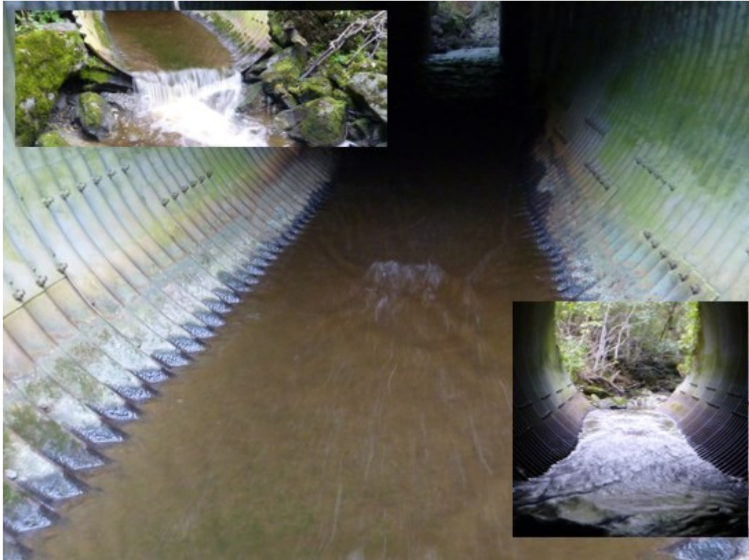
Figur 31. Veikryssing under gamle Ev6 i Ratbekken. Foto: Morten Bergan.
