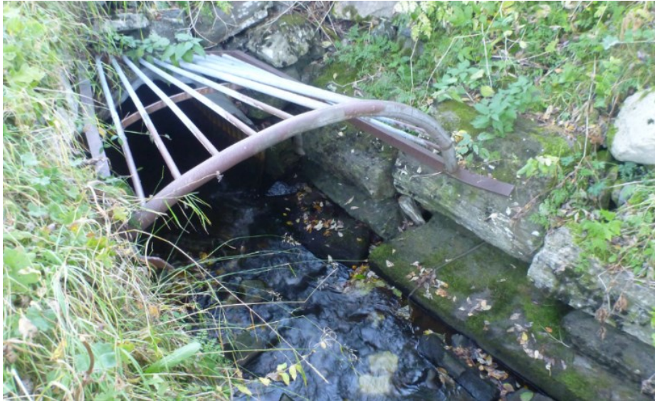
Figur 98. Inngangskulvert til lukket strekning oppstrøms Fv 710 i Selvabekken. Foto: Morten Bergan.
