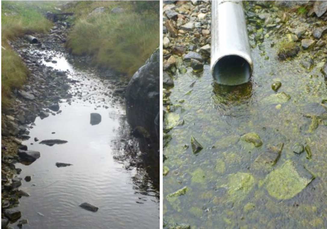
Figur 102. Veikrysning under Fv 410 i bekk i Innervågen. Foto: Morten Bergan.
