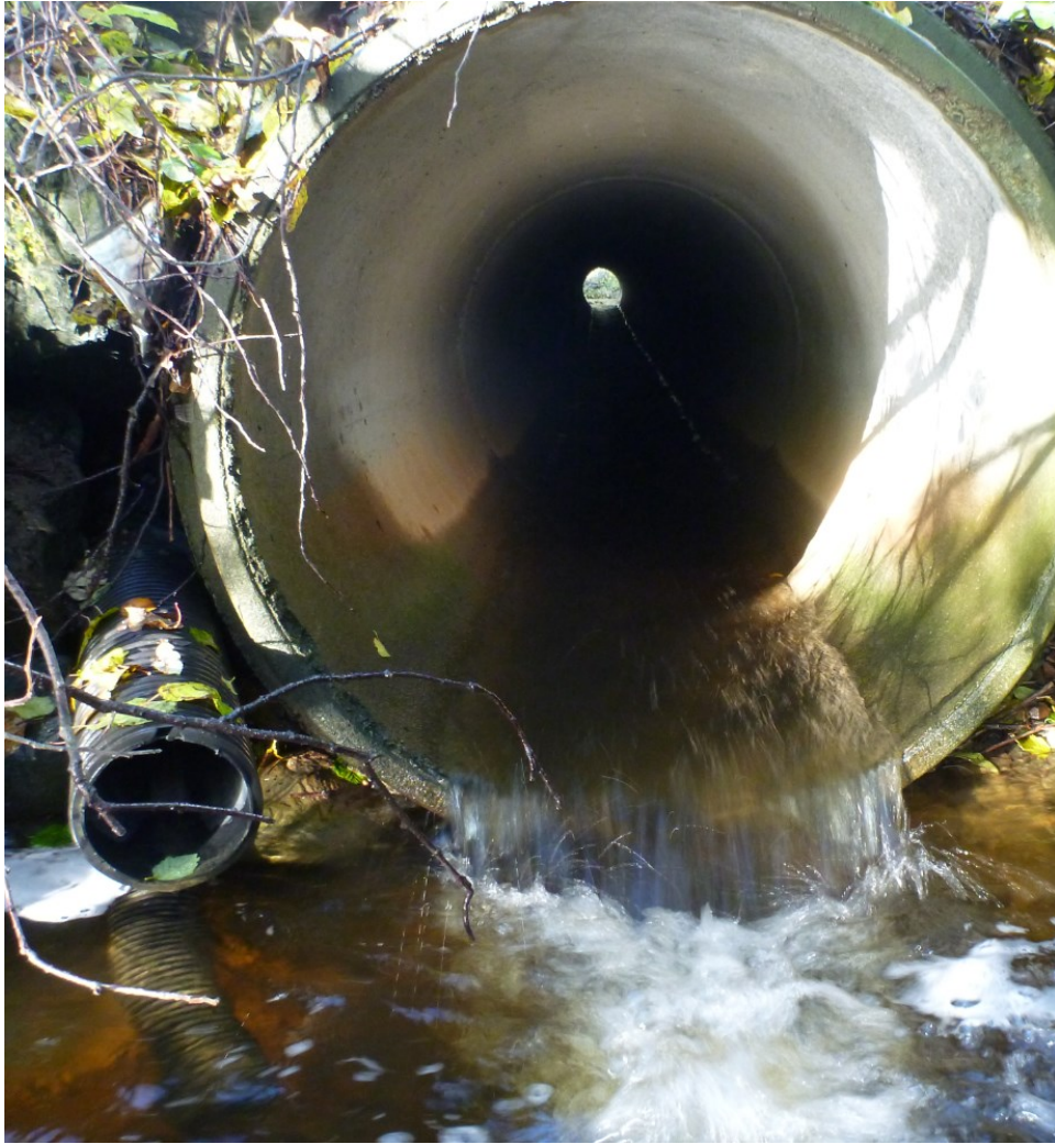
Figur 74. Veikulvert under Fv 201 i Bliksåsbekken. Foto: Morten Bergan.
