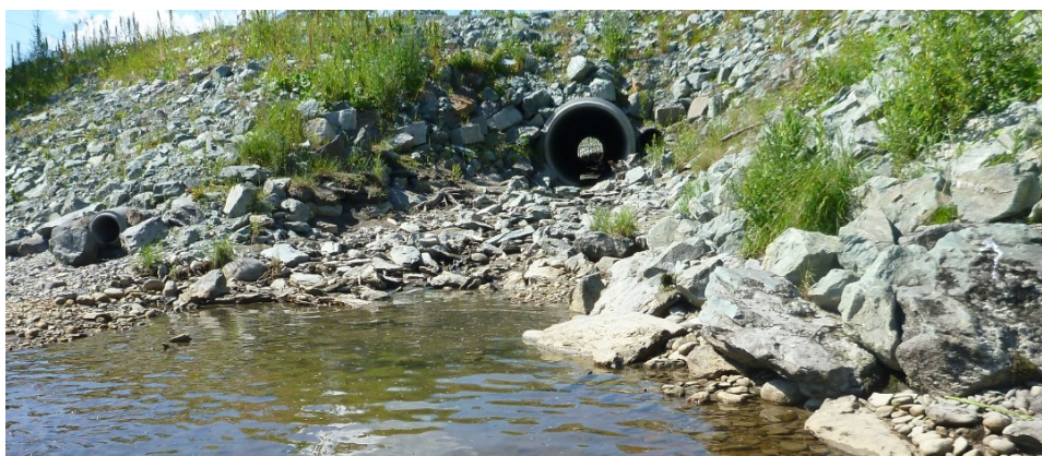
Figur 28. Nylige inngrep, i form av veiutfylling, kulvert og utretting/steinsetting ved Fv 735, har umuliggjort oppgang av sjøørret til Varmbubekken. Foto: Morten Bergan.
