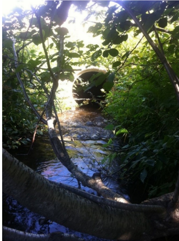
Figur 6. Kulvert under Fv 30 ser fiskeførende ut ved inn- og utgang, og det er påvist godt med ørret og flere årsklasser oppstrøms oppstrøms kulverten. Kulverten er lang og kan potensielt være vandringsstoppende på lave vannføringer eller ved gjentetting med kvist og skrot. Foto: Morten Bergan.
