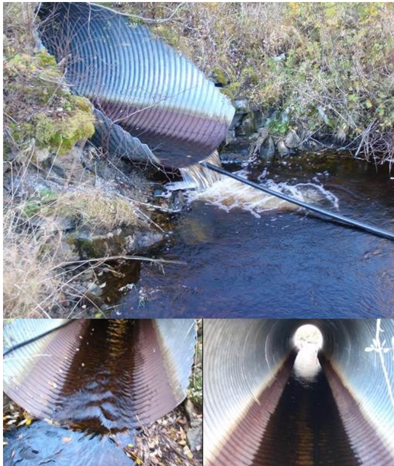
Figur 91. Veikulvert under Fv 714 i Fauslandsbekken. Foto: Morten Bergan.
