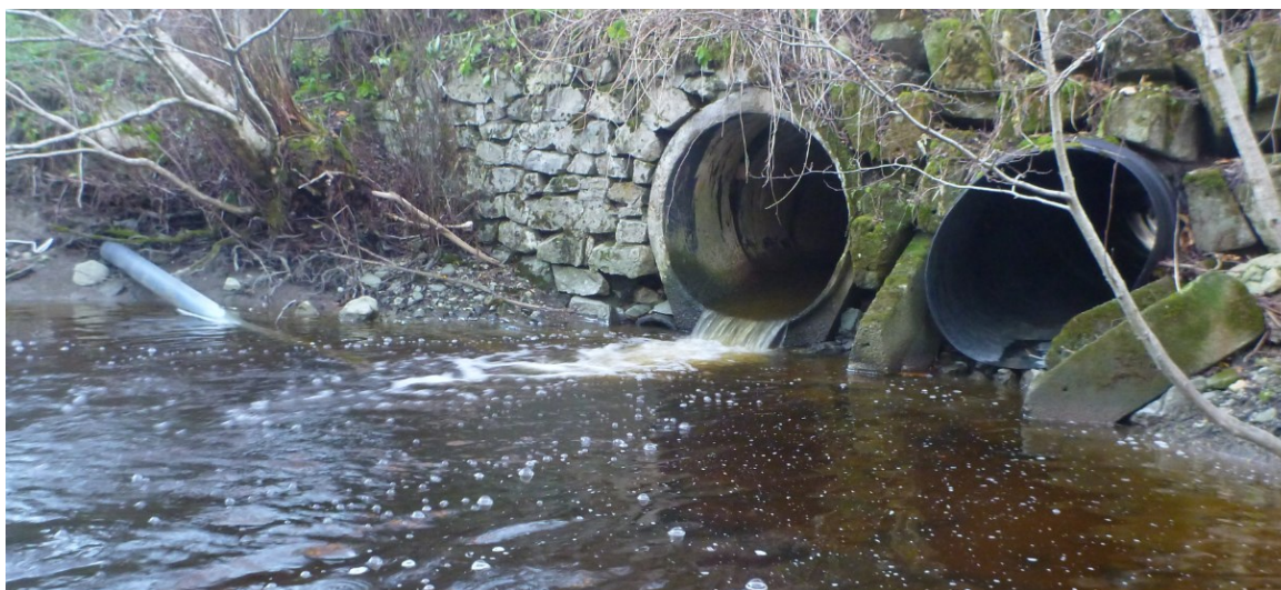
Figur 63. Utløp kulvert under Fv 231 (veikrysning nr.17) i 2014. Foto: Morten Bergan
