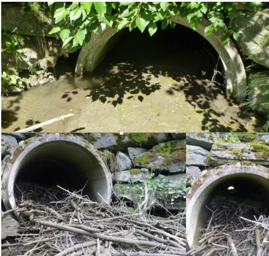
Figur 25. Veikulvert under E39 i 2014. Foto oppstrøms (øverst) og nedstrøms (nederst). Foto: Morten Bergan.
