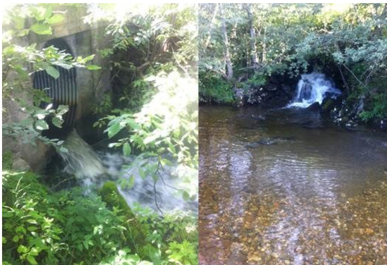
Figur 7. Kulvert under FV 30 i Havsbakkbekken. Foto: Morten Bergan.
