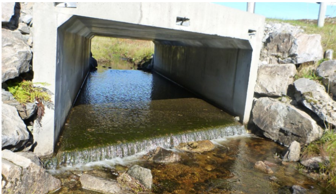
Figur 93. Veikrysning under Fv 716 i Stutvasselva på normal vannføring. Foto: Morten Bergan.
