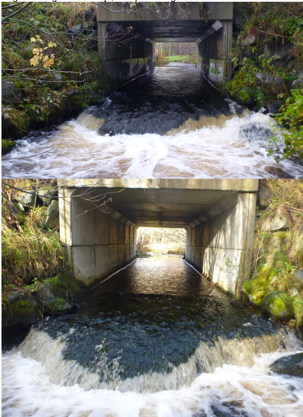
Figur 66. Veikrysning under Fv 231 i Eidselva på liten flom og gunstig vannføring for forbivandring av sjøørret (øverst), og middels vannføring (nederst). Vannføringer lavere enn middels vi gi større forbivandingsproblemer for sjøørret på denne strekningen av elva, som opprinnelig har lett vandringsvei for både laksefisk og ål. Foto: Morten Bergan.
