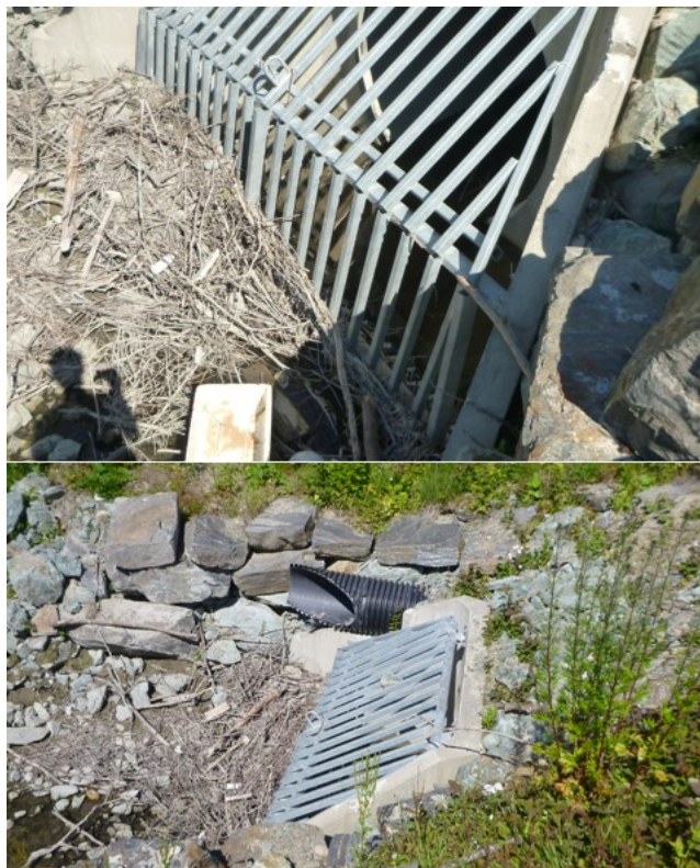
Figur 29. Tett rist foran inngangen til kulverten under Fv 735. Foto: Morten Bergan.
