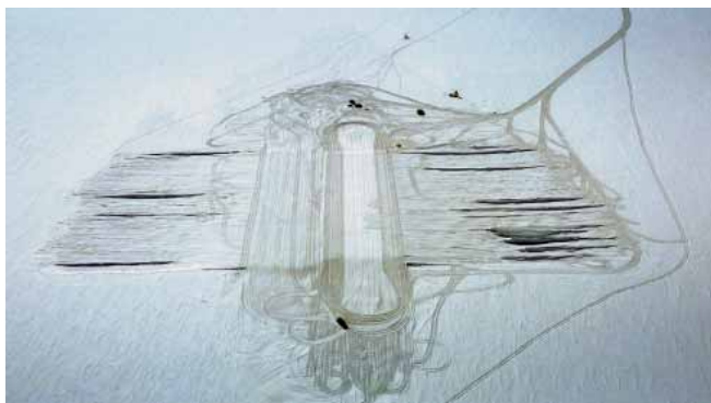
Уплотнение площадки под строительство НЗК Восток. Фото К.А. Овчинникова
