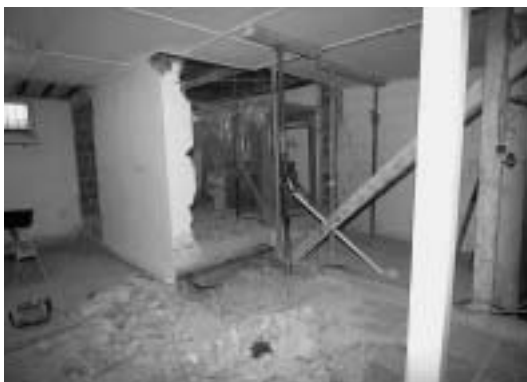
Rekonstrukce výtahu. Foto V. Komasová
