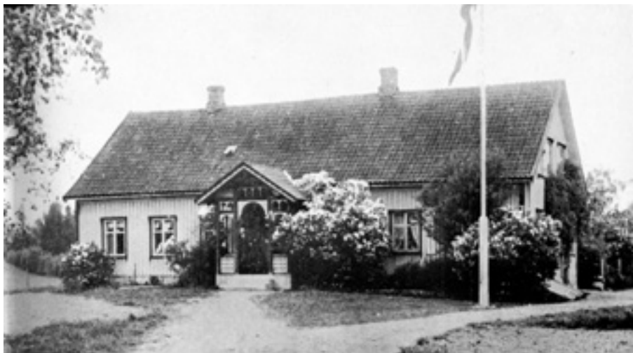
Aas skole- og herredsstyre holdt til i denne bygningen på Brønnerud, oppført i 1849.
