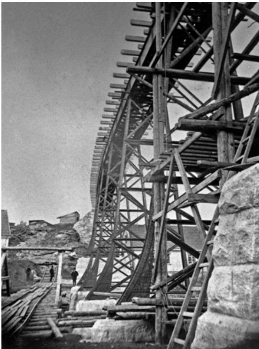
Hølen viadukt ble opprinnelig ikke bygd som pendelpilarbro. Pilarbena på kurvens yterside hadde en markert svai nederst. Pilarfoten manglet bevegelig ledd og var i stedet boltet fast til fundamentet. (Foto: JMF 8838).
