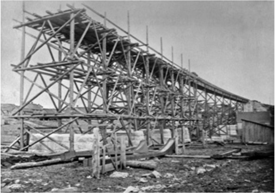
Fotografi tatt fra bakkenivå på samme tidspunkt som oversiktsbildet. De syv første pilarene med tilhørende spenn ser ut til å være reist, mens det er bygd tømmerstillaser for pilar 8–11. På bakken ligger den ytre, buete del av to pilarben. (Foto: JMF 8836).
