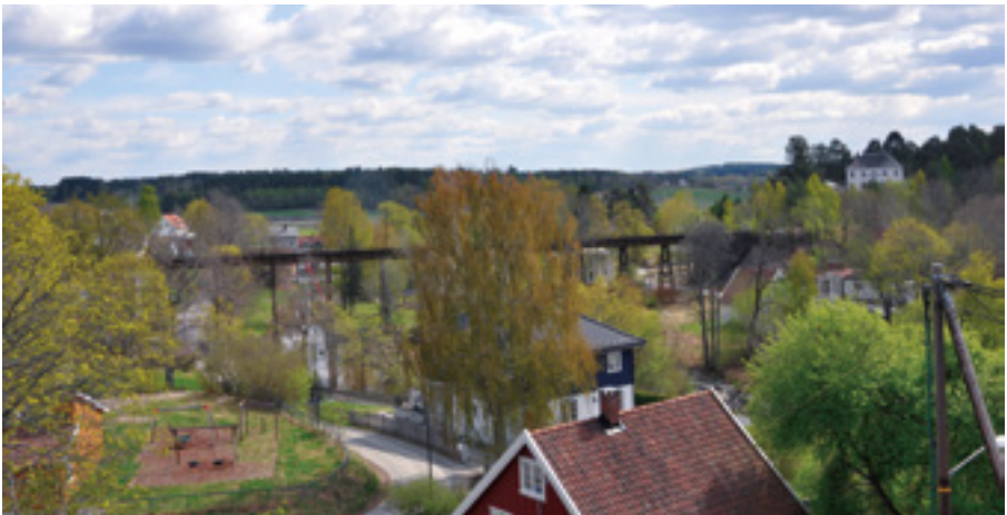
Hølen viadukt, 130 m lang, fotografert fra Breidablikkåsen i mai 2011. Den hvite bygningen i bakgrunnen til høyre er villa «Maderas» på Fløyåsen. (Foto: Rolf Tore Arnesen).
