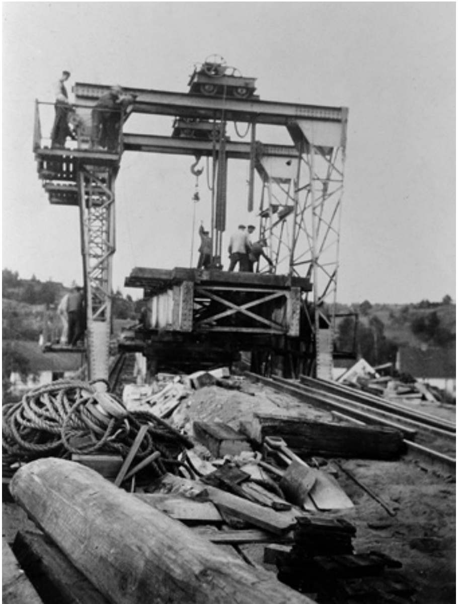
Portalkran med brospenn under ombyggingen av Hølen viadukt. Portalkranene var over syv meter høye og ble benyttet ved utskifting av spenn og pilarer og dessuten til å flytte de mobile tømmerstillasene. (Foto: JMF 5078).
