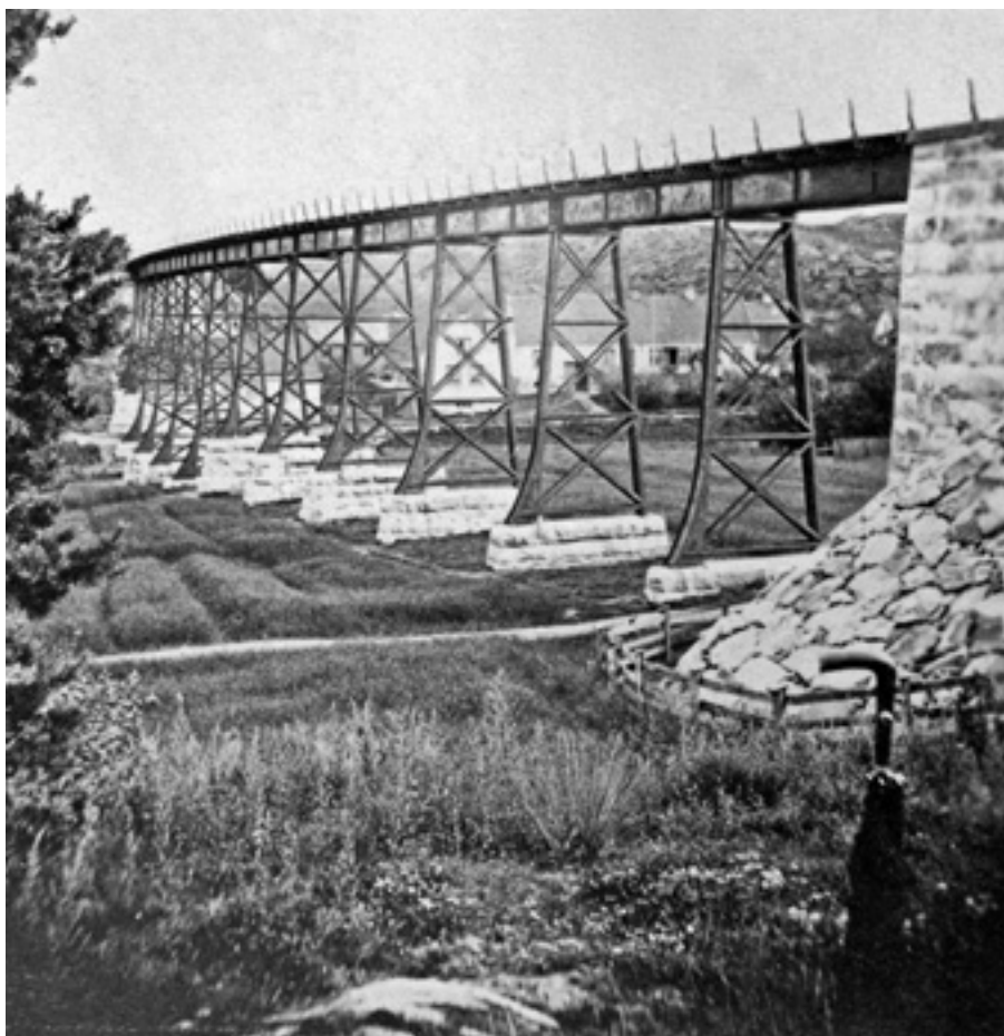
Den opprinnelige viadukten var karakterisert ved sterkt asymmetriske pilarer med avstivere i form av et kryss mellom bena. På kurvens yterside hadde pilarbena en markert svai nederst. Fotografiet er tatt sommeren 1878 av jernbanedirektør Carl Pihl. Fra Næsjordveien midt på bildet kunne kong Oscar 2. studere viadukten under besøket i Hølen. (Foto: JMF 8945).
