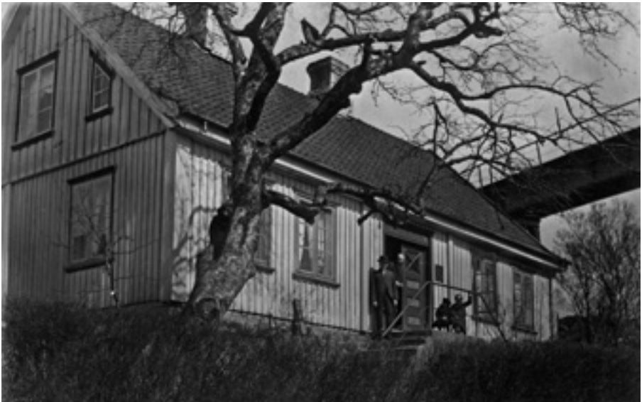
Poståpner Anna Marie Langlies hus (nå Holterhuset) lå bare ca. 10 m fra viaduktpilarene. Hun var sterkt plaget av støy og rystelser fra passerende tog, men jernbaneanlegget avslo hennes søknad om erstatning. På postkortet fra omkring 1915 står daværende poståpner Karl Johan Holter i døråpningen. (Fra Bjørn Simonsens samling).
