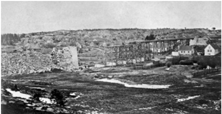
Oversiktsbilde fra oppføring av Hølen viadukt våren 1878. Viadukten ble påbegynt fra nord, mens steinfyllingen bak søndre landkar ennå ikke var fullført. Den største av bygningene som ses mellom landkaret og pilarstillasene er Hølen kommunegård. (Foto: JMF 11560).
