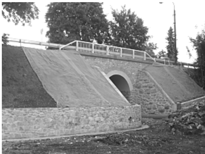
Portál nového mostu od severozápadu
