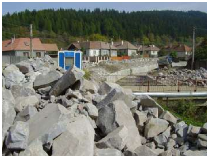
A patakmeder-szabályozás munkálatai Szépvízen
