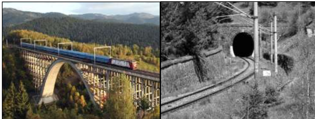
A Karakó-völgyhíd és az egy évig épült lóvész alagút bejárata 82
