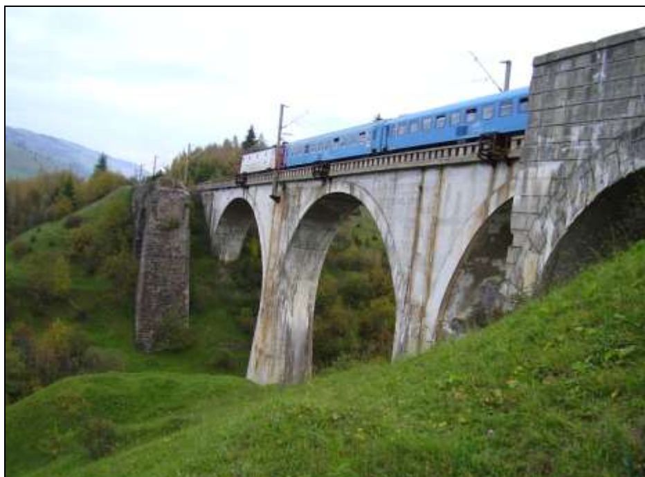
Menetrend szerinti vonat a középloki viadukon, mellette az eredeti viadukt maradványaival
