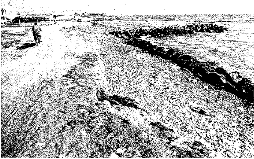
Şekil: 6- Dört Yol Ovası'nda hızlanmış kıyı erozyonunu gösteren fotoğraf (Kinet Höyük yakınından güneye doğru çekildi). Fotoğrafta görülen, erozyonu önlemek amacıyla yapılmış taş mendirekler bir tarafta kıyıyı korurken diğer tarafta daha fazla aşınmaya neden olmaktadır.
