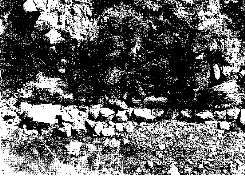
Resim: 3- Dış kısımları taşla örülen ve iç kısmı dolgu ile doldurulan baraj duvarının güneyi
