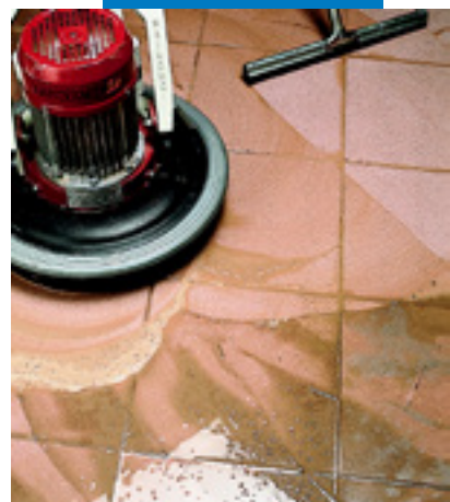
使用单盘转机或橡皮刮板对玻化砖地面进行表面修整
