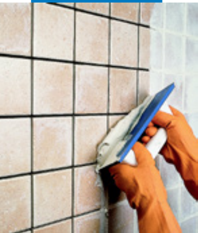
使用抹子对单面烧 砖填缝
