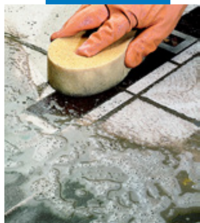
用海绵对木条砖缝进行表面修整
