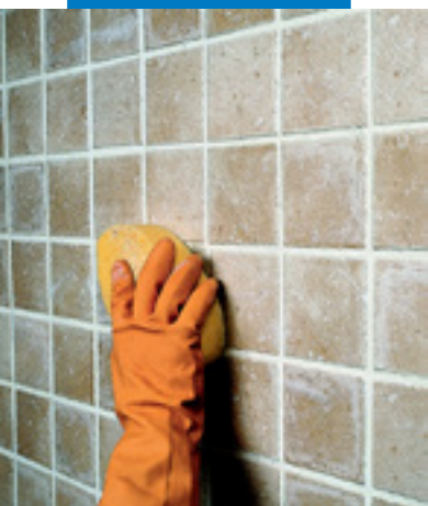
使用海绵对单面烧 砖墙进行表面修整
