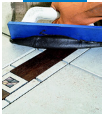
用刮板填入木条状地砖缝
