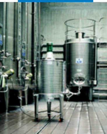
酒窖地面填缝施工案例
