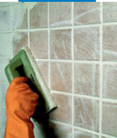
用思高®垫对单面烧 砖墙进行表面修整
