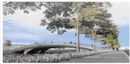
承天橋改建工程獲國家卓越建設獎優質獎肯定
