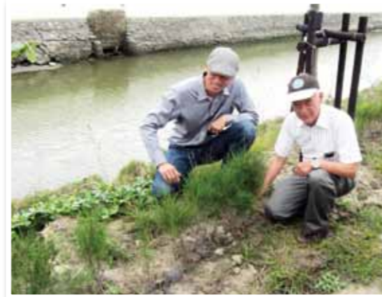
中央委員現場督導「內海藍色公路流域週緣植栽綠化工程」執行狀況
