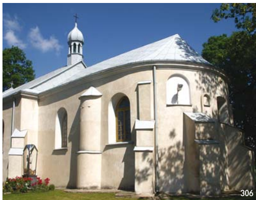
306 Gumino. Po bokach prezbiterium widać rzadko spotykane cylindryczne szkarpy
