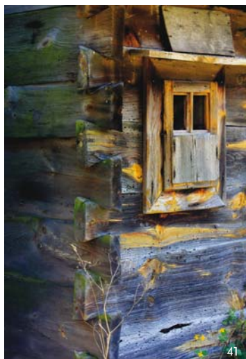
41 Biele. Przykład drewnianej konstrukcji zrębowej
