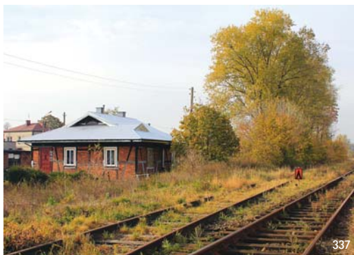
337 Budynek kolejowy w Baboszewie z 1. poł. XX w.
