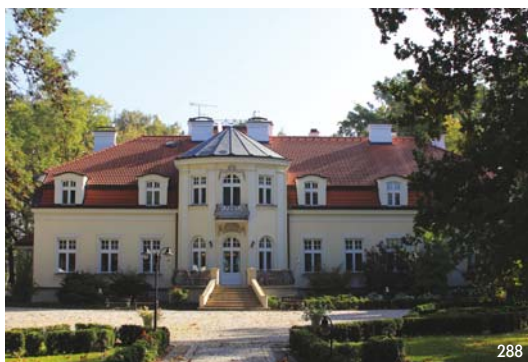
288 Dwór, elewacja ogrodowa
