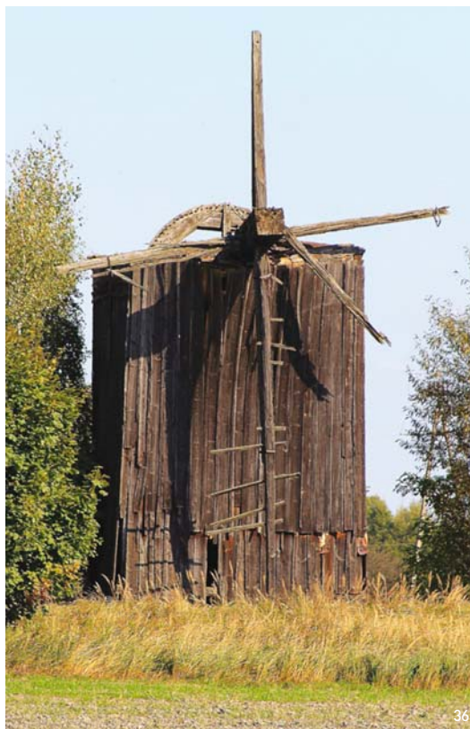
36 Milewo. Niszczący wiatrak. Ostatni w okolicach Płońska, który ma choć fragmenty skrzydeł
