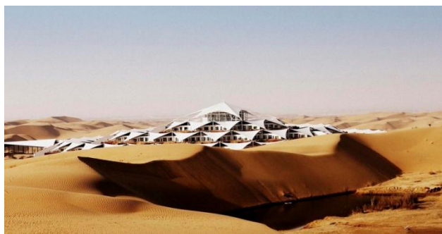
1.4.13 Эко-отель «Лотос» 5*, пустыня Гоби (Монголия). Plat Architects. 2013 г.
