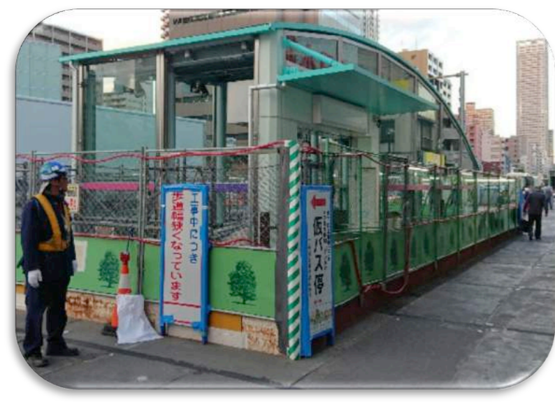
工事中のA3b出入口
