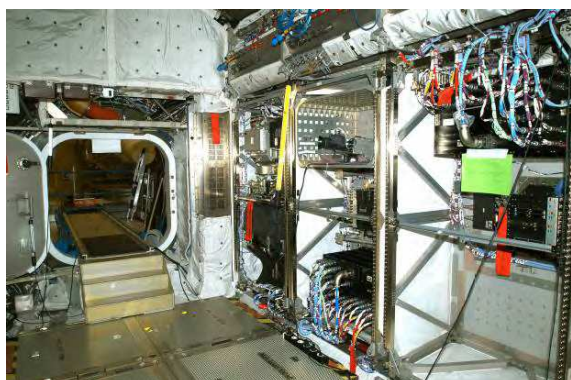
Skříně subsystémů laboratorního modulu Columbus během jejich testování.
