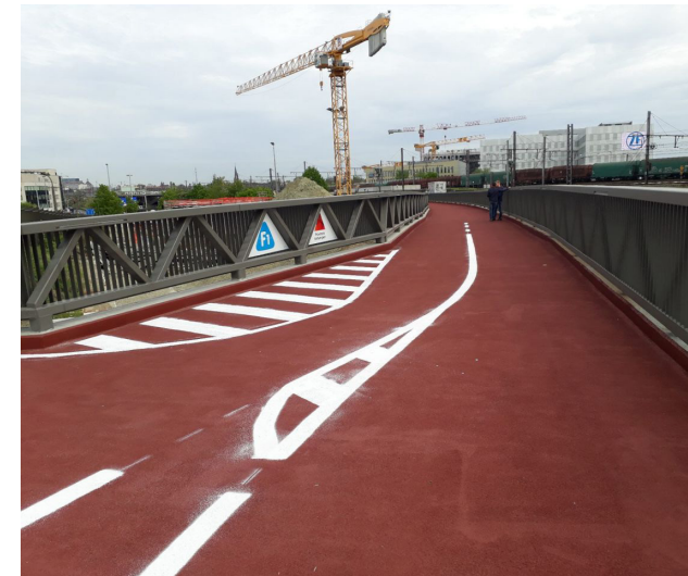
Verticale ontvlechting. Voorbeeld van fietsbrug over de Singel bij station Berchem. Met deze fietsbrug kruisen fietsers geen autoverkeer meer en moeten ze niet wachten bij verkeerslichten. (foto: provincie Antwerpen)
