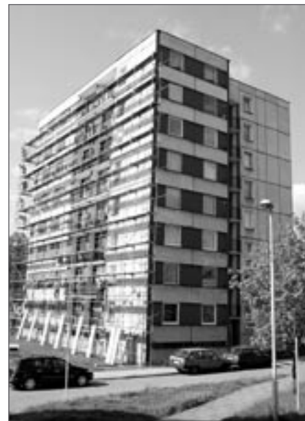
Montáž zateplení domu čp. 981 v Jelenově ulici
