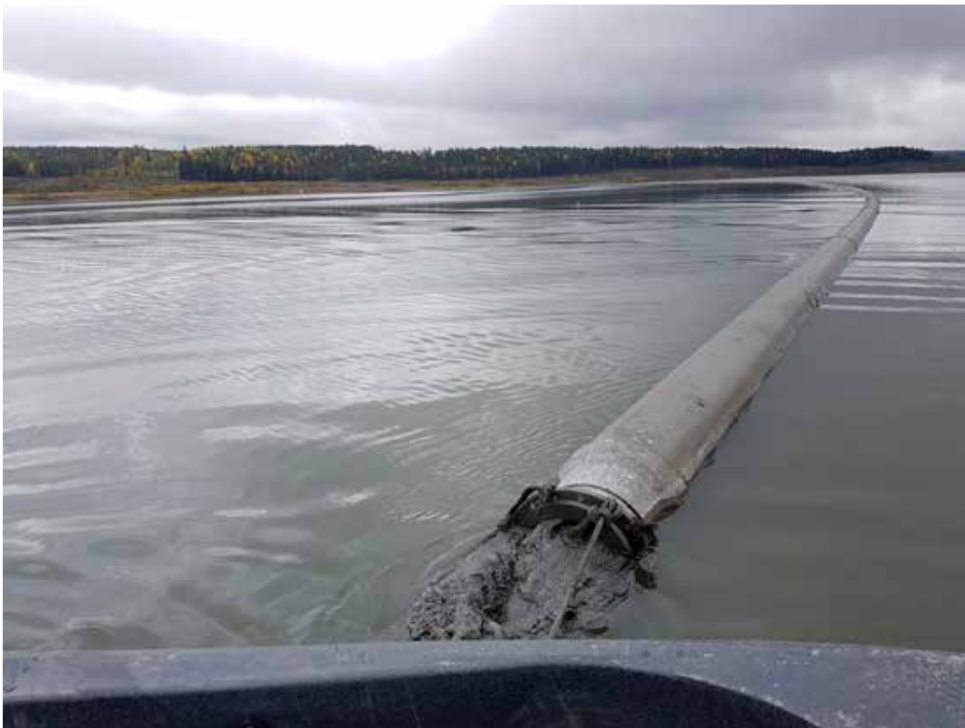
Deponering via flytledning där vattentäckning är viktigt för att undvika vittring av anrikningssanden, Hötjärnsmagasinet.
