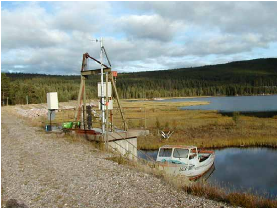
Stora flyttuvor på magasinet vid utskovskulvert.
