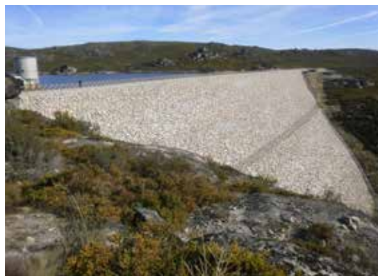
Veiguinhas dam, en 37 m hög CFRD-damm för vattenförsörjningsändamål i Saborfloden, Portugal, idrifttagen 2016.
