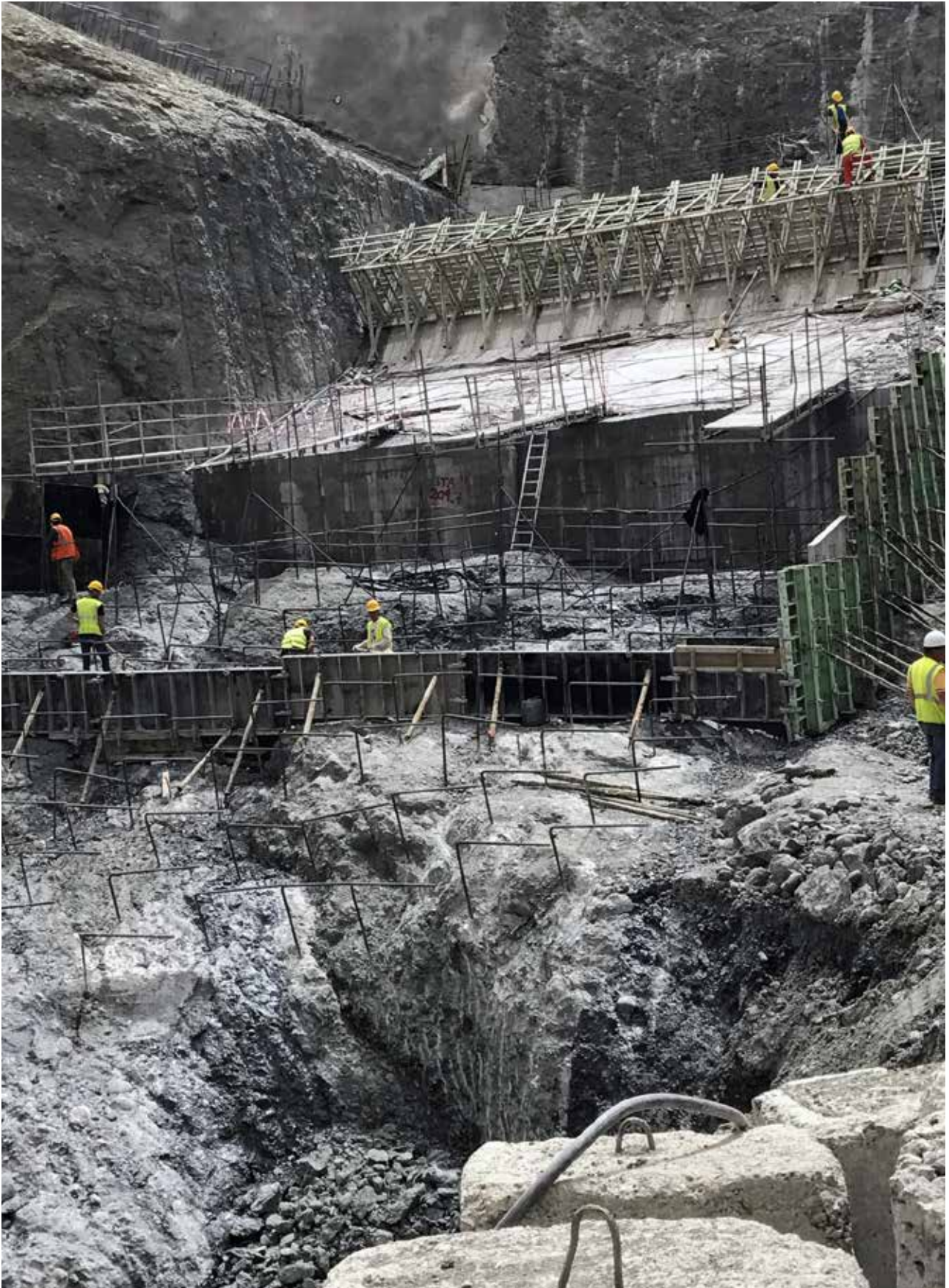
Slaka bergförankringar, Moglice under byggande, Albanien.
