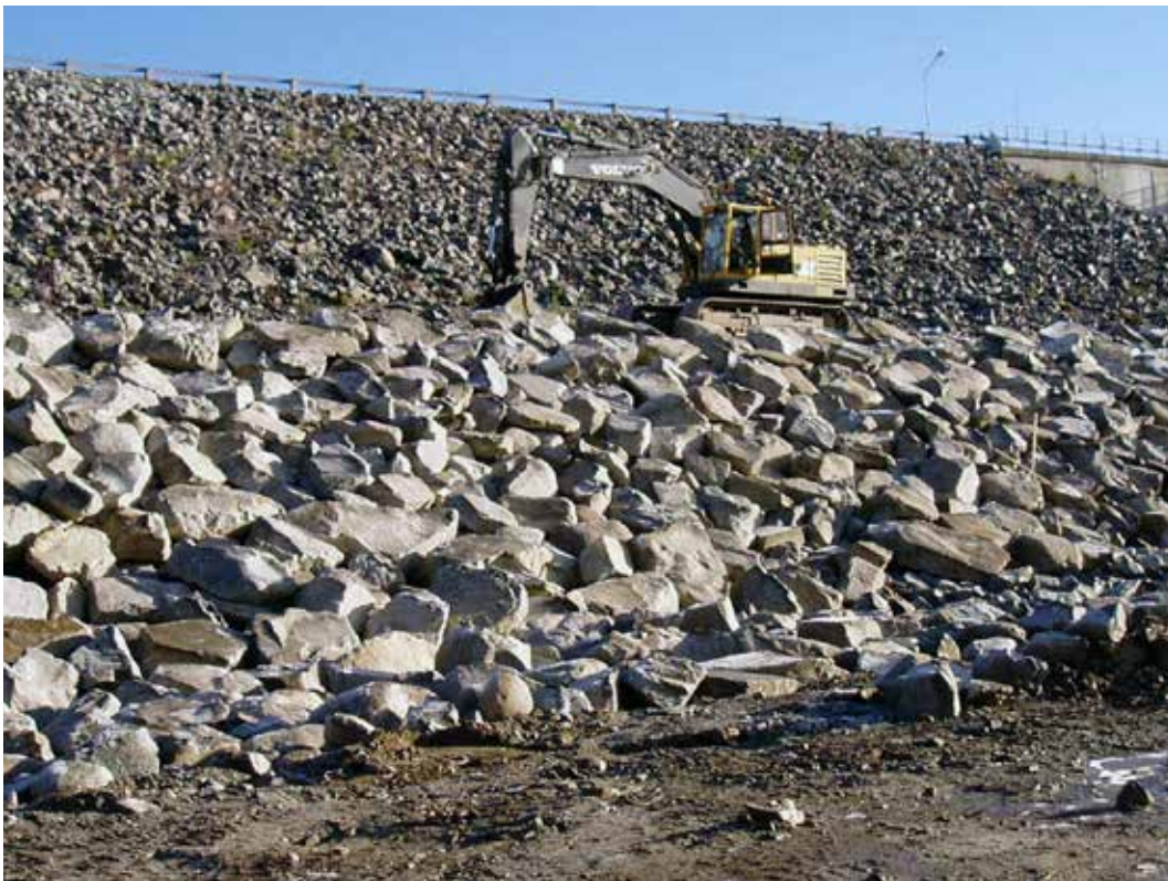
Dammtåförstärkning med sprängsten på nedströmsslänten.
