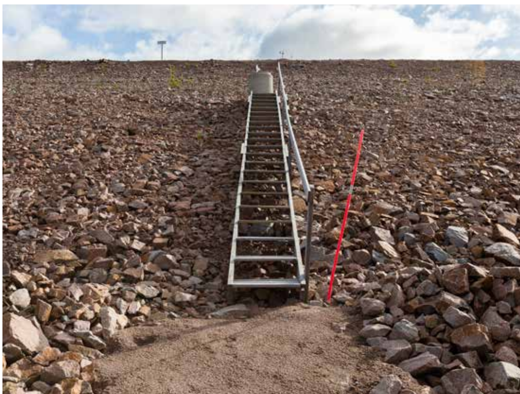
Trappa för åtkomst till mätinstallation.
