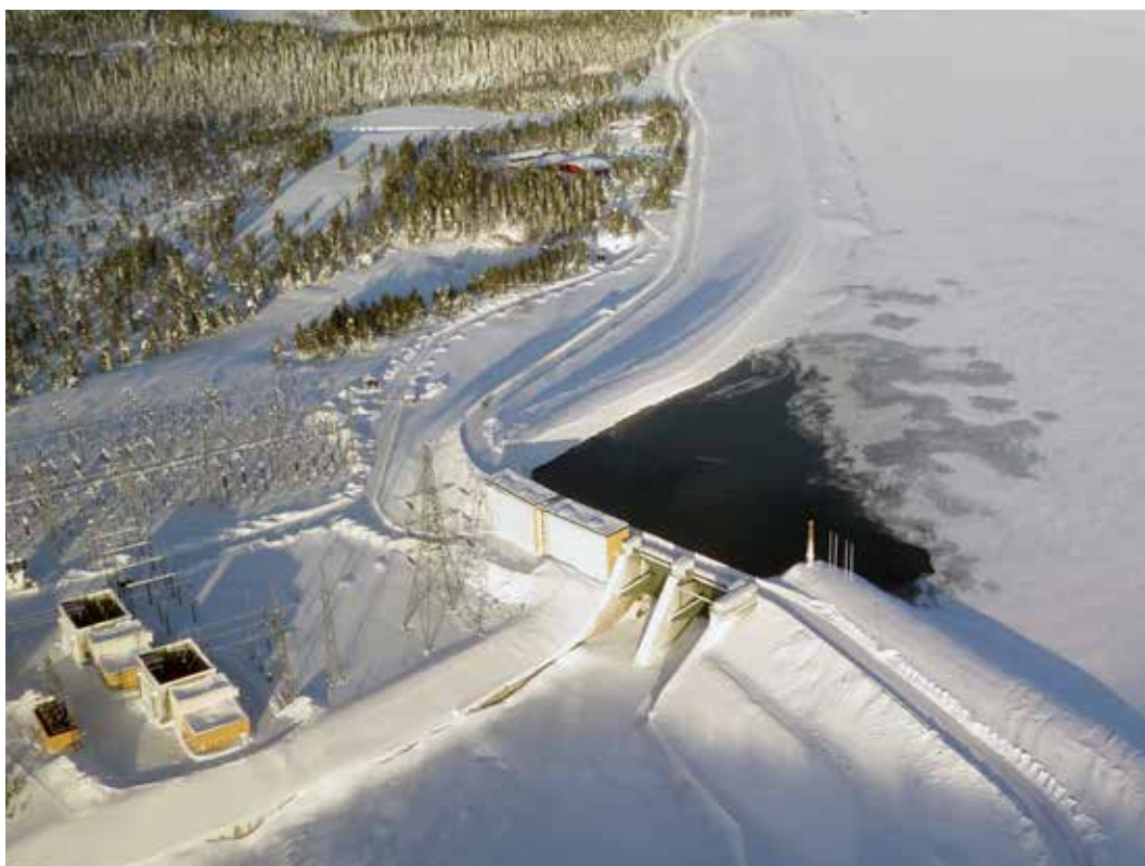
Vattenkraftanläggning i Lule älv.
