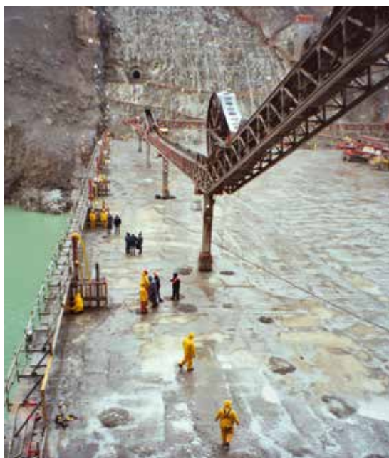
Ralco Dam, en 155 m hög RCC-damm för vattenkraftändamål i Biobiofloden, Chile, under byggnation 2003.
