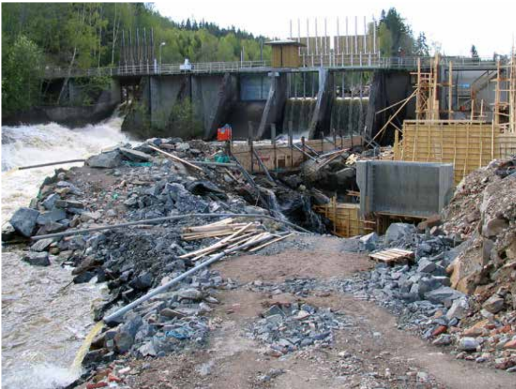
Fångdammar för torrläggning av arbetsområde.
