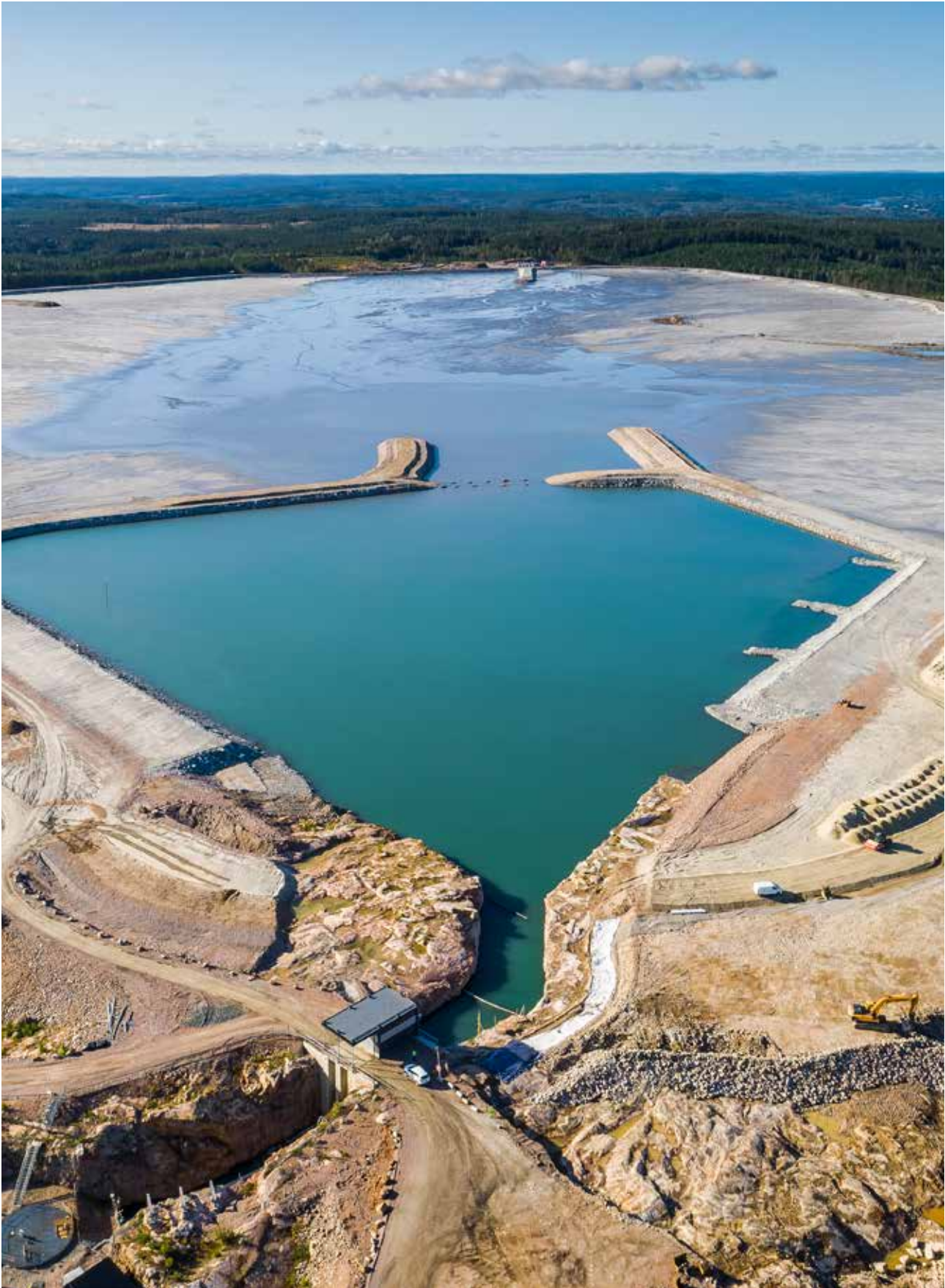
Gruvdamm i Garpenberg. Klarningsmagasin, sandmagasin och utskovskanal.
