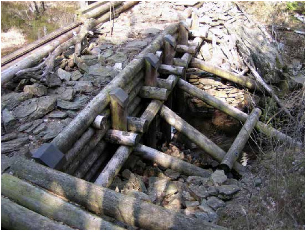
Träddamm med spontplank mot uppströmssidan och stödjande stenkistor.
