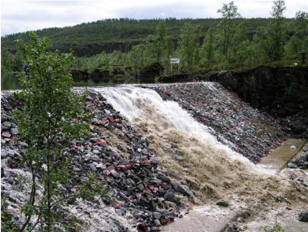
Överströmning av fyllningsdamm vid storskaliga fältförsök i Norge.
