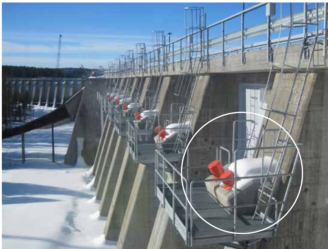
Förspända bergförankringar, Storfinnsforsen.
