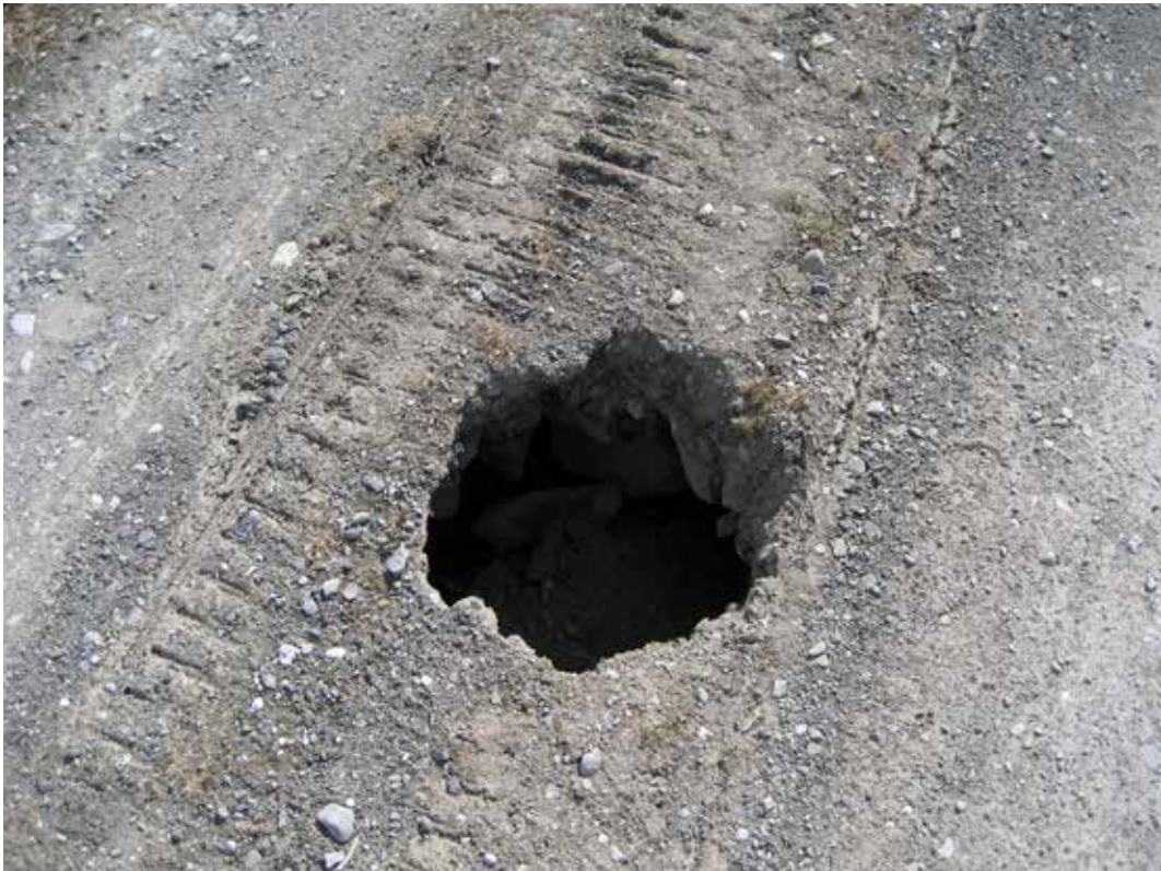
Sjungkrop i vägbana på dammkrön.
