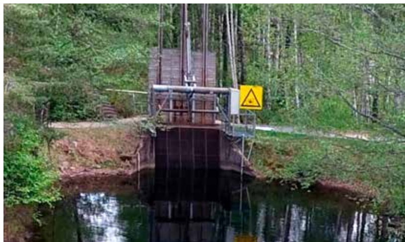
Anläggning med intagsdamm med tubintag fristående från regleringsdamm.
