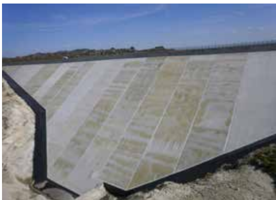
Veiguinhas dam, en 37 m hög CFRD-damm för vattenförsörjningsändamål i Saborfloden, Portugal, idrifttagen 2016.
