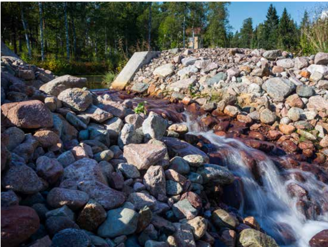
Erosionsskyddat utlopp. Dalkarlsdammen i Garpenberg.
