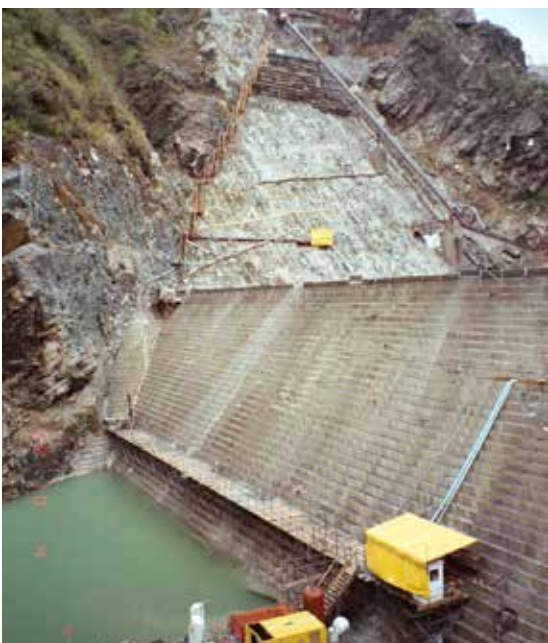
Ralco Dam, en 155 m hög RCC-damm för vattenkraftändamål i Biobiofloden, Chile, under byggnation 2003.
