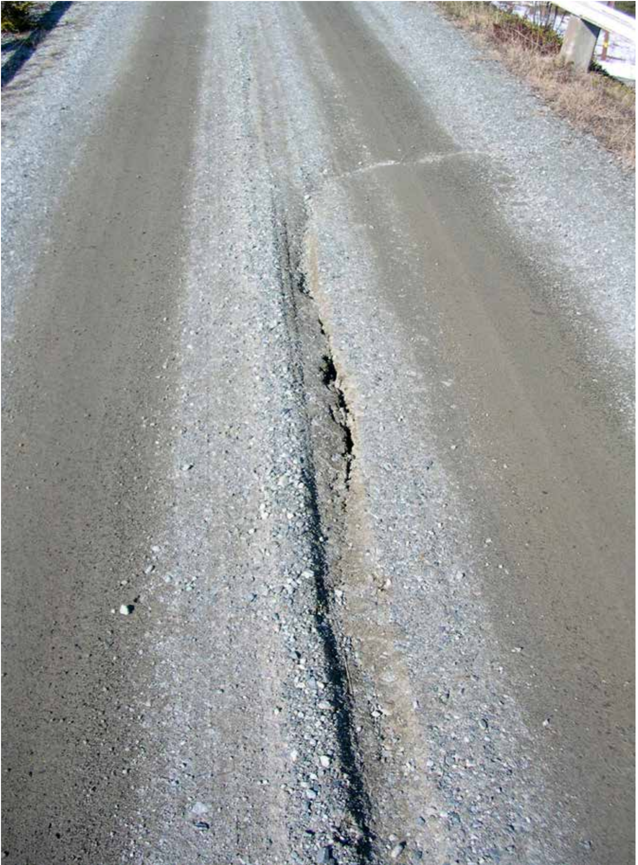
Spricka i dammkrön vid fyllningsdammens anslutning till betongkonstruktion, orsakad av låg släntstabilitet åt nedströmshållet.
