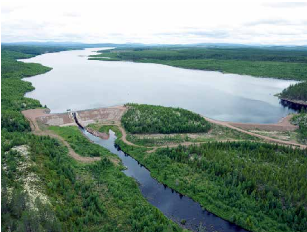
Dammanläggning med en regleringsdamm med utskov och en spärrdamm, Smedjemora, Ljusnan.
