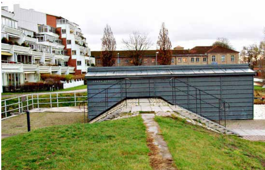
Invallning för översvämningsskydd med pumpstation i Kristianstad.
