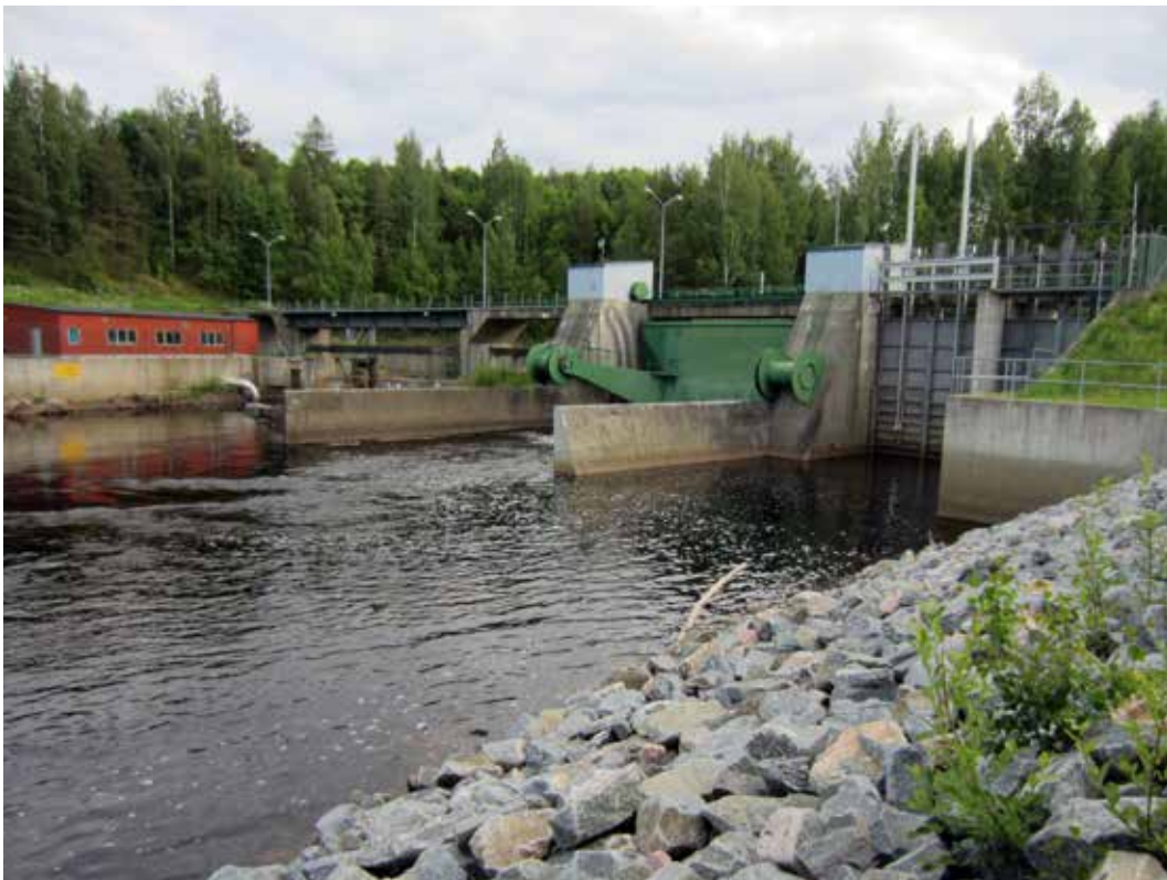
Anläggning utan energiomvandlare med ledmurar nedströms.
