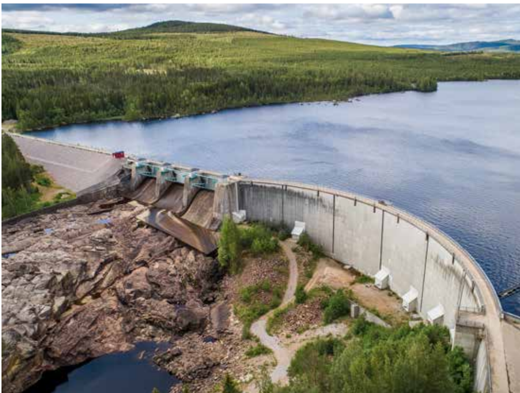
Valvdamm, Krokströmmen, Ljusnan.
