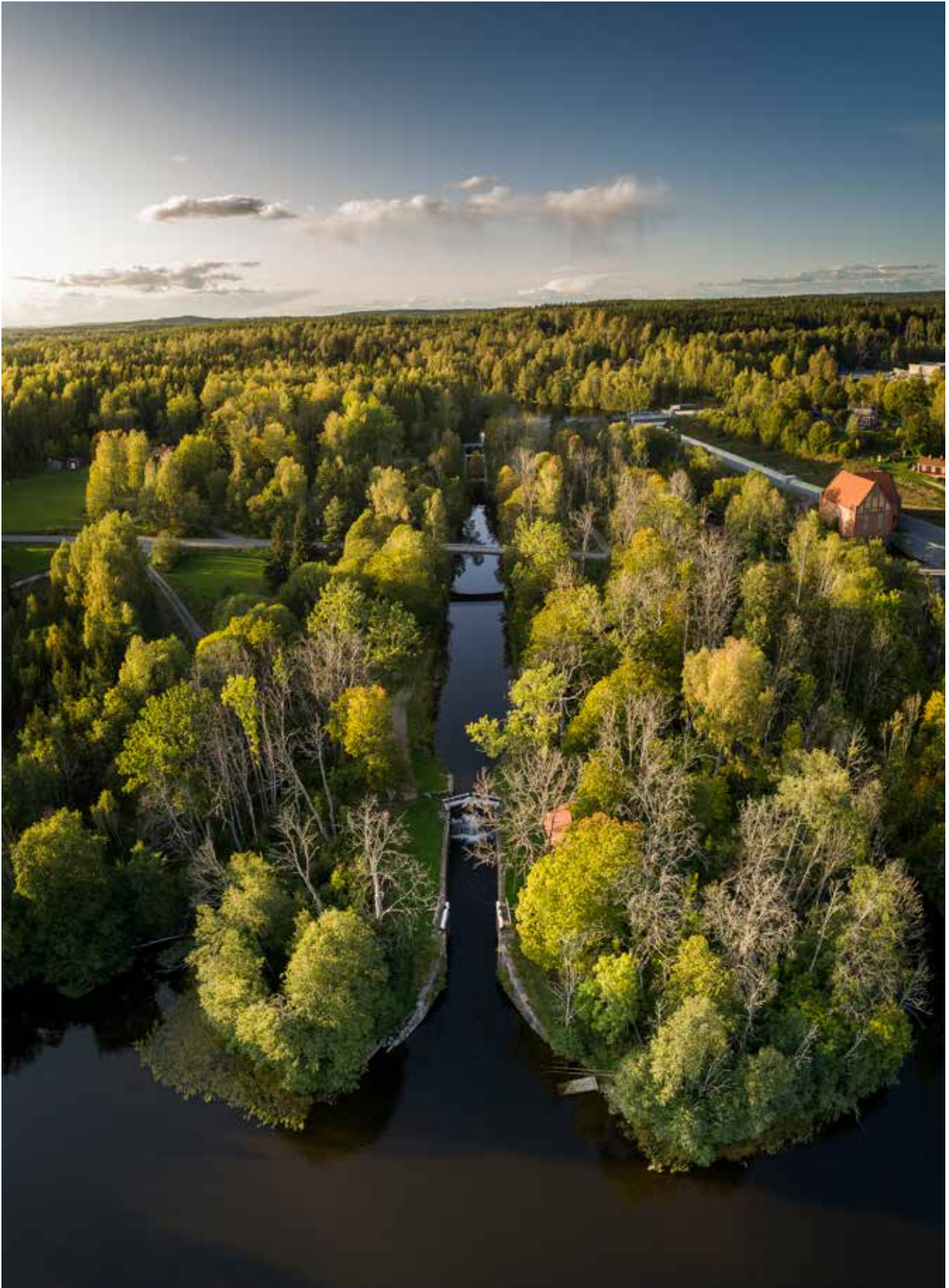
Hertigen af Östergötlands sluss, Strömsholms kanal.
