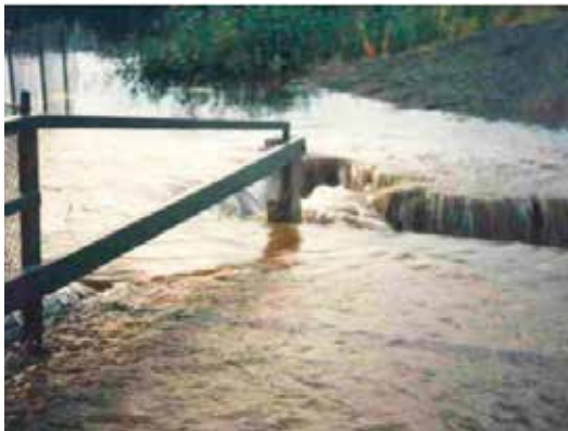
Överströmning pga. utebliven lucköppning.
