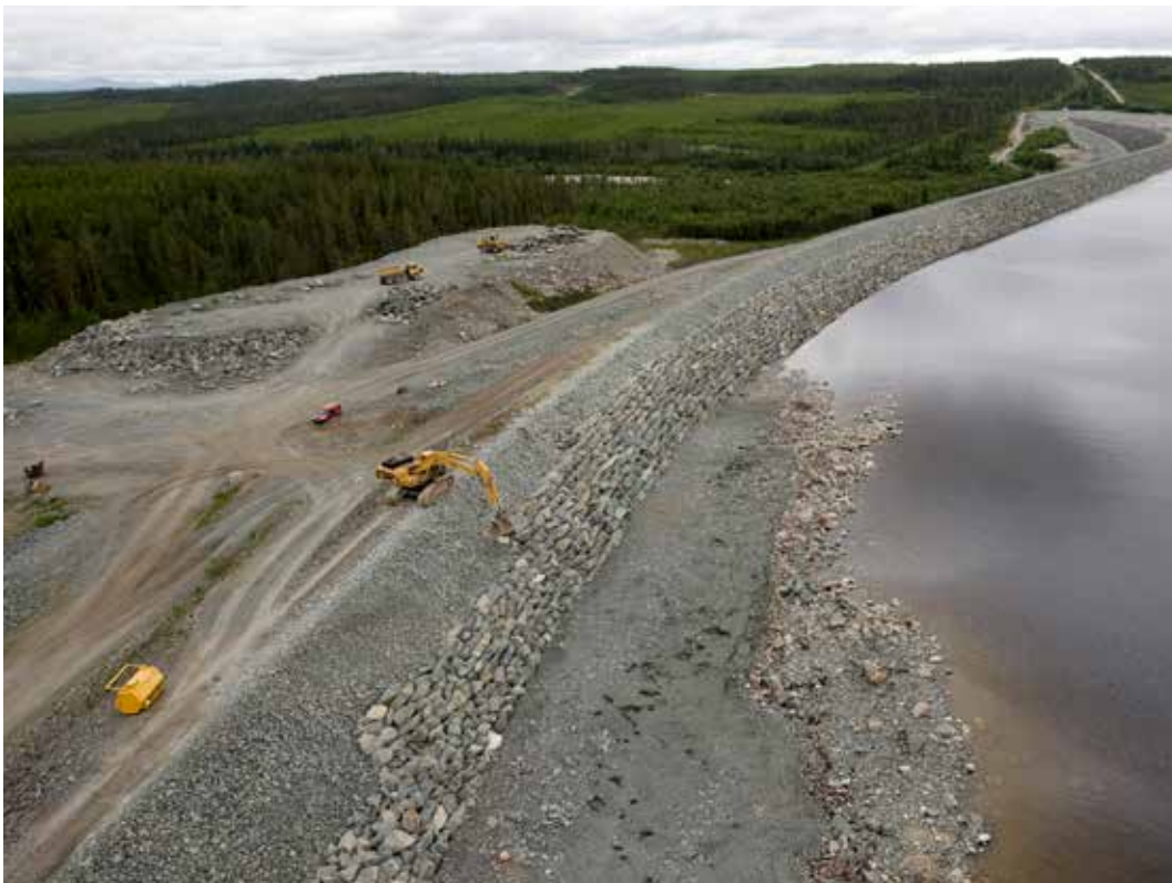
Utläggning av ordnat erosionskydd vid Grundsjöarna, Ljusnan.
