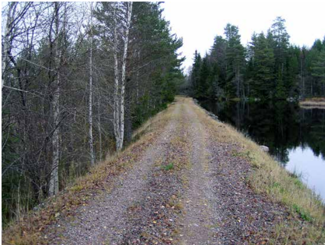
Kanalbank längs intagskanal.
