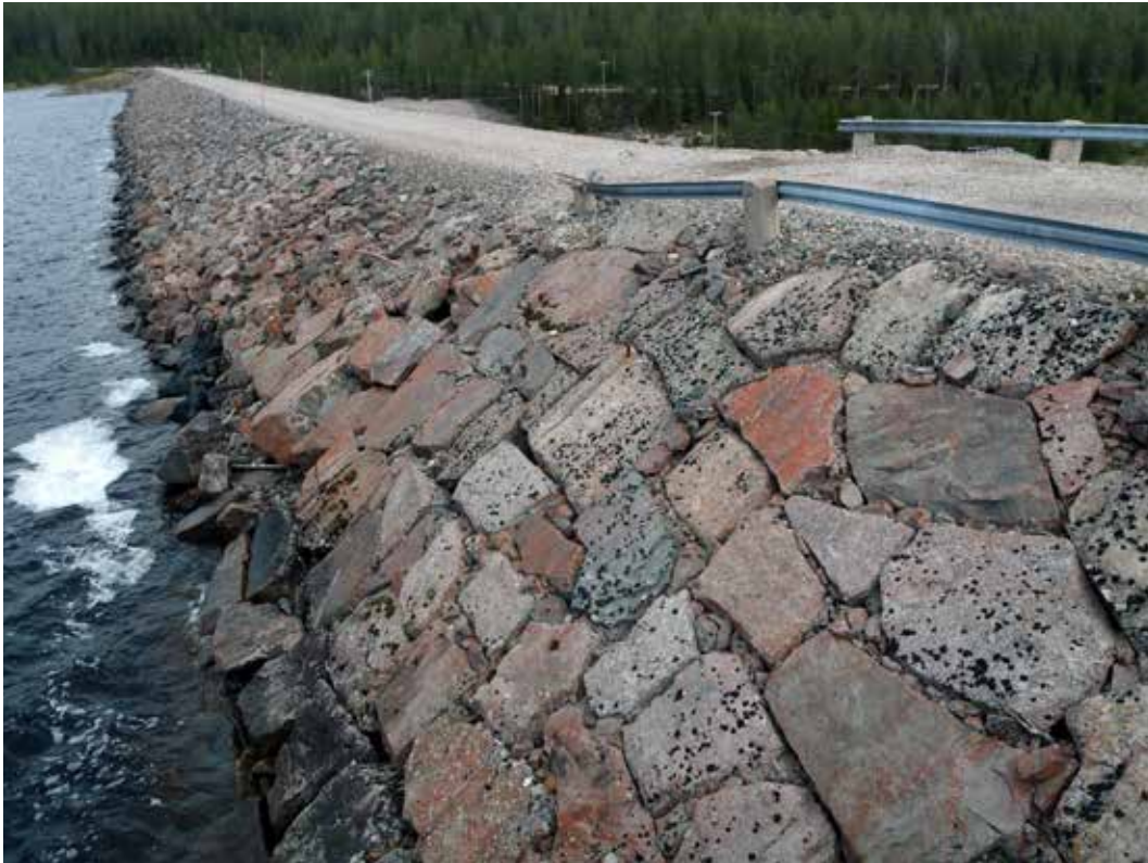
Oordnat erosionskydd och glacis.
