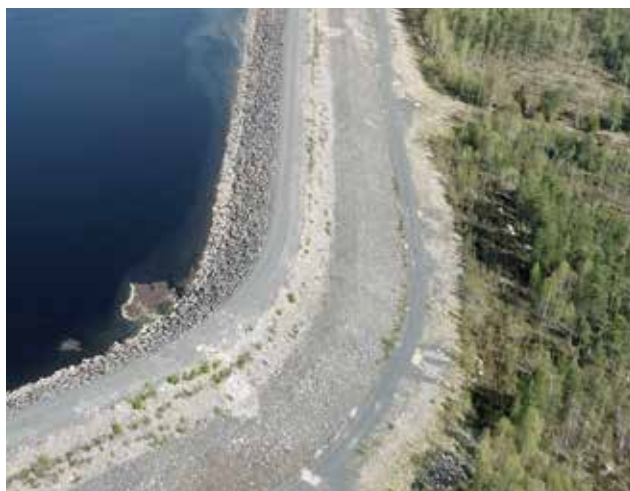
Sektion genom fyllningsdamm med sprängsten på ytan och jordfyllning invändigt, samt foto över samma damm.
