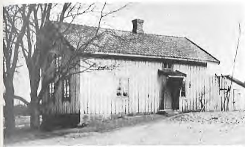
Brygghuset i Fällinge Assaregård användes i början av 1900-talet som skollokal i Fällinge rote.
