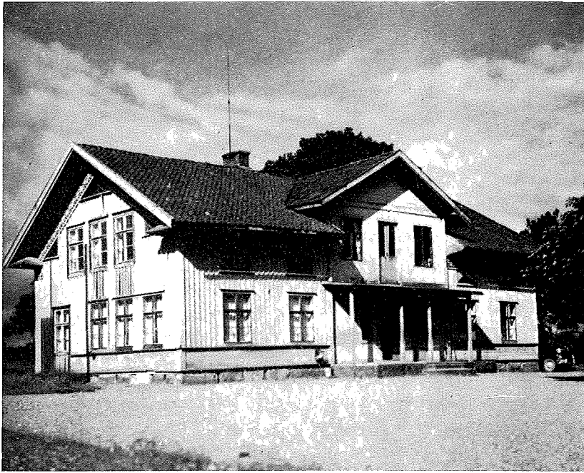
Bølaryds gästgivargård före ombyggnaden. Under tiden 1944—1957 var här provisoriska lokaler inredda för en läraravdelning. Efter ombyggnad 1957 innehåller byggnaden 3 klassrum, 1 mindre gymnastiksal, samlingsal, lärarum och materielrum.
