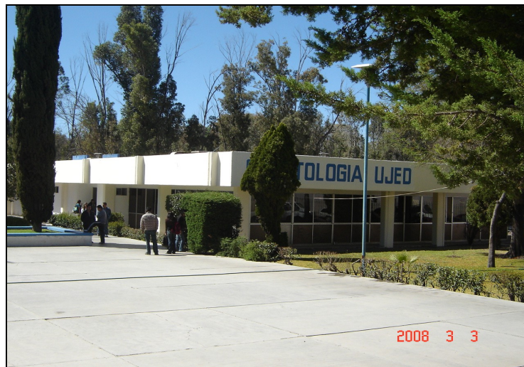
Edificio de Clínicas. Escuela de Odontología UJED
