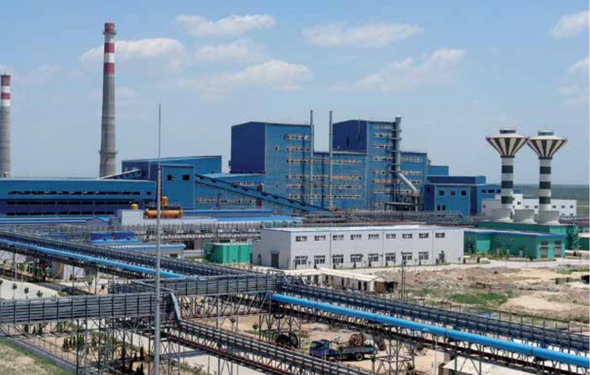
Suurin osa Kiinassa tuotetusta kuparista valmistetaan nykyisin liekkisulatusmenetelmällä. Kuvan liekkisulatus-liekkikonvertointilaitos käynnistyi 2007 Kiinan Yangussa.
