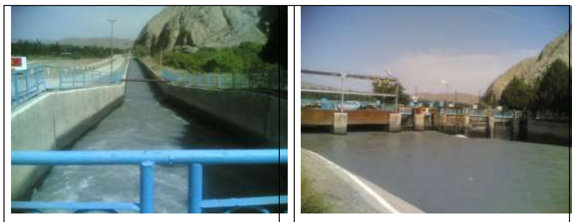
Рис. 4.2. Гидроузел (слева) осуществляет водораспределение в подводящий канал Тортгульского водохранилища (справа).
