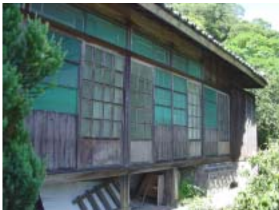
圖 2-2-52 後 5 側面迴廊外觀，全為木製落地窗。 圖 2-2-53 後 5 建物部份外牆為石造，採亂石砌及人字砌法。
