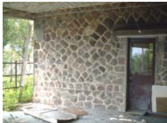
圖 2-2-78 後 18 石牆以亂石砌法處理。
