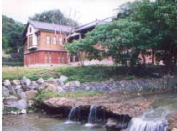
圖 2-1-5 北投溫泉博物館現貌(北投溫泉公共浴場)
