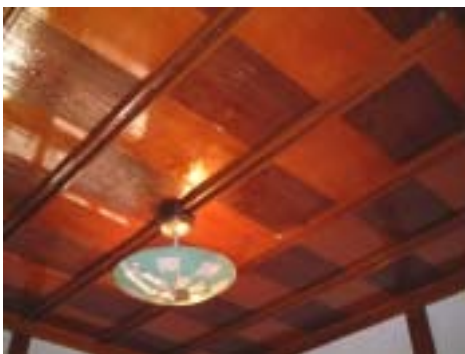
圖 3-5-12 寶山建設招待所的天花板-1
