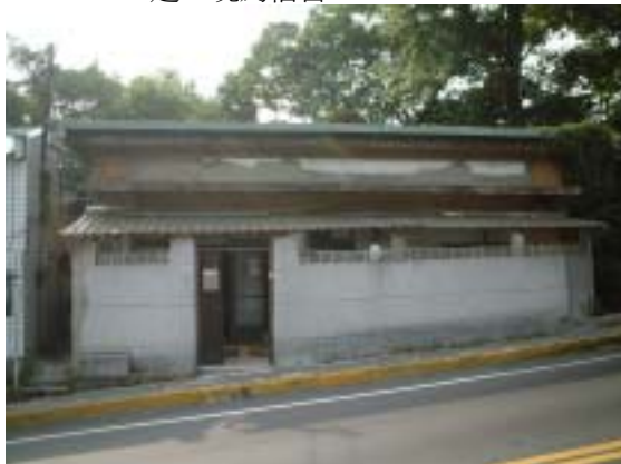
圖 2-2-37 前 20 巴車庫現況，圍牆為後來加建，現為宿舍。
