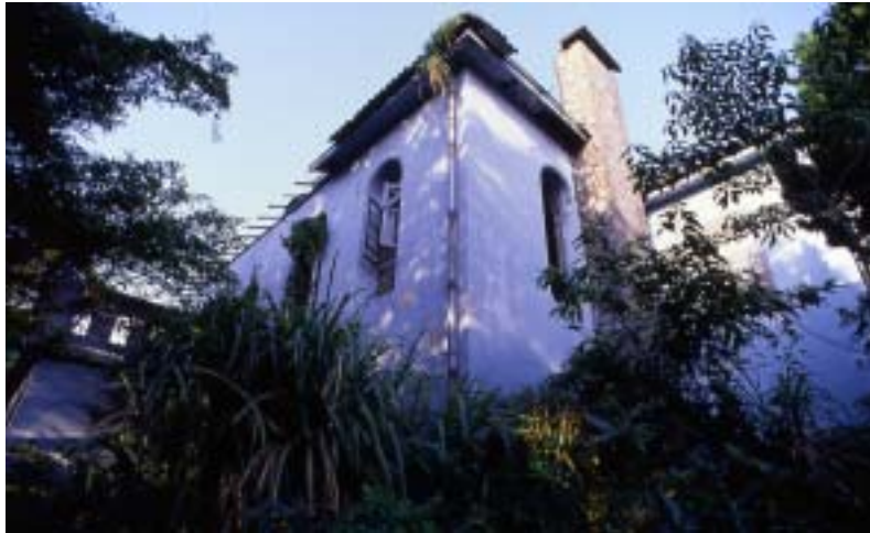
圖 2-2-45 後 1 為二層樓鋼筋混凝土歐式建築，入口玄關上方為陽台，為斜屋頂，外牆為藍色。(來源：陽管處呂理昌主任)
