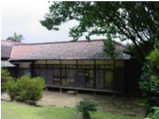
圖 2-2-82 外 1A 棟外觀，全面落地窗，便於觀賞庭園與進出庭園
