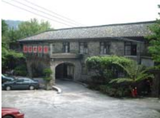
圖 2-2-41 前 22 國際大旅館外觀，為二層樓石造斜屋頂建築。
