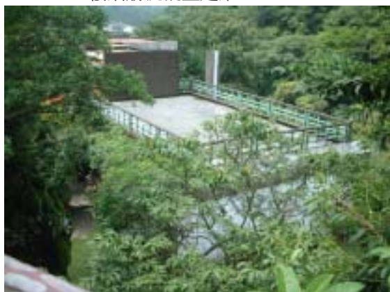
圖 2-2-25 前 14 建物現貌，已完全改建為二層樓鋼筋混凝土建築。
