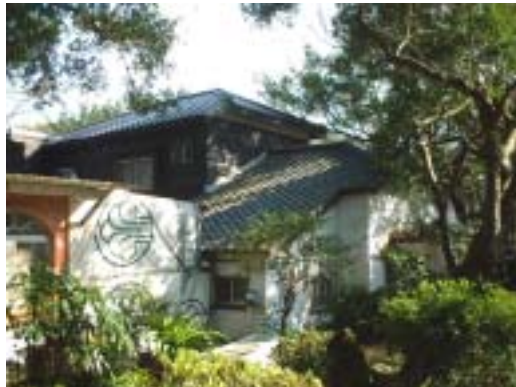
圖 2-2-16 前 9 側面外觀，二樓為木造斜屋頂建築，外牆為雨淋板。
