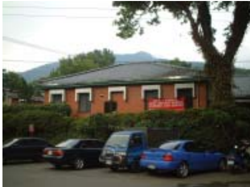
圖 2-2-19 前 11 舊址上新建之陽管所辦公室，為一層樓鋼筋混凝土建築。
