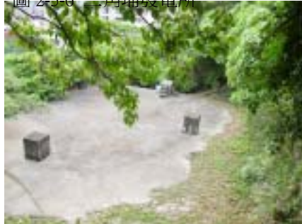
圖 2-3-6 三角埔發電所
