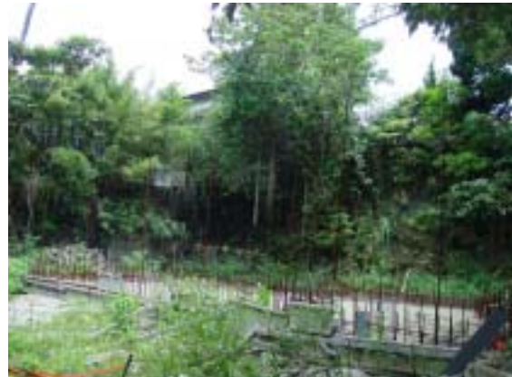
圖 2-2-70 後 14 之 91 號，目前已完成基礎部份。
