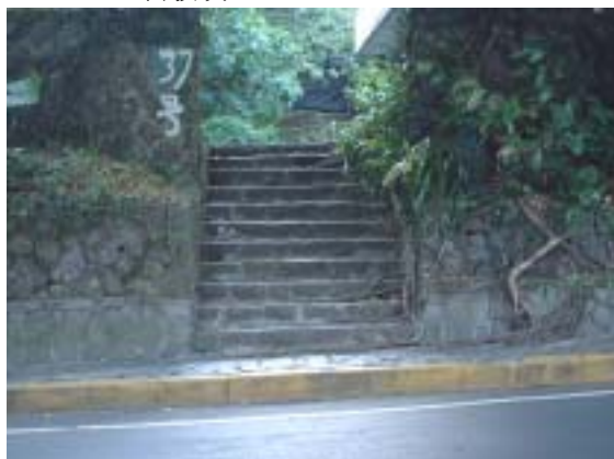
圖 2-2-33 前 18 若草屋旅館遺留砌石階梯及砌石駁坎。
