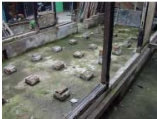
圖 2-2-18 前 10 舊址上已燒毀之建築，由其基礎來看為東立式建築。
