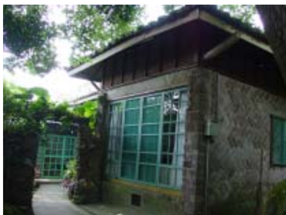
圖 2-2-64 後 11 為一層樓石造斜屋頂建築，外觀仍維持原貌，覆以黑色瓦片。
