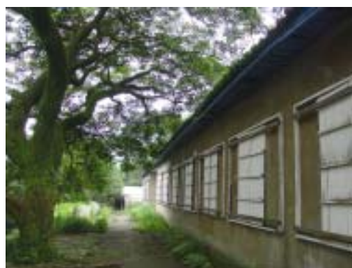
圖 2-2-2 前 1 於林間學校原址上新建之一層樓磚造斜屋頂建築，屋頂覆以黑色瓦片。
