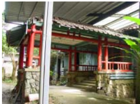
圖 2-2-13 前 8 御賓館洋館現況，為一樓木造斜屋頂建築，覆黑瓦、外牆為雨淋板。 圖 2-2-14 前 8 入口門棚現況，木構損毀嚴重。
