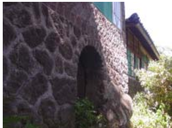
圖 2-2-52 後 5 側面迴廊外觀，全為木製落地窗。 圖 2-2-53 後 5 建物部份外牆為石造，採亂石砌及人字砌法。
