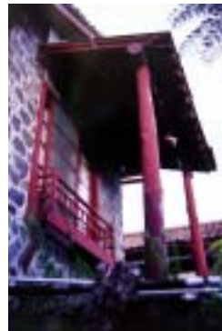
圖 3-3-13 大屯ホテル拆除前外觀-2
