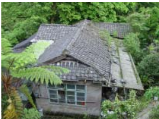
圖 2-2-23 前 13 為一層樓磚造斜屋頂建築，覆黑瓦。
