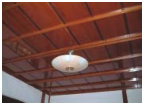
圖 3-5-13 寶山建設招待所的天花板-2
