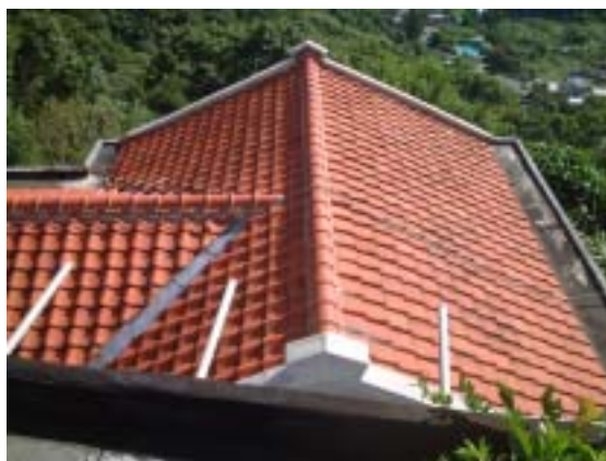
圖 2-2-61 後 9 爲二層樓石造斜屋頂建築，外觀已大致改建，覆以紅色瓦片。
