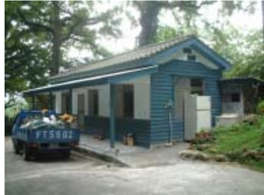
圖 2-2-84 正面外觀，為一層樓鋼筋混凝土斜屋頂建築 圖 2-2-85 外 2 警衛室，一樓木造斜屋頂建築
