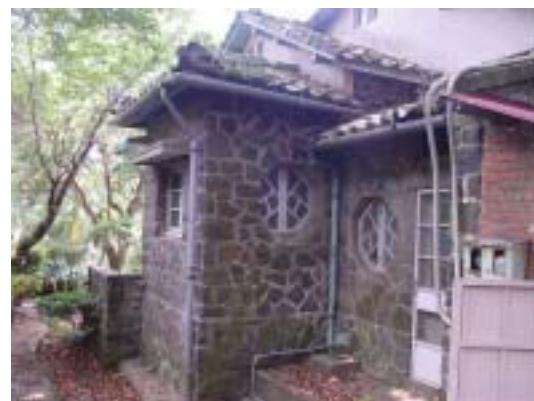
圖 2-2-74 後 16 石牆以亂石砌法處理，八角窗為原貌。
