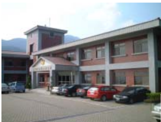
圖 2-2-79 後 19 國家公園警察大隊現貌，為二層樓鋼筋混凝土斜屋頂建築，屋頂覆以紅色瓦片。
