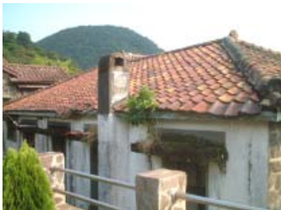
圖 2-2-77 後 18 為一層樓石造斜屋頂建築，屋頂覆以茶褐色瓦片。
