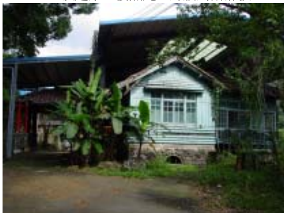
圖 2-2-13 前 8 御賓館洋館現況，為一樓木造斜屋頂建築，覆黑瓦、外牆為雨淋板。 圖 2-2-14 前 8 入口門棚現況，木構損毀嚴重。
