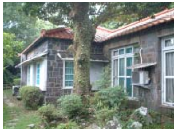
圖 2-2-80 後 20 為一層樓石造斜屋頂建築，屋頂覆以紅瓦片。
