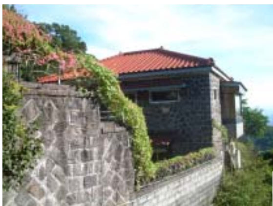
圖 2-2-68 後 13 為二層樓石造斜屋頂建築，屋頂覆以紅瓦片。
