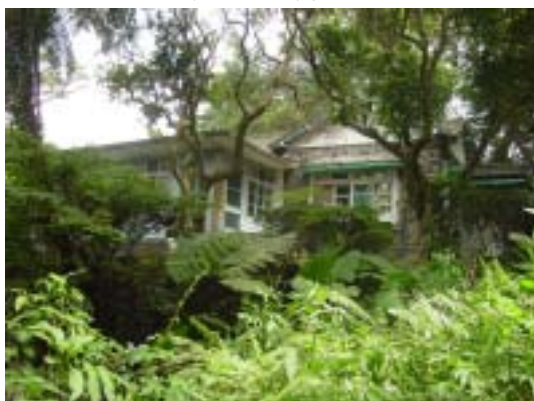
圖 2-2-73 後 16 為一層樓石造斜屋頂建築，
