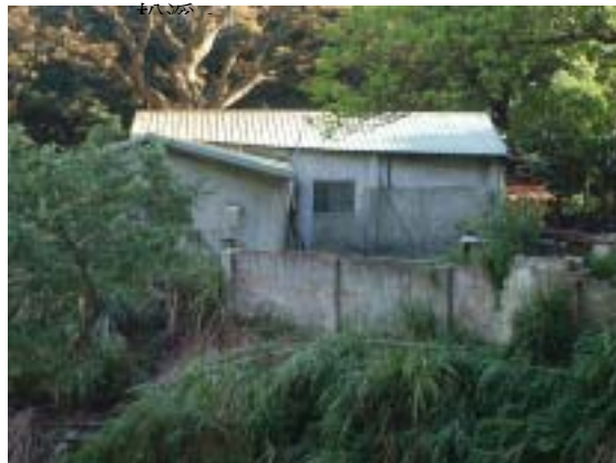
圖 2-2-12 前 7 建物現貌為一層樓磚造斜屋頂建築，屋頂覆以金屬浪板，建物後方為
