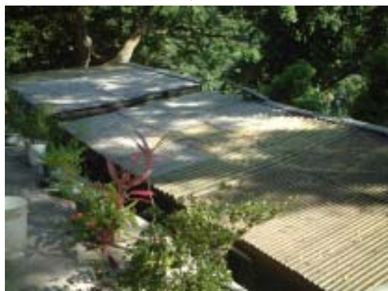
圖 2-2-55 後 6 目前有人居住的部份，屋頂已改為塑膠浪板。
