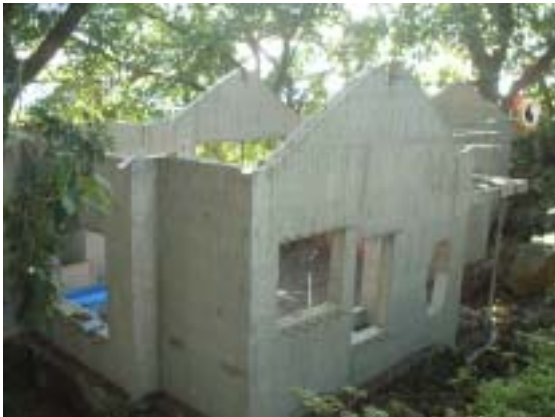
圖 2-2-69 後 14 之 87 號重建狀況，以鋼筋混凝土為結構體。
