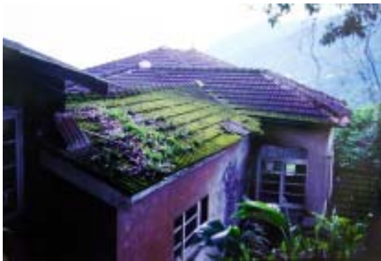
圖 3-3-14 大屯ホテル拆除前外觀-3
