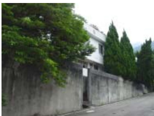
圖 2-2-1 前 1 於林間學校原址上新建之二層樓鋼筋混凝土造建築。
