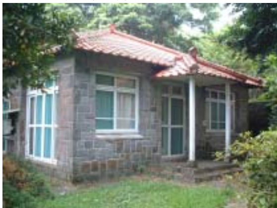
圖 2-2-80 後 20 為一層樓石造斜屋頂建築，屋頂覆以紅瓦片。
