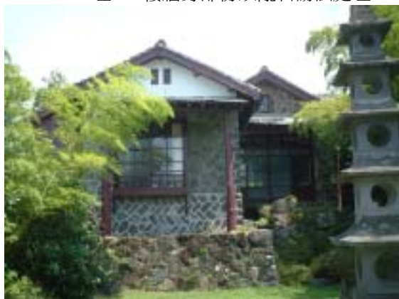
圖 2-2-75 後 17 石牆基礎部份以人字砌法處理，一樓牆身部份以亂石砌法處理。
