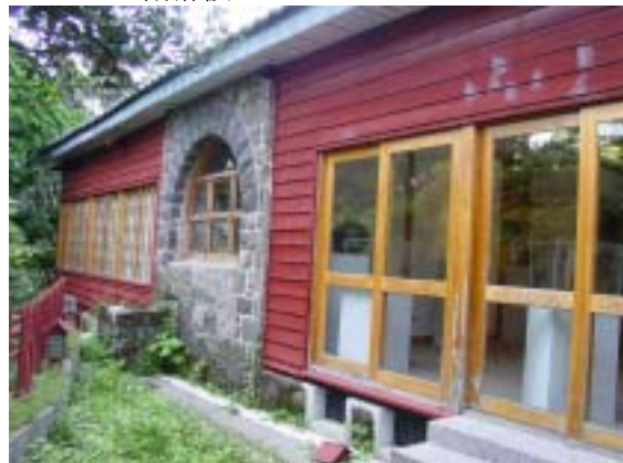
圖 2-2-72 後 15 側面外觀，外牆結合石造與木造雨淋板。
