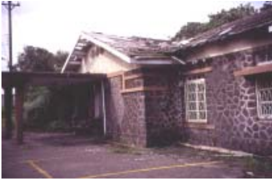
圖 3-3-12 大屯ホテル拆除前外觀-1
