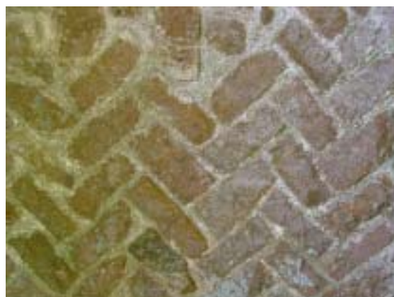
圖 2-2-65 後 11 石牆以人字砌法處理。
