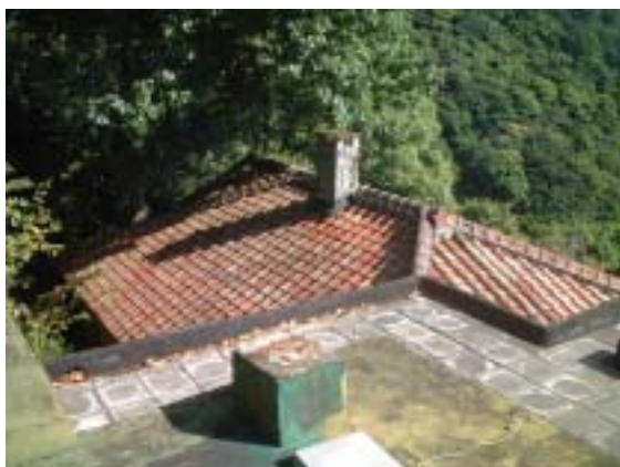
圖 2-2-60 後 9 爲一層樓石造斜屋頂建築，外觀仍維持原貌，覆以茶褐色瓦片。
