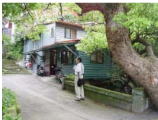
圖 2-2-28 前 15 多喜之湯旅館入口舊址。
