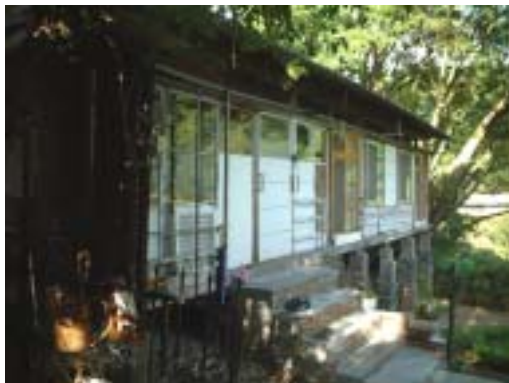
圖 2-2-17 前 10 舊址上建物已部份改建，具日式特色如基礎架高、落地窗。
