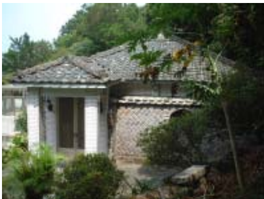
圖 2-2-50 後 4 為一層石造斜屋頂建築，外觀已為鋼筋混凝土外貼二丁掛。
