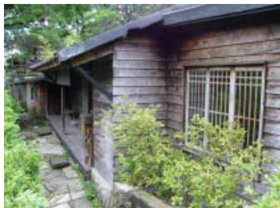
圖 2-2-10 前 6(80 號)，為一層樓木造斜屋頂建築，屋頂為金屬浪板，大致維持原貌。
