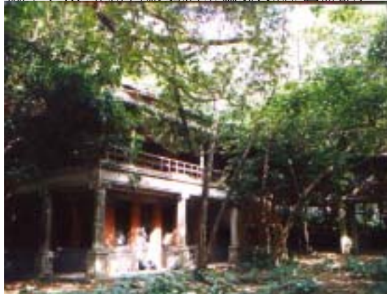
圖 2-1-10 北投台銀舊宿舍現貌(新松島旅館)
