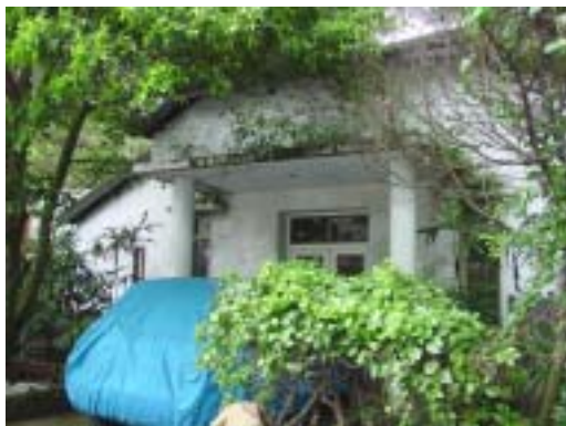
圖 2-2-15 前 9 正面外觀，一樓為鋼筋混凝土建築。
