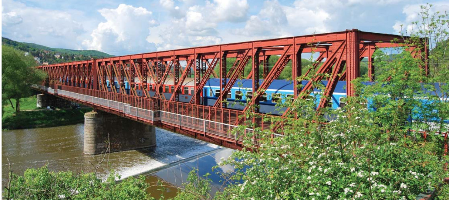
Železniční most v Mokropsích. Foto: Václav Götz
