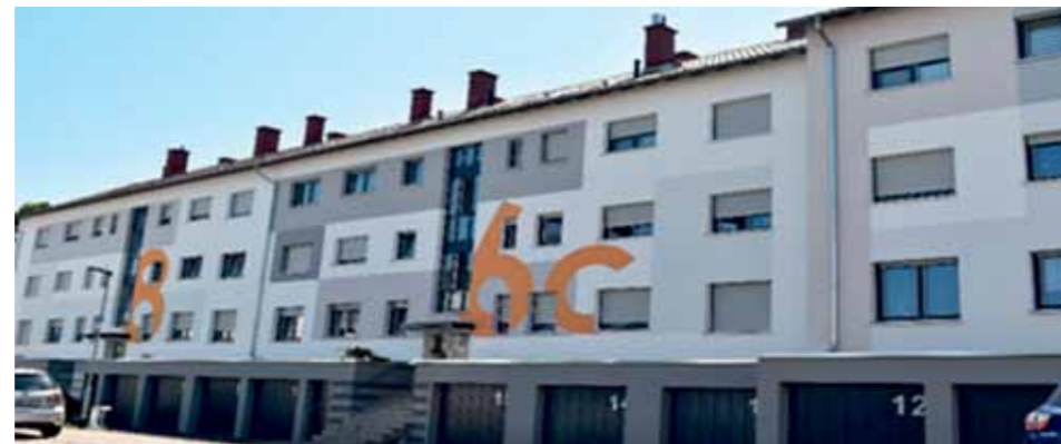
Modernisierung im Bestand: Häuserzug Schubertstraße 6-8
