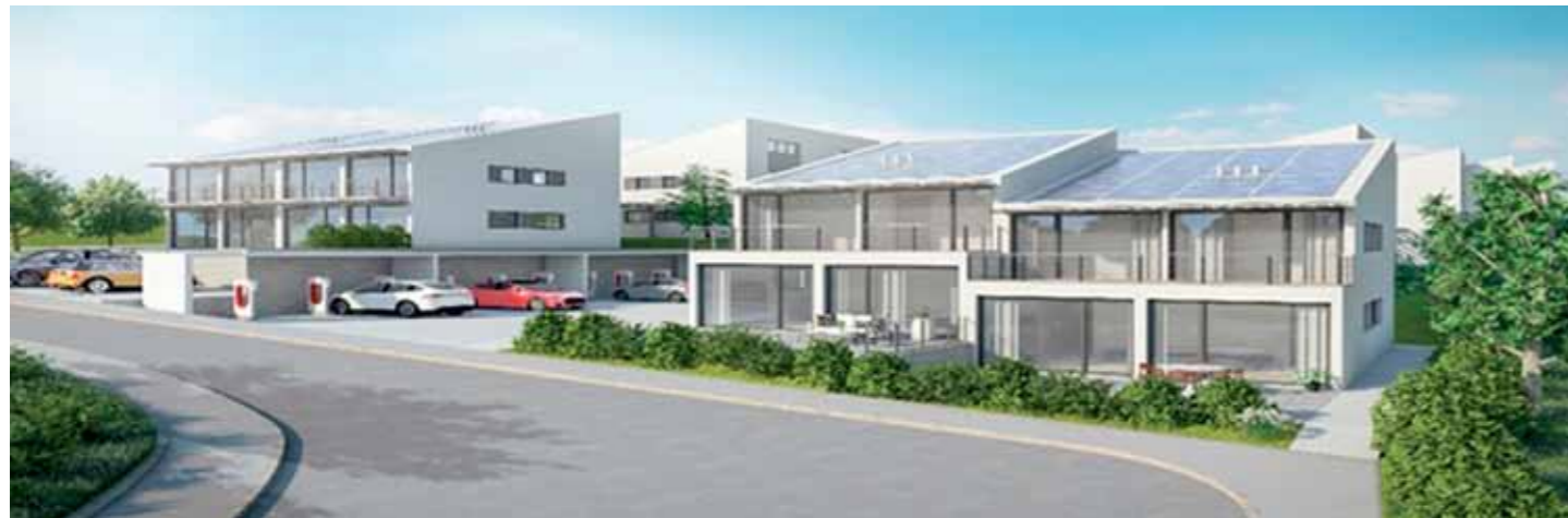
Das Solar Quartier ist Teil des Neubaugebietes „In den Weingärten“ und wird als energieautarkes Wohnmodell mit 28 Häusern erschlossen.
