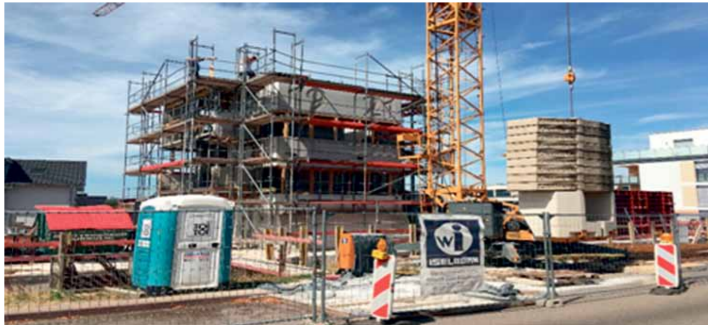
Rege Bautätigkeit auf der Baustelle Schubertstraße 19-21.
