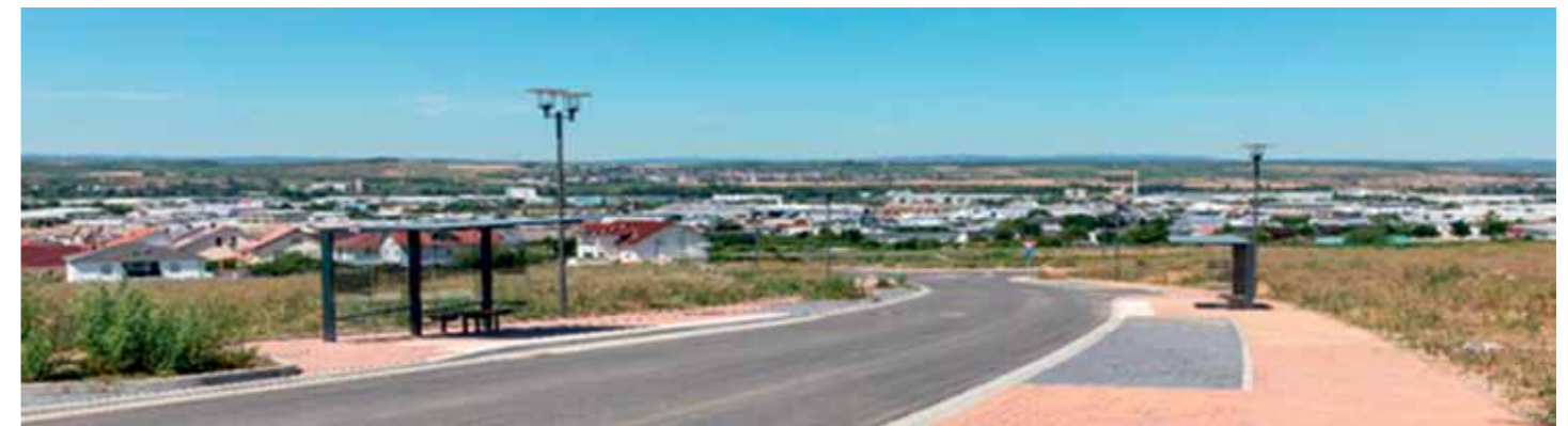
2. Bauabschnitt, Abschnitt Dürerstraße, Bushaltestellen
