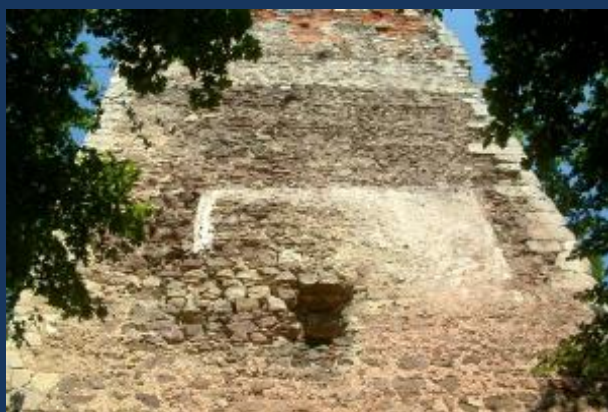
Stupčanica – srednjovjekovno-turska utvrda
