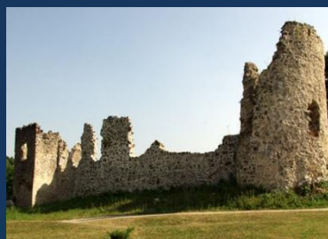
Utvrda grad Barilović
