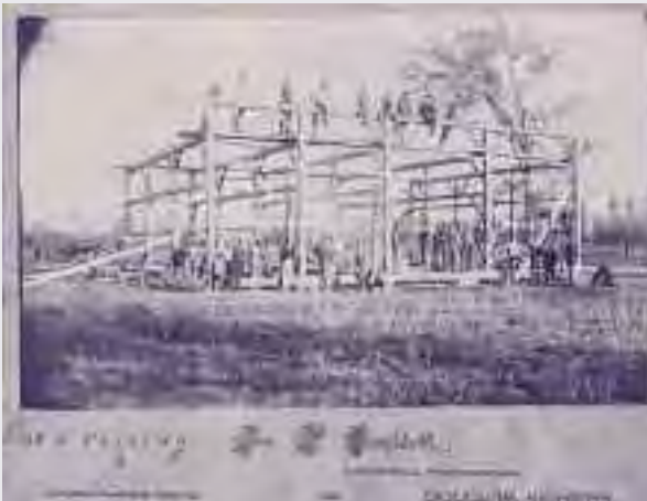
Bau einer Scheune auf dem Hof Bouws in 1912.
