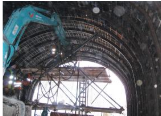
Vrtání injekčních zavrtávaných tyčí typu R 25
