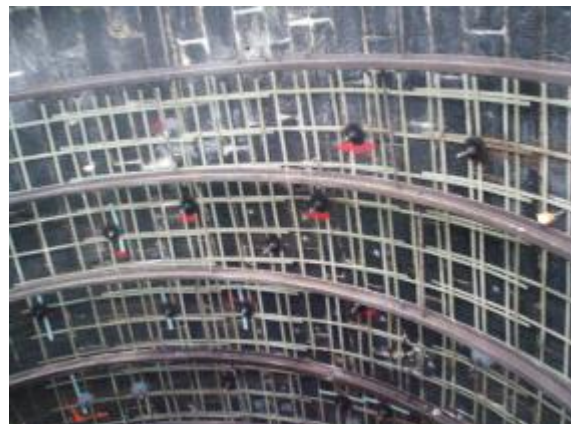
Přikotvené sítě před demontáží podsružení
