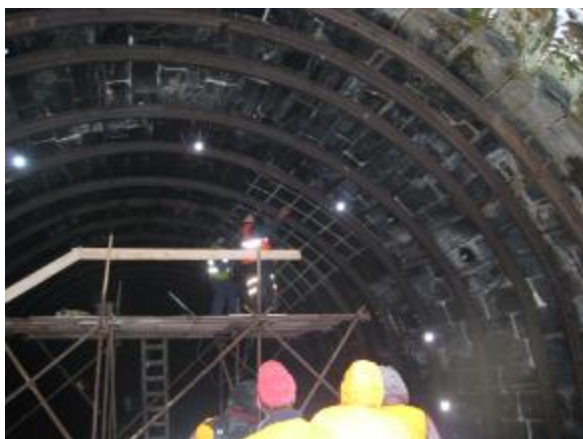
Montáž výztužných sítí
