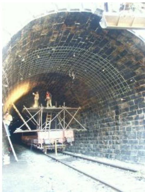
Výztužné sítě v klenbě po odstranění podsukružení
