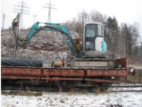
Vrtací souprava Morath na minibagru Kobelco umístěná na plošinovém vagonu
