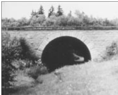
Parabolický most přes místní potok u Hořic.
