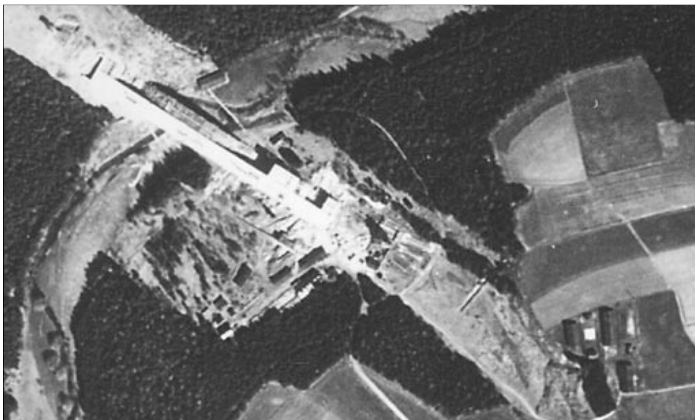
Most přes údolí Sedlického potoka 1949
