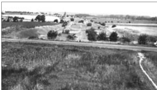
Dálniční těleso v oblouku u Průhonic.
