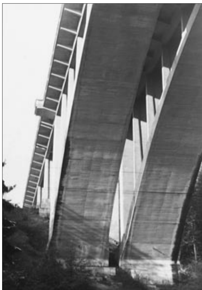
Podhled mostu přes údolí Šmejalky u Senohrab (firma Dr. K. Skorkovský, Praha).
