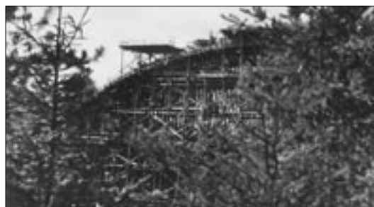
Stavba mostu přes údolí potoka Šmejalky (stavební díl 7/1) v roce 1941.
