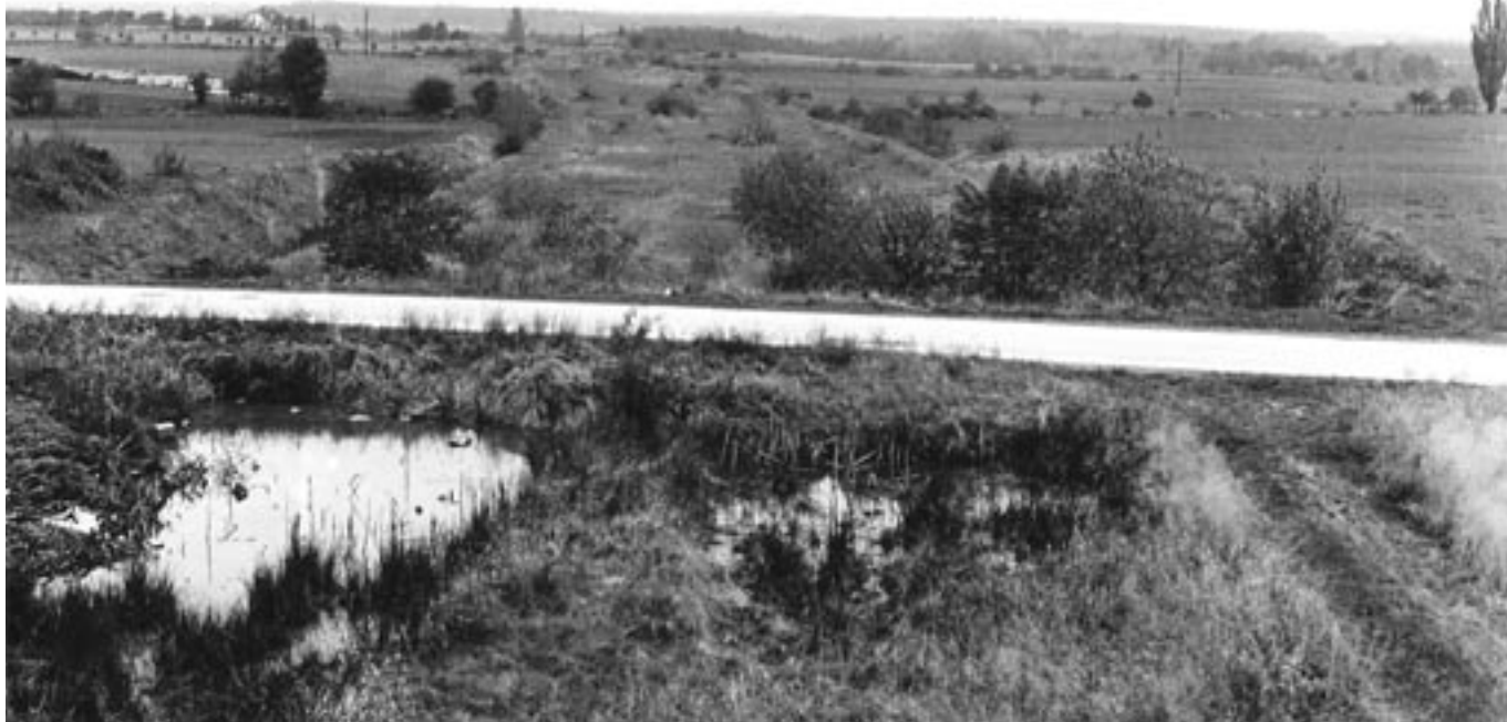
Opuštěné zemní těleso dálnice, přerušené zatím nepřeloženou silnicí Průhonice - Čestlice, v oblouku u Průhonice v polovině šedesátých let.
