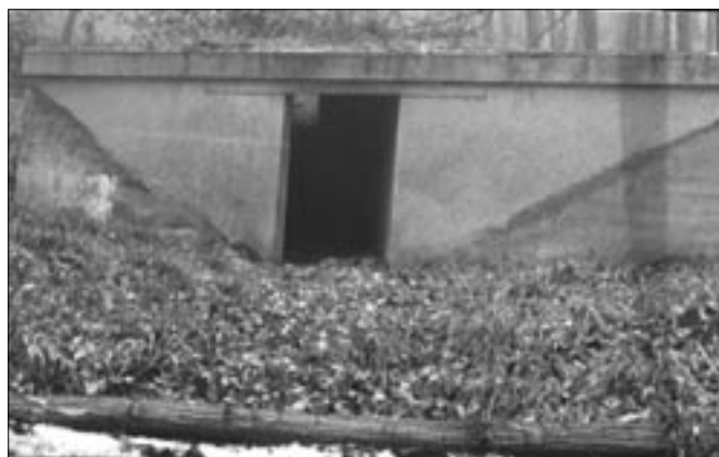
Propustek ve stoupání k hájovně Vlčák.
