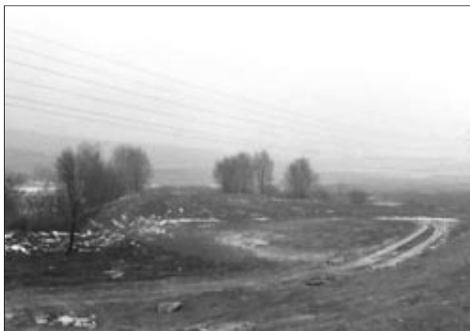
Rozestavěná křižovatka dálnice Praha - Brno - slovenská hranice s německou dálnicí Breslau - Wien u Ostopovic (dnes Brno).
