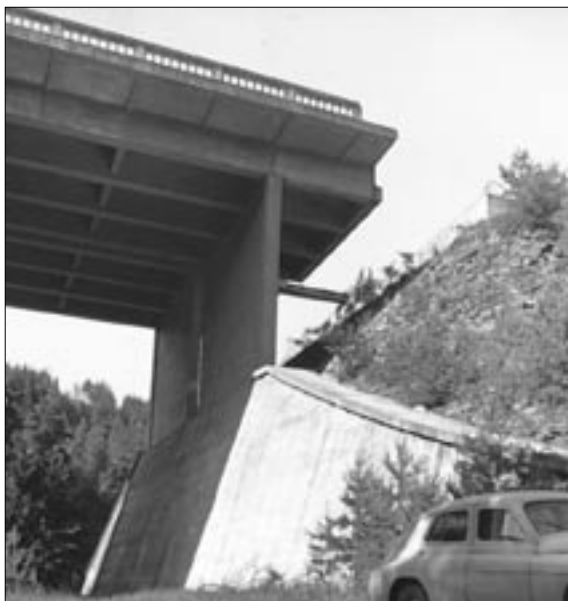
Odstaněná pokleslá skruž a výztuž krajního (jihlavského) pole mostu přes údolí Želivky u Píště (foto v roce 1965).
