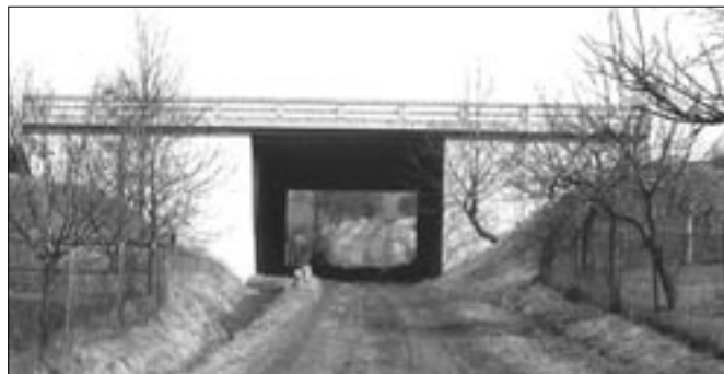
Most přes polní cestu v Zástřizlech.
