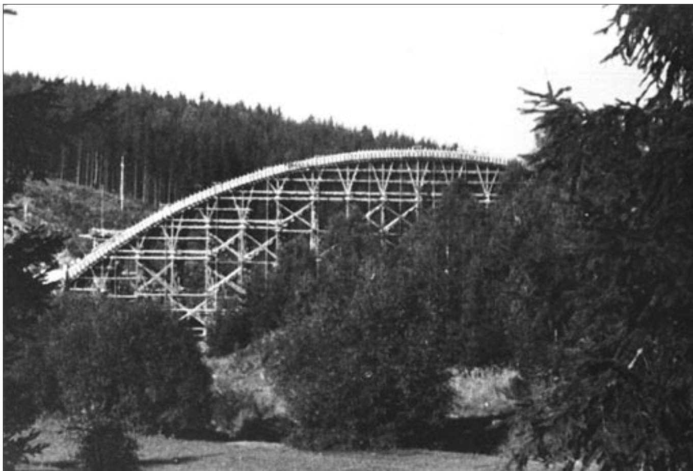
Stavba mostu přes údolí Sedlického potoka (stavební díl 10/2), skruž oblouku pravého mostu v roce 1941.
