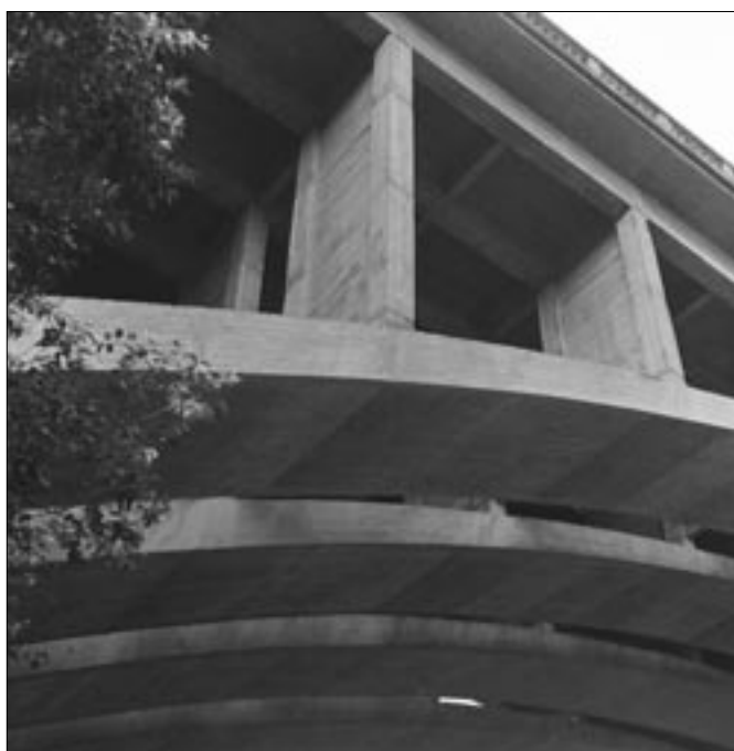
Spolupůsobení mostovky s obloukem na mostě přes údolí Sedlického potoka u Borovska (firma Ing. J. Domanský, Praha).
