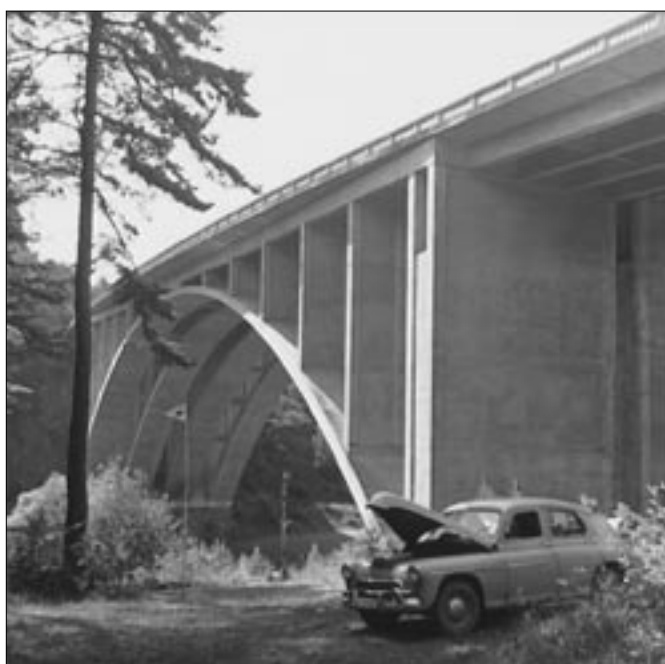
Most přes údolí Želivky u Píště (firma Ing. Brázdil a Dr. Ješ, Praha).
