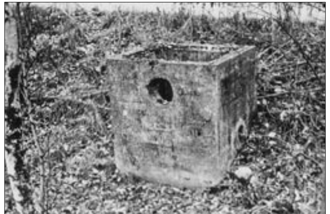
Středová kanalizace v nedokončeném středním dělicím pásu.
