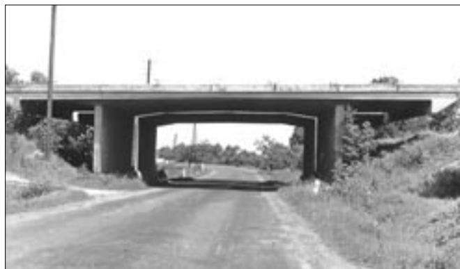
Most přes silnici I. třídy, plánovanou jako dálkový spoj Plzeň - Moravská Ostrava v místě rozestavěné křižovatky u obce Loket.
