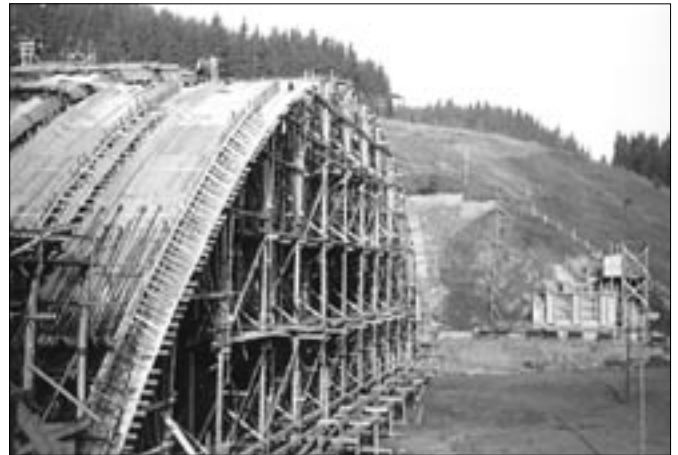
Skruž levého mostu (pohled proti směru staničení) přes údolí Želivky u Píště (stavební díl 12/1) v létě 1941. Oblouky pravého mostu jsou v té době již vybetonovány.
