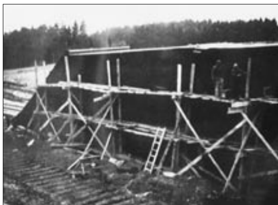
Izolace opěry mostu přes železniční trať Benešov - Dolní Kralovice u zastávky Borovsko (stavební díl 11/1) v prosinci 1940.
