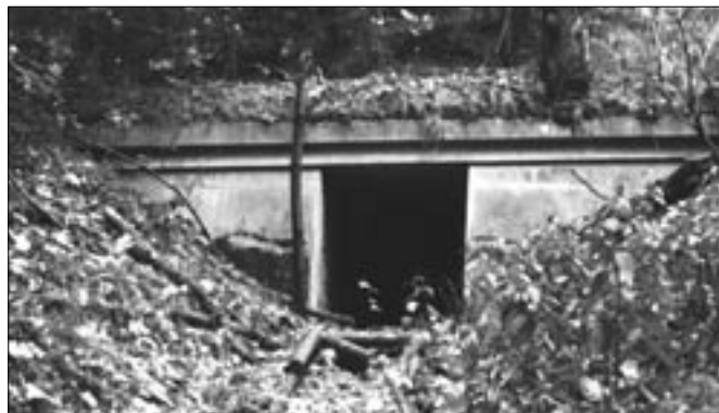
Deskový propustek v klesání z Bunče do údolí Jankovického potoka.
