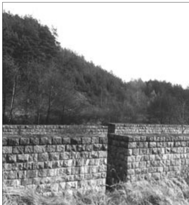
Nedokončený most přes údolí Zlatého potoka u Božkova (firma Ing. Radim Matolín, Praha).
