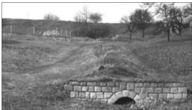
Propustek na plánované přeložce silnice III/43220 v Kostelanech, v pozadí násep dálnice s propustkem.
