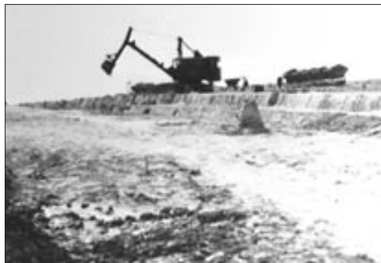
Práce lžicového rypadla (stavební díl 11/1).
