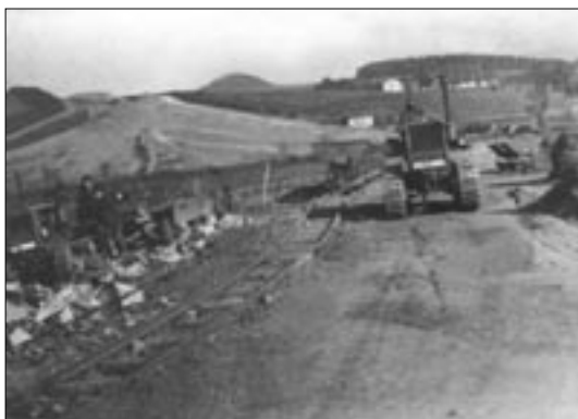
Zemní práce u říčky Býkovky v roce 1940, na snímku vidíme dva pásové traktory Hanomag
