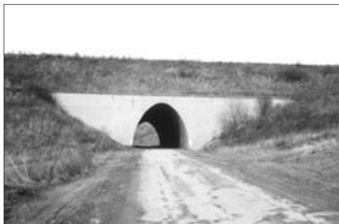
Most přes silnici III/37415 ve velkém náspu u Bačova.
