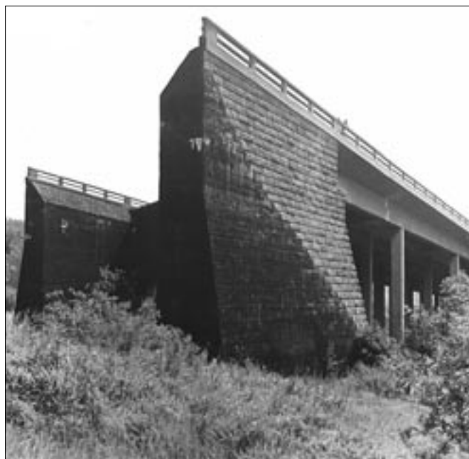
Pražská opěra mostu přes údolí Zlatého potoka u Kunic (firma Českomoravská stavební a.s., Praha).
