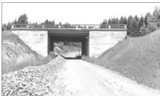
Most přes silnici Děkanovice – Studený.
