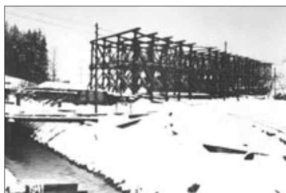
Budování skruže levého mostu přes údolí Božkovského (Zlatého) potoka u Kunic (stavební díl 6/2) v dubnu 1941.
