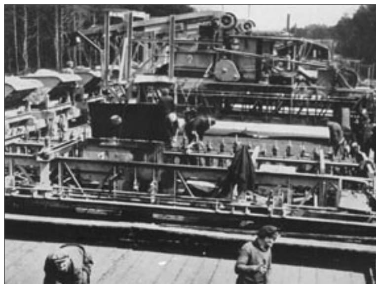
Betonáž vozovky na Německé dálnici 1938
