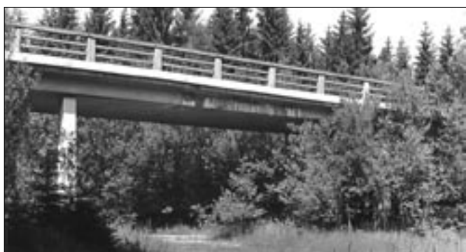
Most přes dálnici na lesní cestě Děkanovice - Lhota-Bubeneč.
