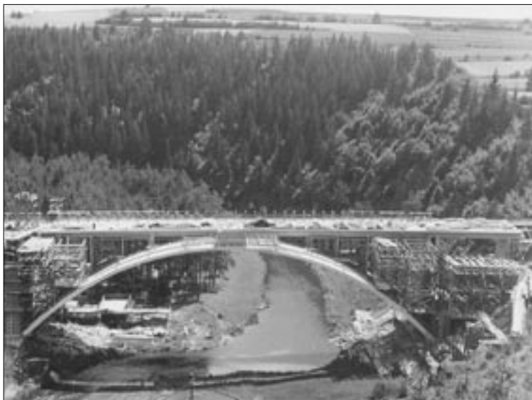
Dokončování mostu přes údolí Želivky (stavební díl 12/1) firmou Ing. Brázdil a Dr. Ješ v roce 1947.
