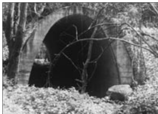
Nedokončený parabolický propust u Žernovníka
