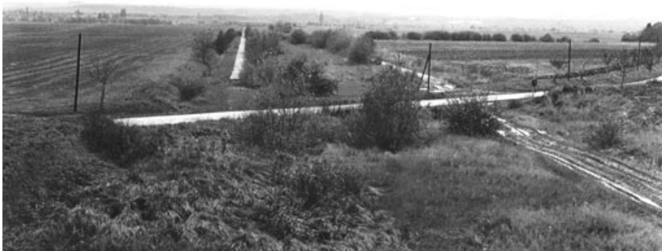
Oba vybetonované odstavné pruhy při pohledu z mostu pro silnici Čestlice - Dobřejovice (ta na něj prozatím není převedena a rušivě přetíná těleso dálnice) směrem ku Praze. Na levé straně obrázku lze posoudit estetické působení široké nezpevněné krajnice. Je listopad 1966.
