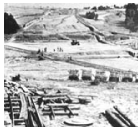
Práce v okolí parabolického propustku u Hořic (stavební díl 12/1), srpen 1939.
