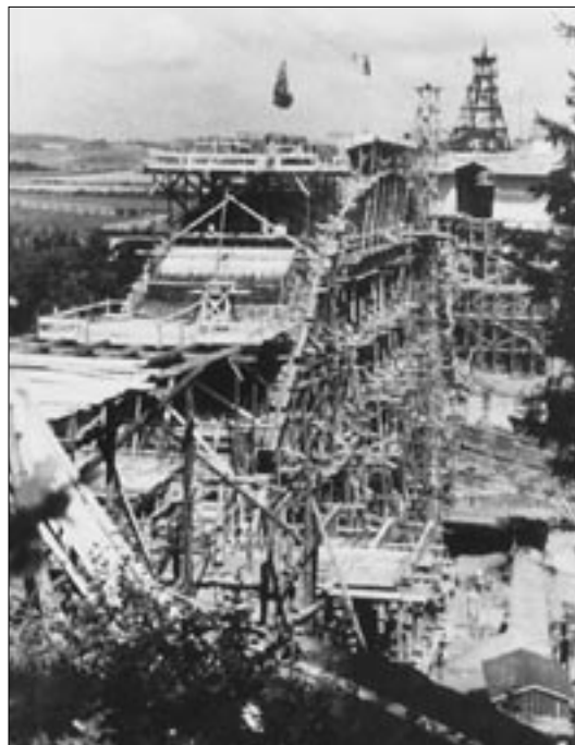
Stavba mostu přes údolí potoka Šmejalky (stavební díl 7/1) v roce 1941 (betonáž pravého oblouku).
