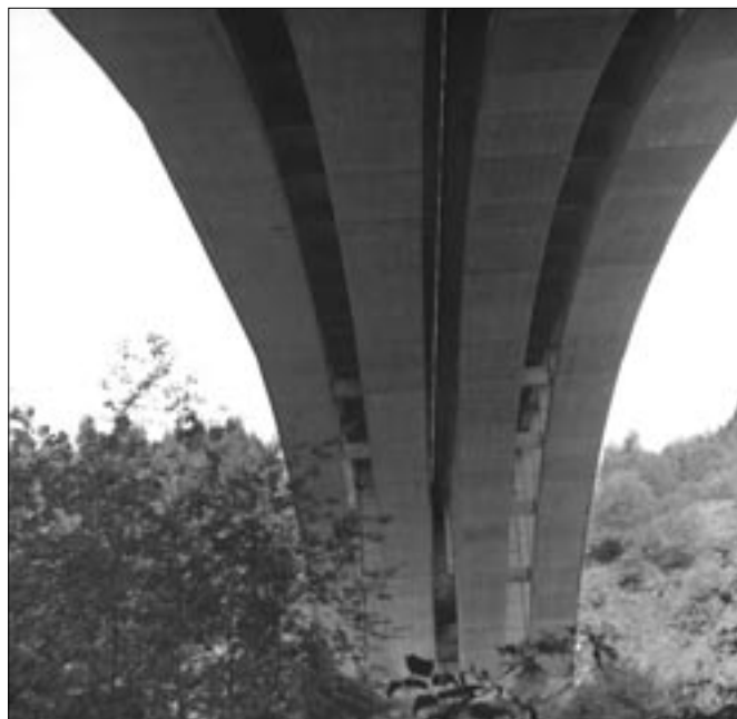
Podhled mostu přes údolí Sedlického potoka u Borovska (firma Ing. J. Domanský, Praha).
