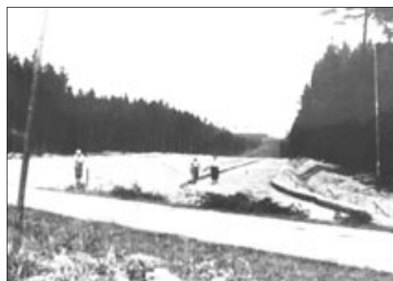
Stavba v dílu 11/1 (v pozadí 10/2), srpen 1940.
