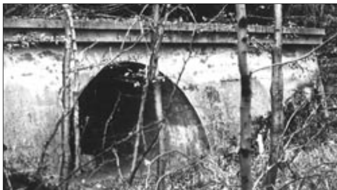
Propustek v úseku Vlčák – Bunč.
