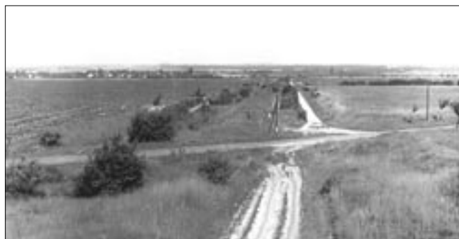
Dálniční těleso s vybetonovanými odstavnými pruhy u Čestlic.
