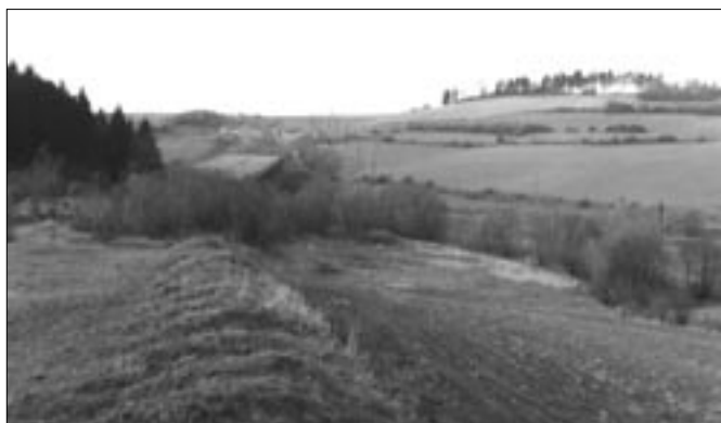
Dálniční těleso v okolí mostu u Kunic.
