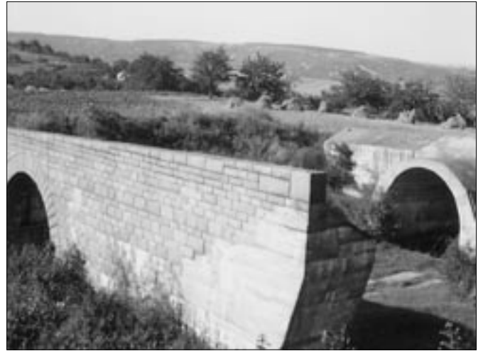
Nedokončený most přes polní cestu u Ostopovic.
