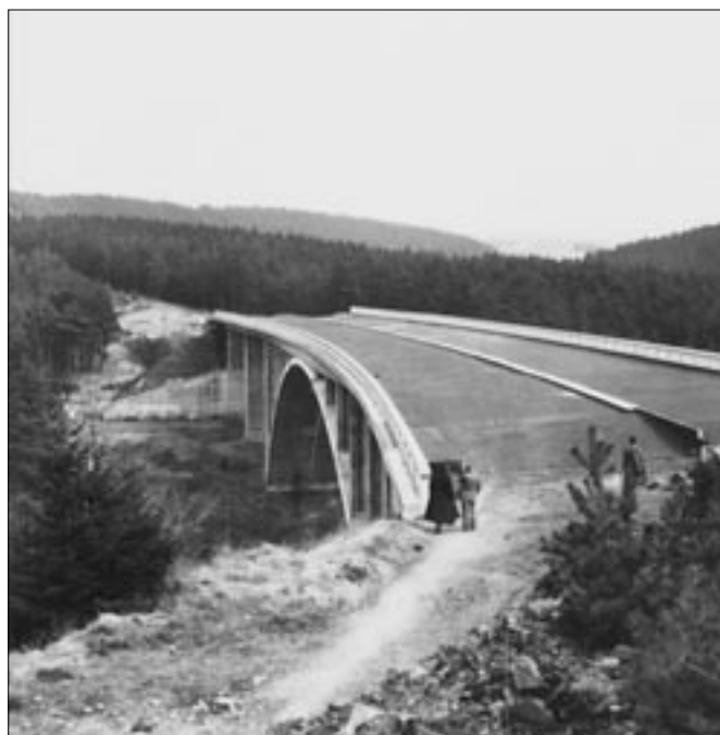
Most přes údolí Želivky u Píště ve směrovém oblouku trasy (firma Ing. Brázdil a Dr. Ješ, Praha).
