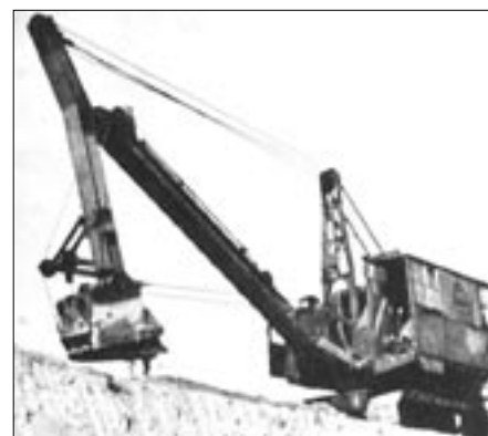
Práce lžicového rypadla (stavební díl 11/1).
