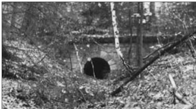
Trubní propustek v klesání z Bunče do údolí Jankovického potoka.
