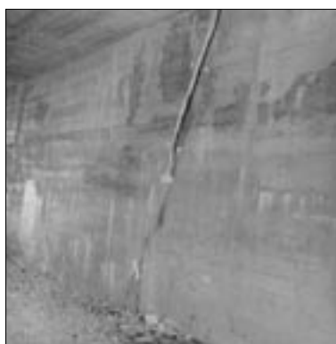
1 – pohled na spáru uvnitř
