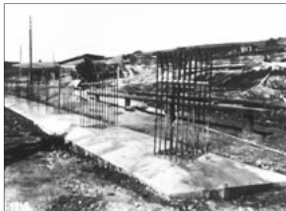
Stavba mostu přes údolí Božkovského (Zlatého) potoka u Kunic (stavební díl 6/2) v srpnu 1940 (kotvení výztuže pevných stojek).
