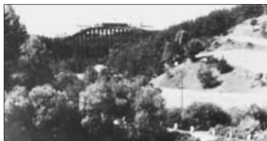
Stavba mostu přes údolí potoka Šmejalky (stavební díl 7/1) v roce 1941 (pohled z údolí).
