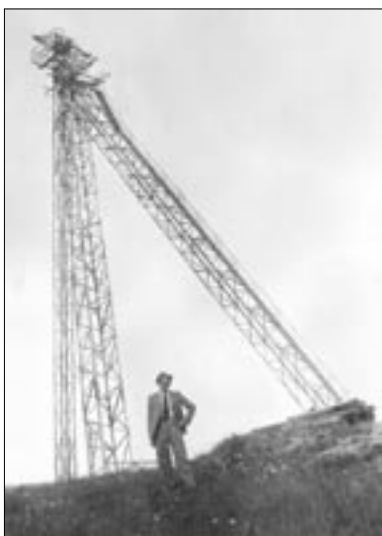
Konstrukce kabelového jeřábu na severní straně údolí říčky Lubě
