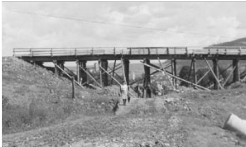
Detailní pohled na most pro stavební drážku
