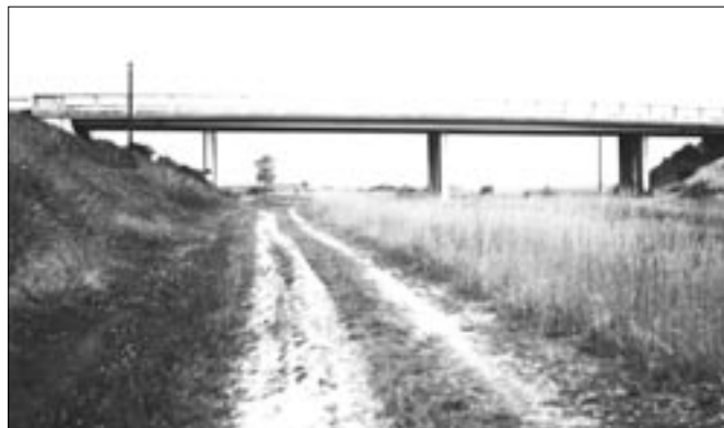
Dálniční těleso v okolí mostu přes dálnici na silnici Újezd - Průhonice (III/0037).
