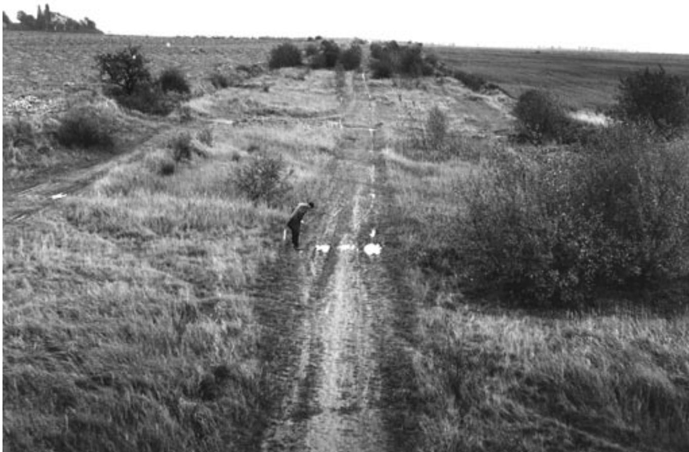
Porostlé dálniční těleso u Průhonic míří na vzdálený horizont. Je zde patrná velká šířka v koruně (28,5 m), navržená pro tento úsek u Prahy. Na obzoru překlenuje trasu most pro silnici Čestlice - Dobřejšovice.
