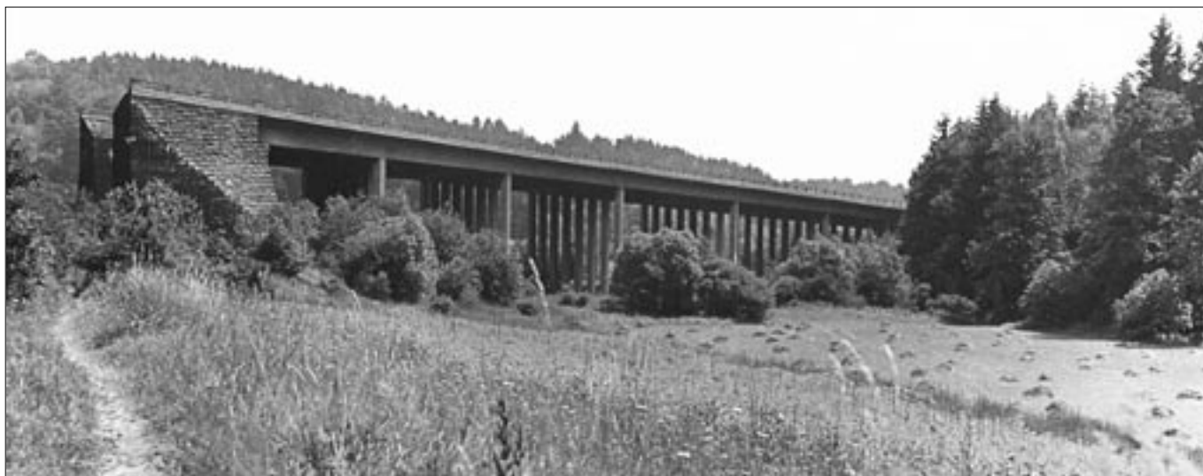
Most přes údolí Zlatého potoka u Kunic (firma Českomoravská stavební a.s., Praha).
