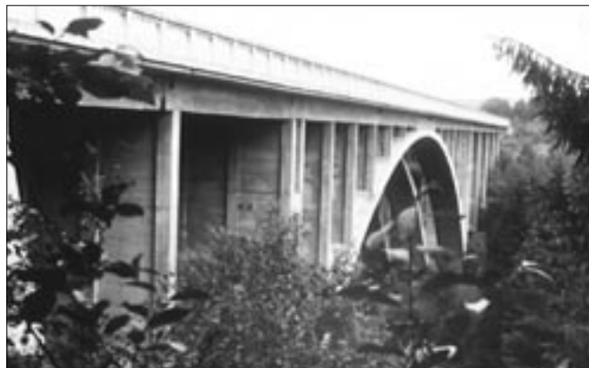
Most přes údolí Sedlického potoka u Borovska (firma Ing. J. Domanský, Praha).
