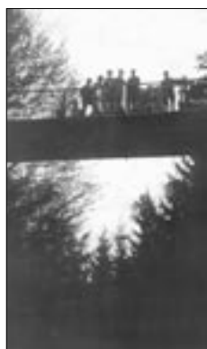
Most stavební drážky u Žernovníka
