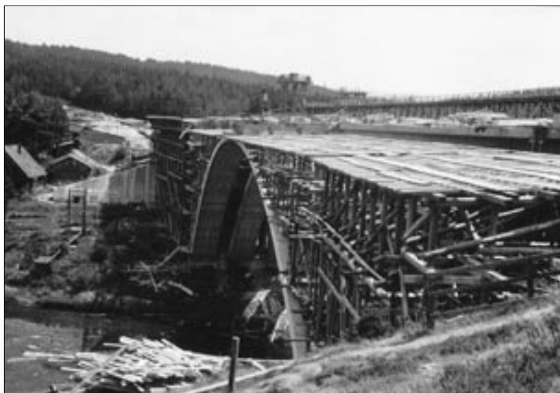
Stavba mostu přes údolí Želivky (stavební díl 12/1) firmou Ing. Brázdil a Dr. Ješ v roce 1948.
