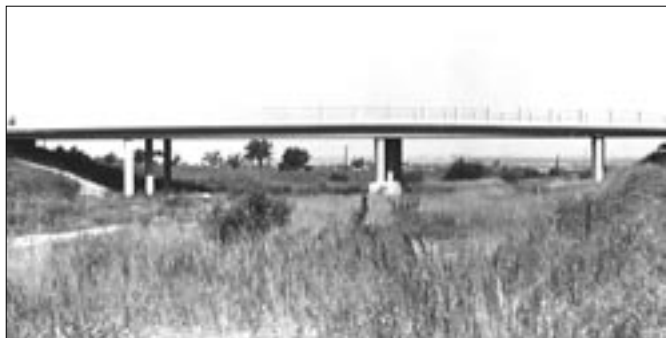
Most přes dálnici na silnici Průhonice - Čestlice (III/0039).
