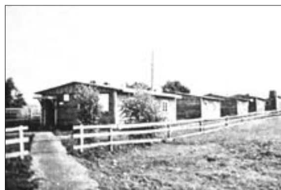
Ubytovací baráky firmy Jelínek (stavební díl 11/1).
