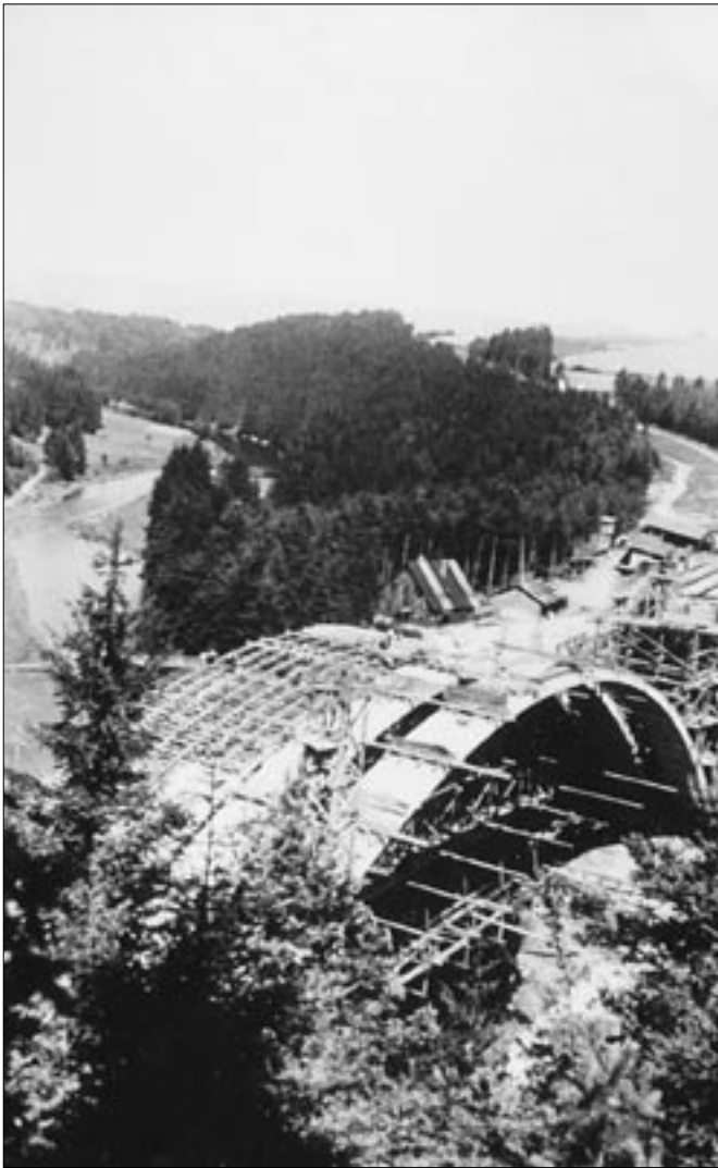
Stavba mostu přes údolí Želivky u Píště (stavební díl 12/1) v roce 1941.
