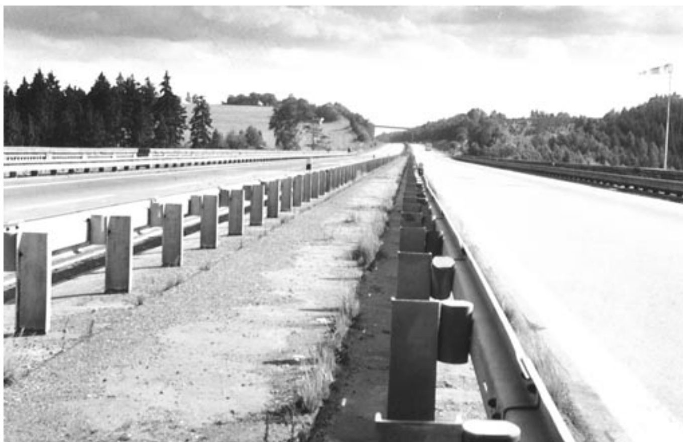
Dálnice D1 na mostě u Senohrab v osmdesátých letech.
