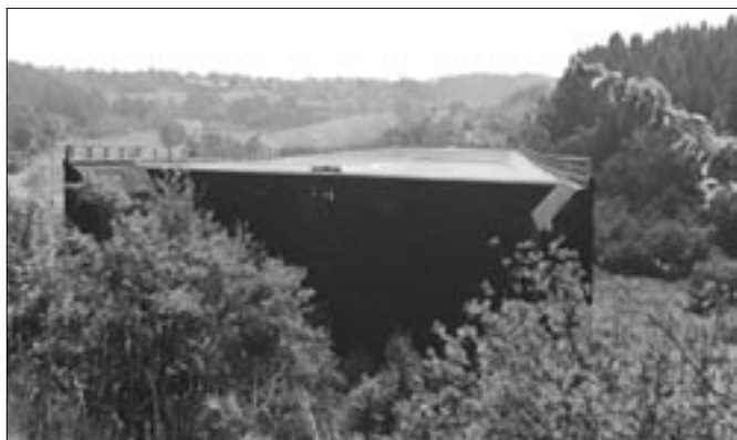
Most přes údolí Zlatého potoka u Kunic (firma Českomoravská stavební a.s., Praha).
