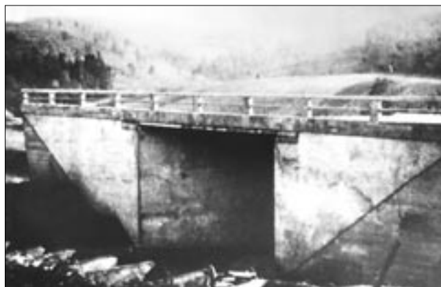
Most přes místní potok u Zástřízel (trať III - Chříby) po dokončení hrubé stavby v roce 1940.
