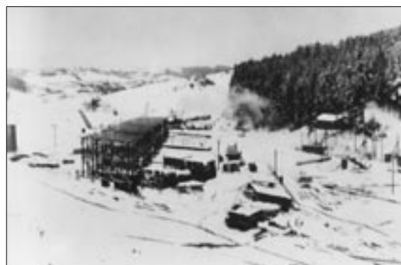
Staveniště mostu přes údolí Božkovského (Zlatého) potoka u Kunic (stavební díl 6/2) v dubnu 1941.
