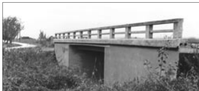
Most přes silnici III/00325 u Jažlovic.
