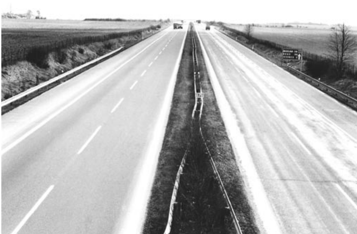
Dálnice D1 u Průhonic v osmdesátých letech. Do Brna zbývá 190 km.
