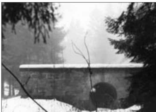
Dokončený trubní propust u Žernovníka
