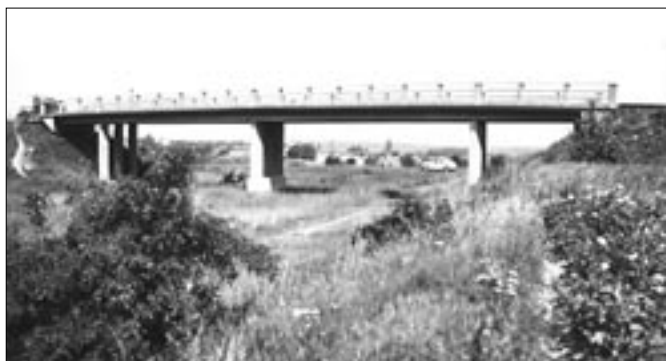
Most přes dálnici na silnici III/00311 u Čestlic.
