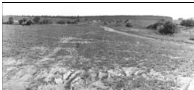
Dálniční těleso u Soutic.
