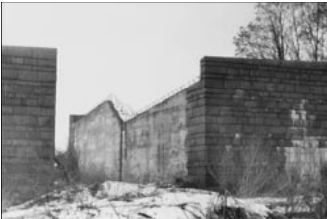
Nedokončený most se samostatně klopenými vozovkami v oblouku u Nebovic.
