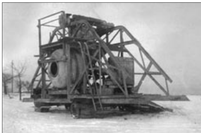
Míchačka na beton. Stavenišťe mostu přes údolí Hlubockého potoka
