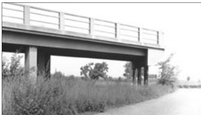
Most přes dálnici na silnici Jažlovice - Předboř (III/00321).
