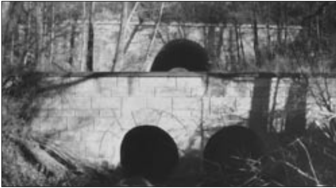
Patrový most přes potok Vrbovec a polní cestu.
