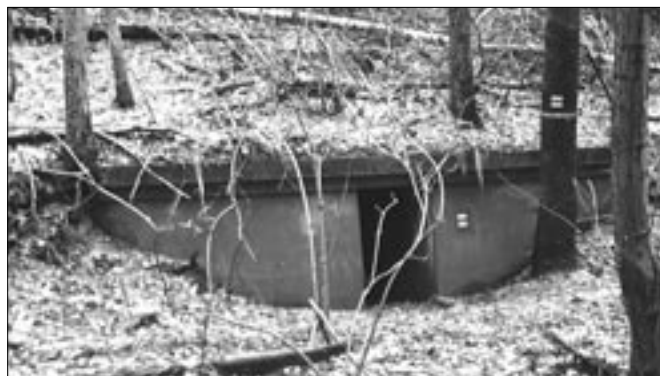
Severní čelo propustku v částečně dokončeném náspu nedaleko Bunče.
