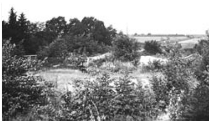
Dálniční těleso v okolí mostu přes Botič.
