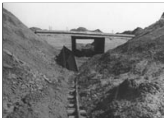
5 – sklonění římsy nad skleslou částí pilíře
