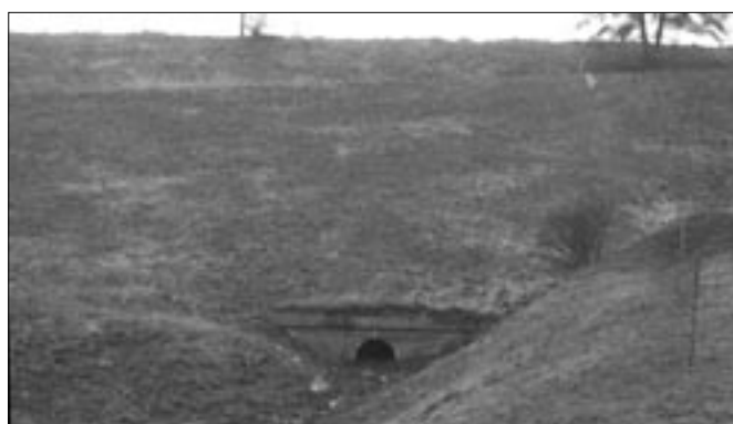
Velký násep s propustkem u Kostelan.
