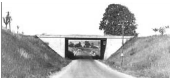
Most přes silnici Vlašim - Zruč nad Sázavou u Soutic.
