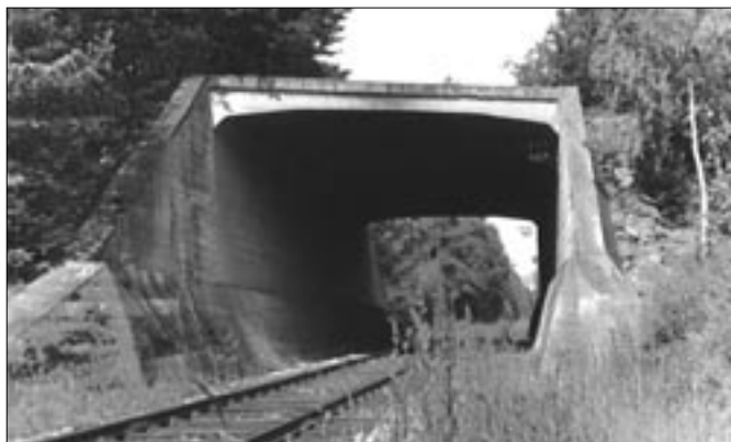
Most přes železniční trať Benešov - Dolní Kralovice v blízkosti zastávky Borovsko.
