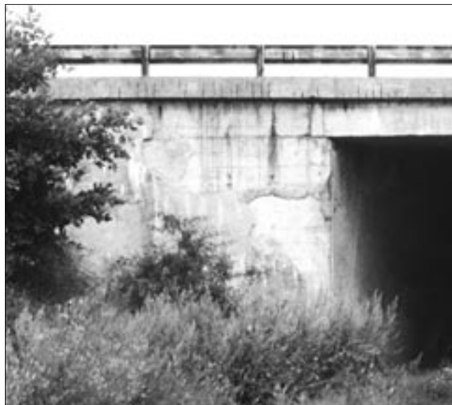
Vzhled dálničního mostu přes silnici III. třídy, budovaného na přelomu šedesátých a sedmdesátých let.
