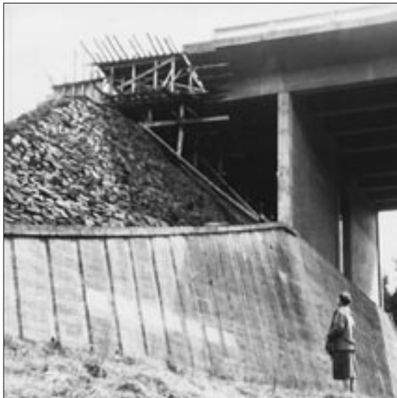
Nedokončené krajní (jihlavské) pole mostu přes údolí Želivky u Píště (foto v roce 1956).
