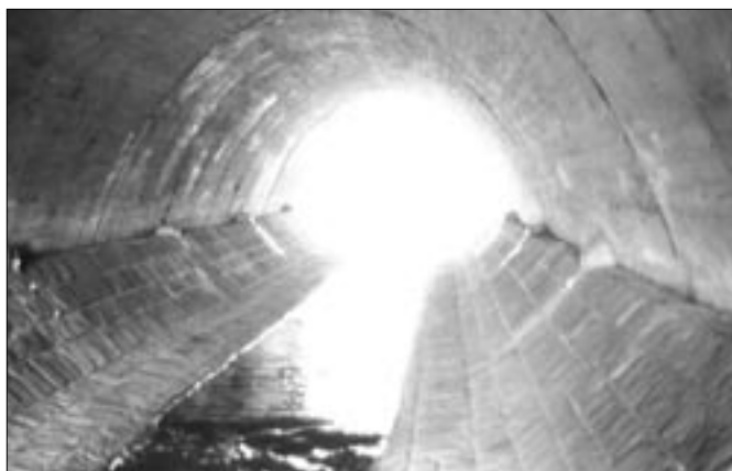
Detail koryta a klenby mostu přes říčku Kuřimku u Moravských Knínic.
