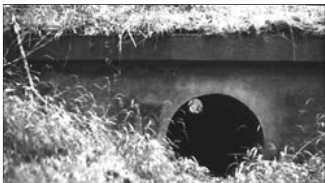
Propustek nedaleko hájovny Zamočidla.
