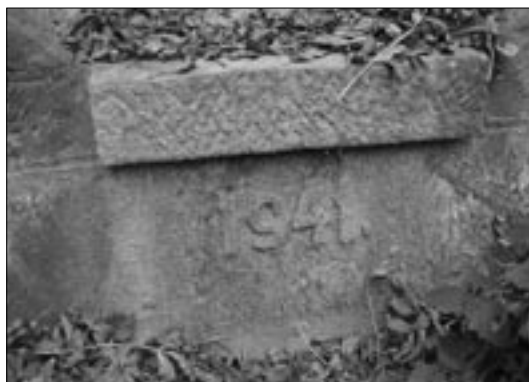
Detail označení roku výstavby trubní propusti u Žernovníka
