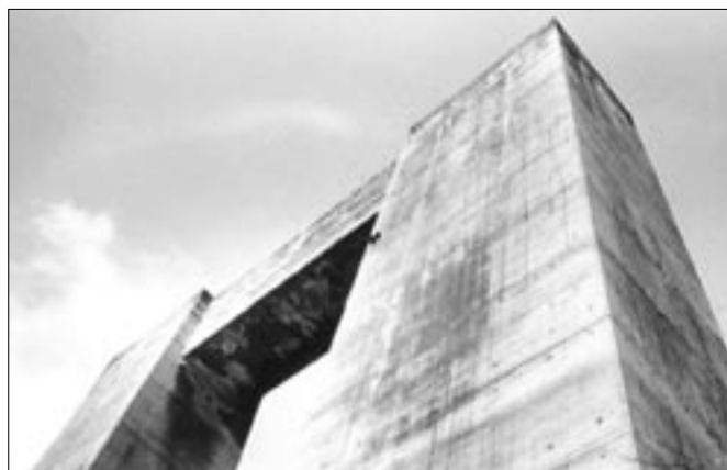
Rozestavěný viadukt přes údolí Svratky u Kníničské přehrady.
