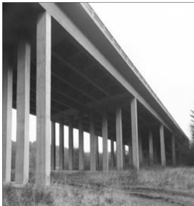
Podhled mostu přes údolí Zlatého potoka u Kunic (firma Českomoravská stavební a.s., Praha).
