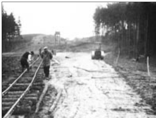
Výstavba dálnice Breslau - Wien v okolí Černé Hory. Pracuje zde firma Hrabě a Lozovský, kterou již známe ze stavebního dílu 5/1 (u Prahy) naší dálnice.
