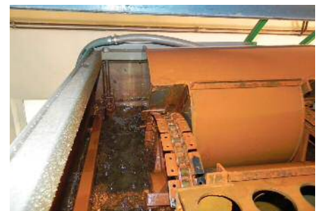
Blick in den oberen Teil des Auftriebskraftwerks mit einem Transportrad und den Auftriebsbehältern.
