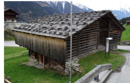
Untersuchungen ergaben, dass das Holz des Mitterstalls zwischen 1710 und 1712 in den umliegenden Wäldern geschlägert worden war, die am Firstbalken vermerkte Jahreszahl 1715 dürfte den Bauabschluss markieren. In den nächsten Jahrhunderten wurde das Gebäude ohne größere Umbauten in derselben Weise genutzt, bis die strukturellen Veränderungen der letzten Jahrzehnte des 20.Jh. beinahe seinen Verfall herbeigeführt hätten.
