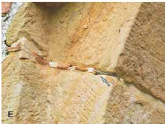
Abb. 88: Schieferplatten als Zwischenlagen. A Herzfeld, kath. Pfarrkirche St. Ida, Krypta mit Fundamentresten des Chors der karolingischen Kirche, um 800, Schieferplatten zwischen a Sinterkalksteinen von Salzkotten, die auf b Bruchsteinen des untercampanen Stromberg-Members lagern, B Münster, St. Paulus Dom, spätes 12. Jh., Werksteinsockel Nordturm, Nordseite, Schieferplatten zwischen Quadern aus Bentheimer Sandstein, C Nottuln, kath. Pfarrkirche St. Martin, ehem. Stiftskirche, 1489 begonnen, Schieferplatten in Lagerfuge zwischen Bentheimer Sandstein als Fundament sowie Baumberger Sandstein und in Lager- sowie Stoßfugen der Quader aus Baumberger Sandstein, D Lippstadt, ehemaliges Augustinerinnen-Stift, Südtor, Alter unklar, Schieferplatten zwischen Quadern aus Soester Grünsandstein im Bereich des Bogens, E Herzebrock, ehemaliges Klostertor, Anfang 18. Jh., Schieferplatten in Kombination mit Ziegelsteinabschlägen im Torbogen, F Nienberge, Haus Rüschaus, 1745-1748, Fundament an der Ostseite, Schieferplatten als Feuchtigkeitssperre zwischen nordischem Geschiebe als Fundament und Ziegelsteinen sowie Werksteinen aus Baumberger Sandstein als Sockelmauerwerk.
