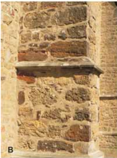
Abb. 35: Sandsteine der Haltern-Formation, kath. Pfarrkirche St. Maria Magdalena, Haltern. A Turm und Langhaus-Südseite, B Strebpfeiler Langhaus-Südseite, C Eisenschwartenstein, Langhaus-Südseite.
