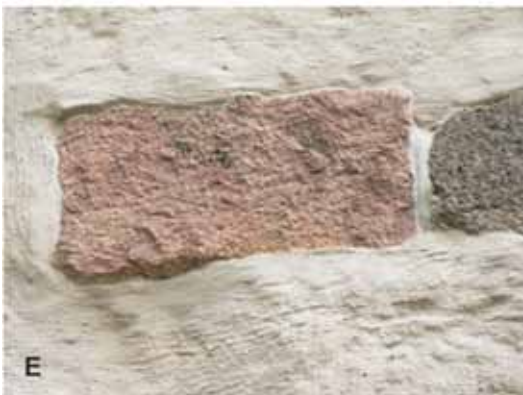
Abb. 79: Kristallines nordisches Geschiebe. A Darfeld, Zufahrt zum Schloss, B Rinkerode, Haus Borg, 1717, Ostseite der Wirtschaftsgebäude, im Fundament Findling im Verband mit turbiditischen Bruchsteinen des Vorhelm-Members und Ziegelsteinen. C Everswinkel, kath. Pfarrkirche St. Magnus, um 1500, Südseite, Findling im Verband mit turbiditischen Bruchsteinen, des Vorhelm-Members, D Hilstrup, Alte Clemenskirche, Südseite, Findling als Fundament eines Stützpfiebers. E Clarholz, kath. Pfarrkirche St. Laurentius, ehem. Stiftskirche, Nordseite Langhaus im oberen Mauerwerksbereich, F Gahlen Dorfskirche, Turm, spätes 12. Jh., Findling als „guter Stein“ an der rechten Turmseite im Verband mit Sandsteinen der Haltern-Formation.
