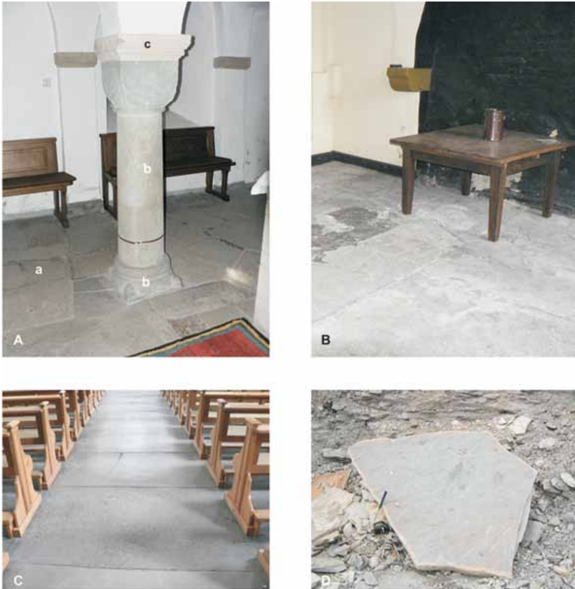
Abb. 64: Deelplatten, historische Bodenplatten aus dem Beckum-Member, Ahlen-Formation. A Freckenhorst, kath. Pfarrkirche St. Bonifatius, Ostteil der Krypta, um 1090, Fußboden vermutlich von der Restaurierung 1850-1852, B Clarholz, Klostergebäude, Probsteiküche, 18. Jh., C Herbern, kath. Pfarrkirche St. Benedikt, 1666, Deelplatten 19. Jh., D Beckum, Steinbruch des Zementwerks Phönix, Deelplatte im Abbaubetrieb, Juni 2003, a Deelplatten des Beckum-Members, b Soester Grünsandstein, c Baumberger Sandstein.
