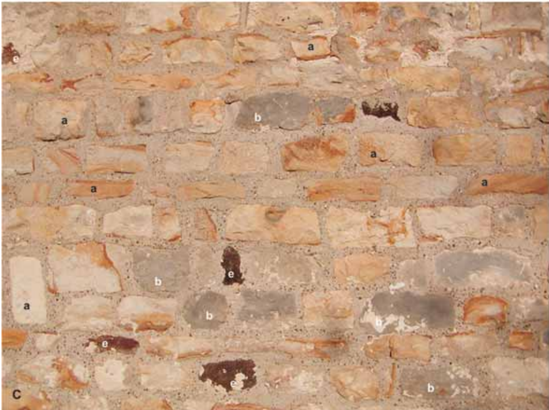
Abb. 9: Sandsteine der Unterkreide aus dem Raum Vreden - Lünten. A-C Vreden, ehemalige Stiftskirche St. Felizitas, A Südseite mit östlichem Langhaus, Südquerhaus und Chor, B Nordquerhaus mit romanischem Portal der benachbarten kriegszerstörten kath. Pfarrkirche St. Georg, C Wandausschnitt westliche Langhaus-Südseite. a Sandsteine der Unterkreide aus dem Raum Vreden - Lünten, b Bentheimer Sandstein, graue Varietät, c Bentheimer Sandstein, rote Varietät, d Baumberger Sandstein, e Raseneisenstein.
