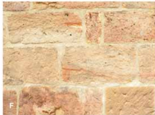
Abb. 19: Osning-Sandstein zwischen Bad Iburg und Riesenbeck. A-C Ledde, ev. Pfarrkirche, A Südseite, 13. Jh., B Südecke Turm, C Detailansicht, Pfeil zeigt auf paläozoische Schiefer als Zwischenlage, D-F Brochterbeck, ev. Pfarrkirche, A Nordseite, B, C Wandausschnitt Südseite, Turm und Umfassungsmauern romanisch, Langhaus spätgotisch.
