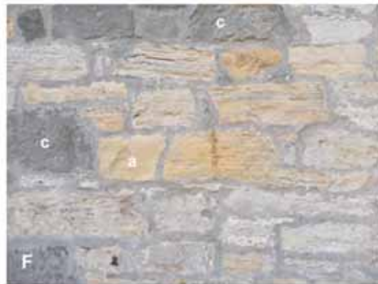
Abb. 84: Muschelkalk. A-C Neuenheerse, kath. Pfarrkirche St. Saturnina, A Turm 1. Viertel 12. Jh., Langhaus, Umbauten 14. Jh., B Langhaus Südseite, C Mauerausschnitt Turm, D Werther, ev. Pfarrkirche, 14. Jh., 1743 erneuert, E-F Hardehausen, Kornhaus, E Südseite, 18. Jh., F Mauerausschnitt Südseite, a Muschelkalk, b Osning-Sandstein, c Buntsandstein.
