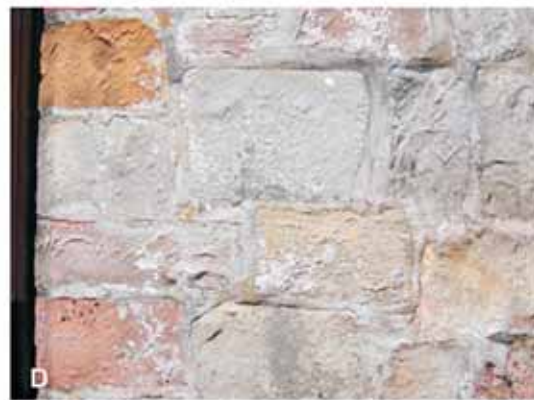
Abb. 7: Bentheimer Sandstein. A, D Ohne, ev.-reform. Kirche, Turm Westseite 13. Jh., A Gesamtansicht, D Mauerwerksauschnitt, B Bad Bentheim, Schloss, Batterieturm, Anfang 15. Jh., C Oldenzaal, St. Plechelmusbasiliek, Langhaus-Südseite, um 1580.
