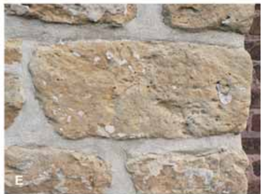
Abb. 34: Sandsteine der Haltern-Formation. A Schermbeck, Wirtschaftsgebäude des Wasserschlosses Schermbeck, B Hamm-Bossendorf, Kapelle St. Katharina, älteste Teile 11. Jh., C Lembeck, westliches Torhaus des Wasserschlosses Lembeck, 1692, D Recklinghausen, Mauerwerkauausschnitt der Ostseite der kath. Probsteikirche St. Petrus, 1652 - 1670, quarzitische Sandsteine der Haltern-Formation, E Hervest, kath. Pfarrkirche St. Paulus, Chor, um 1500, Strebepefeilerquader, a Sandsteine der Haltern-Formation, b Baumerger Sandstein.
