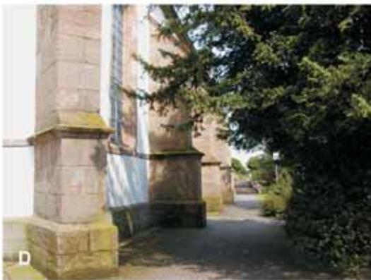
Abb. 22: Osning-Sandstein, Bevergerner Sandstein. A-C Bevergern, St. Mariä Heimsuchung, A-B Westturm, A Ansicht von Westen, B Südweststecke, C Mauerwerksausschnitt Langhaus-Nordwand, D-E Hopsten, kath. Pfarrkirche St. Georg. D Langhaus-Südseite, E Strebepfeiler, 1727-1732.
