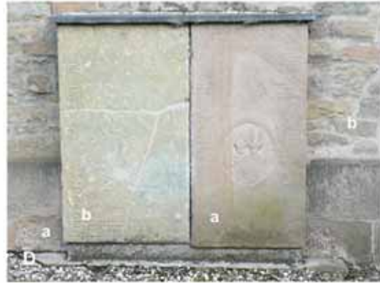
Abb. 80: Ruhrsandstein. A-B Unna, ev. Stadtkirche, 1322 - 1467, A Chor, Nordseite, B Sockel Südseite, C-D Hemmerde, ev. Pfarrkirche, 12. - 14. Jh., C Langhaus-Südseite, D Epitaphe an der Langhaus-Nordseite, a Ruhrsandstein, b Soester Grünsandstein, c Baumberger Sandstein, d paläozooische Schiefer als Zwischenlage.
