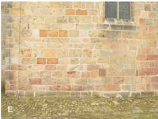
Abb. 19: Osning-Sandstein zwischen Bad Iburg und Riesenbeck. A-C Ledde, ev. Pfarrkirche, A Südseite, 13. Jh., B Südecke Turm, C Detailansicht, Pfeil zeigt auf paläozoische Schiefer als Zwischenlage, D-F Brochterbeck, ev. Pfarrkirche, A Nordseite, B, C Wandausschnitt Südseite, Turm und Umfassungsmauern romanisch, Langhaus spätgotisch.
