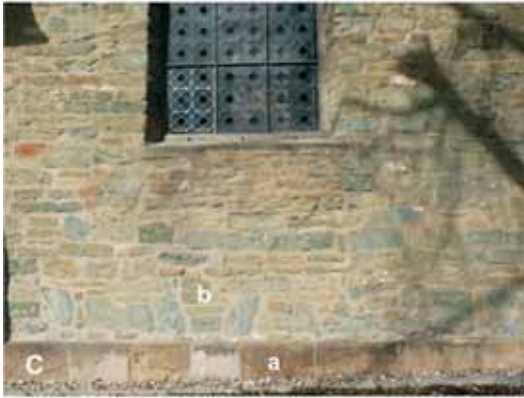
Abb. 80: Ruhrsandstein. A-B Unna, ev. Stadtkirche, 1322 - 1467, A Chor, Nordseite, B Sockel Südseite, C-D Hemmerde, ev. Pfarrkirche, 12. - 14. Jh., C Langhaus-Südseite, D Epitaphe an der Langhaus-Nordseite, a Ruhrsandstein, b Soester Grünsandstein, c Baumberger Sandstein, d paläozooische Schiefer als Zwischenlage.
