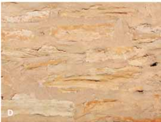
Abb. 65: Turbiditische Bruchsteine des Vorhelm-Members, Ahlen-Formation. A, D Freckenhorst, kath. Pfarrkirche St. Bonifatius, A Westseite, 11. Jh., D Südwestturm, Wand- ausschnitt, B, C Drensteinfurt, kath. Pfarrkirche St. Regina, B Westseite, C Mauerausschnitt, E Telgte, Haus Münsterstraße 6, freigelegter historischer Kellerfußboden, a Kalkturbidite des Vorhelm-Members, b Werksteine des Beckum-Members, Ersatz des 19. Jh., c Osning-Sandstein, Ersatz des 19. Jh., d Baumberger Sandstein.
