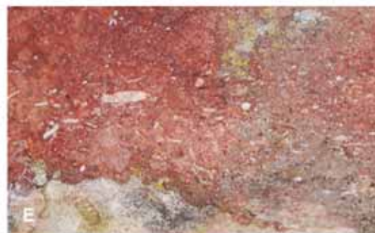
Abb. 56: Kalkarenite der Burgsteinfurt-Formation. A, E Langenhorst, kath. Pfarrkirche St. Johannes d. T., Ende 12. Jh. - 1230, A Südseite mit Südostquerhaus, Südostturm und Chor, E Detailansicht Langhaus-Nordseite, B, D Enschede (NL), Grote Kerk, B romanischer Turm, um 1250, D romanischer Turm, Detailansicht Westseite, C Burgsteinfurt, ev. Große Kirche, Langhaus-Südseite, Ende 14. Jh., a Kalkarenite der Burgsteinfurt-Formation, b Bentheimer Sandstein.
