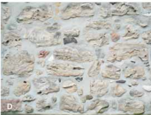
Abb. 34: Sandsteine der Haltern-Formation. A Schermbeck, Wirtschaftsgebäude des Wasserschlosses Schermbeck, B Hamm-Bossendorf, Kapelle St. Katharina, älteste Teile 11. Jh., C Lembeck, westliches Torhaus des Wasserschlosses Lembeck, 1692, D Recklinghausen, Mauerwerkauausschnitt der Ostseite der kath. Probsteikirche St. Petrus, 1652 - 1670, quarzitische Sandsteine der Haltern-Formation, E Hervest, kath. Pfarrkirche St. Paulus, Chor, um 1500, Strebepefeilerquader, a Sandsteine der Haltern-Formation, b Baumerger Sandstein.
