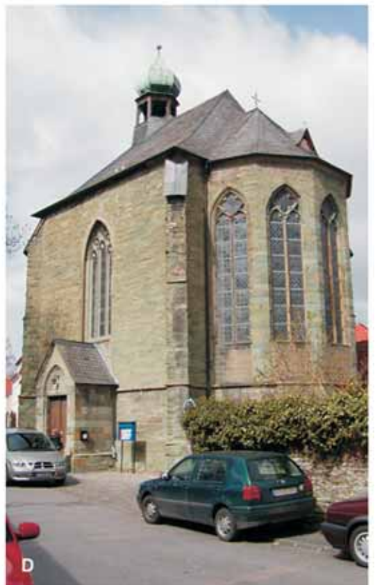
Abb. 51: Soester Grünsandstein als Naturbaustein im Stadtgebiet von Soest. A-C Kath. Probsteikirche St. Patrokli, 11. Jh. - 12. Jh., A Turm Westfront, B Wandausschnitt Langhaus-Nordseite, C Kreuzgang, D Ev. Brunstein-Kapelle, Süd- und Ostseite, a Soester Grünsandstein, b Rühthener Grünsandstein.
