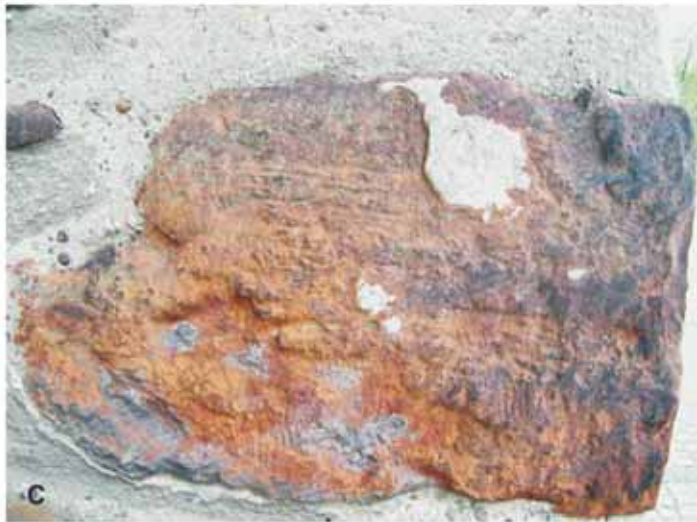
Abb. 35: Sandsteine der Haltern-Formation, kath. Pfarrkirche St. Maria Magdalena, Haltern. A Turm und Langhaus-Südseite, B Strebpfeiler Langhaus-Südseite, C Eisenschwartenstein, Langhaus-Südseite.
