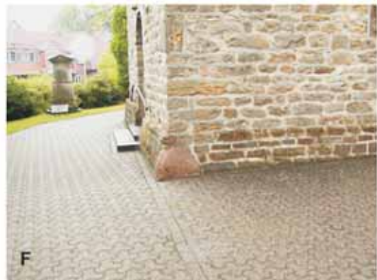
Abb. 79: Kristallines nordisches Geschiebe. A Darfeld, Zufahrt zum Schloss, B Rinkerode, Haus Borg, 1717, Ostseite der Wirtschaftsgebäude, im Fundament Findling im Verband mit turbiditischen Bruchsteinen des Vorhelm-Members und Ziegelsteinen. C Everswinkel, kath. Pfarrkirche St. Magnus, um 1500, Südseite, Findling im Verband mit turbiditischen Bruchsteinen, des Vorhelm-Members, D Hilstrup, Alte Clemenskirche, Südseite, Findling als Fundament eines Stützpfiebers. E Clarholz, kath. Pfarrkirche St. Laurentius, ehem. Stiftskirche, Nordseite Langhaus im oberen Mauerwerksbereich, F Gahlen Dorfskirche, Turm, spätes 12. Jh., Findling als „guter Stein“ an der rechten Turmseite im Verband mit Sandsteinen der Haltern-Formation.
