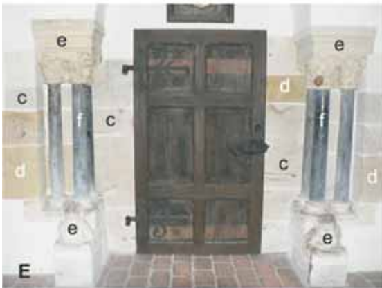
Abb. 17: A-D Osning-Sandstein aus dem Gebiet des Dörenbergs bei Bad Iburg. A-C Bad Iburg, Fleckenskirche St. Nikolaus, 14. Jh., A Westseite, B-C Südseite, Mauerwerksausschnitte, D Klosterkirche St. Clemens, Langhaus, Chor, West- und Nordseite, 13. Jh. E-F Osning-Sandstein zwischen Horn und Detmold-Hörste sowie zwischen Oerlinghausen und Borgholzhausen in der Schlosskapelle von Rheda, 3. Jahrzehnt 13 Jh. Innenportal im zweiten Geschoss, Chorjoch, oberer Säulenabschnitt, Kapitelle, Sims und Joch, a Osning-Sandstein aus den Gebiet des Dörenbergs, b Sinterkalkstein von Bad Laer, c Osning-Sandstein zwischen Horn und Detmold-Hörste, d Osning-Sandstein zwischen Oerlinghausen und Borgholzhausen, e Baumberger Sandstein, f paläozoischer Schiefer, nach mündlicher Überlieferung aus dem Raum Nuttlar.
