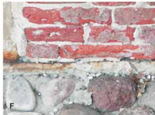
Abb. 88: Schieferplatten als Zwischenlagen. A Herzfeld, kath. Pfarrkirche St. Ida, Krypta mit Fundamentresten des Chors der karolingischen Kirche, um 800, Schieferplatten zwischen a Sinterkalksteinen von Salzkotten, die auf b Bruchsteinen des untercampanen Stromberg-Members lagern, B Münster, St. Paulus Dom, spätes 12. Jh., Werksteinsockel Nordturm, Nordseite, Schieferplatten zwischen Quadern aus Bentheimer Sandstein, C Nottuln, kath. Pfarrkirche St. Martin, ehem. Stiftskirche, 1489 begonnen, Schieferplatten in Lagerfuge zwischen Bentheimer Sandstein als Fundament sowie Baumberger Sandstein und in Lager- sowie Stoßfugen der Quader aus Baumberger Sandstein, D Lippstadt, ehemaliges Augustinerinnen-Stift, Südtor, Alter unklar, Schieferplatten zwischen Quadern aus Soester Grünsandstein im Bereich des Bogens, E Herzebrock, ehemaliges Klostertor, Anfang 18. Jh., Schieferplatten in Kombination mit Ziegelsteinabschlägen im Torbogen, F Nienberge, Haus Rüschaus, 1745-1748, Fundament an der Ostseite, Schieferplatten als Feuchtigkeitssperre zwischen nordischem Geschiebe als Fundament und Ziegelsteinen sowie Werksteinen aus Baumberger Sandstein als Sockelmauerwerk.
