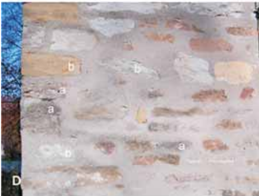
Abb. 76: Sinterkalkstein von Salzkotten. A-B Salzkotten, Brunnenhauses der Unitas-Quelle, 1554, Quader im Mauerwerk an der Südostecke, B Mauerwerk aus Bruch- und Werksteinen des Sinterkalksteins von Salzkotten und der Erwitte-Formation, erneuert 1980/82, im Vordergrund Sinterkalksteine des Klüfelfens, C Salzkotten, kath. Pfarrkirche St. Johannes Baptist, 2. Hälfte 13. Jh., südliches Turmportal, vor der Neuverputzung, D-E Thüle, kath. Pfarrkirche St. Laurentius, um 1200, D Nordostecke des Chors, um 1200, E Nordseite des Turms, a Sinterkalkstein von Salzkotten, b Plänerkalksteine der Erwitte-Formation, c Soester Grünsandstein, d Rühthener Grünsandstein.
