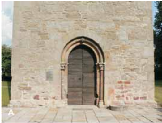
Abb. 81: Ibberbürener Sandstein. Recke, ev. Pfarrkirche, Anfang 12. Jh., A Untergeschoss der Westseite des Turms, B Detailansicht des rechten Sockels, mittel- bis grobsandige und konglomeratische Variante des Ibberbürener Sandsteins.
