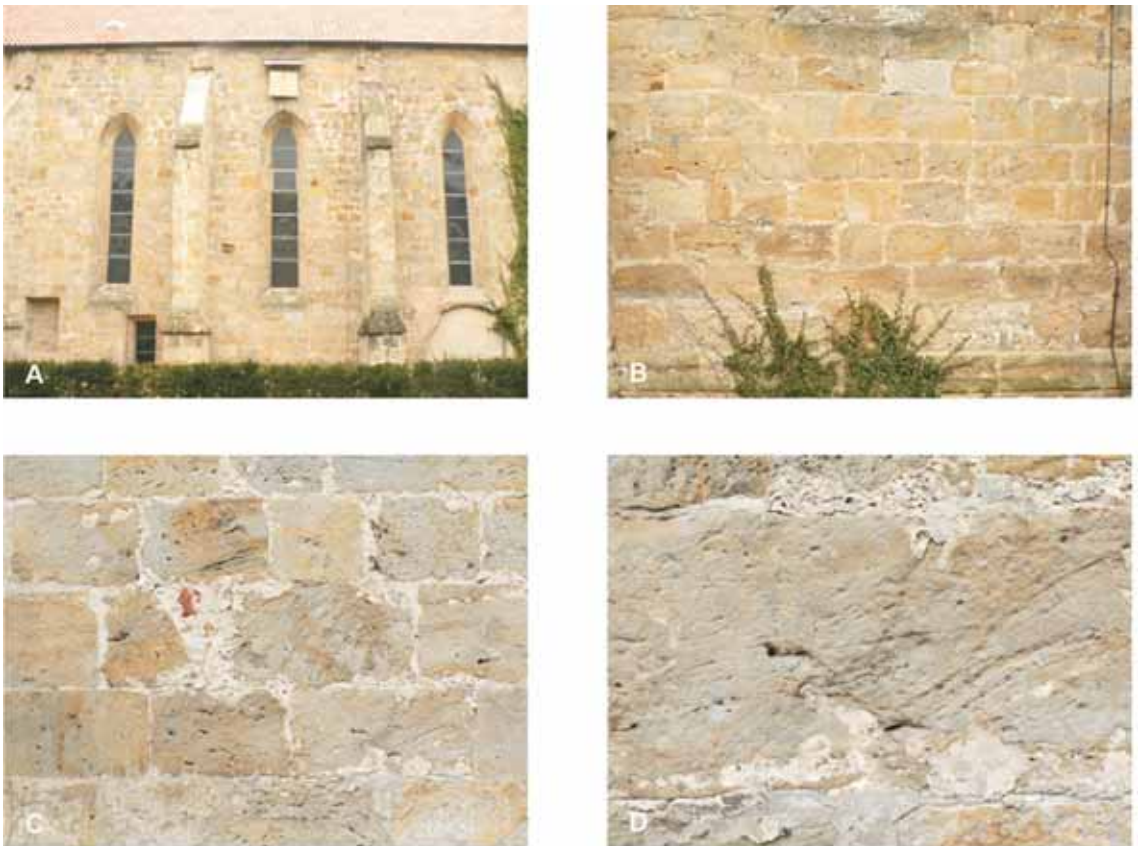
Abb. 20: Osning-Sandstein aus dem Gebiet von Gravenhorst und Bevergern. A-D Gravenhorst, Rektorskirche St. Bernhard, 1200, A Langhaus-Südwand, Mischmauerwerk mit Gravenhorster und Bevergerner Sandstein, B Wandausschnitt, C Wandausschnitt Nordwand vornehmlich Gravenhorster Sandstein, D Nordwand, Einzelquader Gravenhorster Sandstein.
