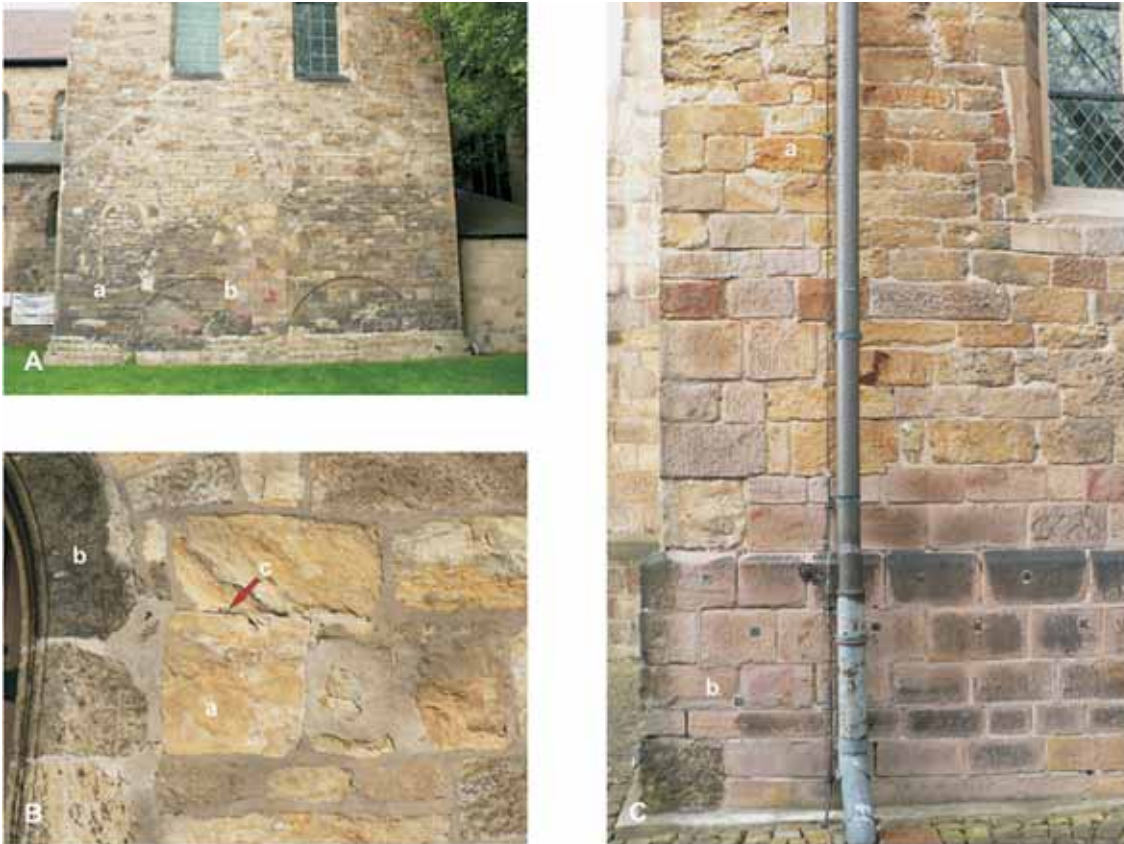
Abb. 31: Cappenberger Sandmergelstein, Recklinghausen-Formation. A-C Cappenberg, kath. Pfarrkirche St. Johannes Ev., ehem. Stiftskirche, 12. Jh., gotischer Chor 1387, A Südostquerhaus, B Westportal, Ausschnitt, C Südwestecke Langhaus, a Cappenberger Sandmergelstein, b Ruhsandstein, erneuert Ende 19. Jh., c paläozooische Schieferplatte als Zwischenlage.
