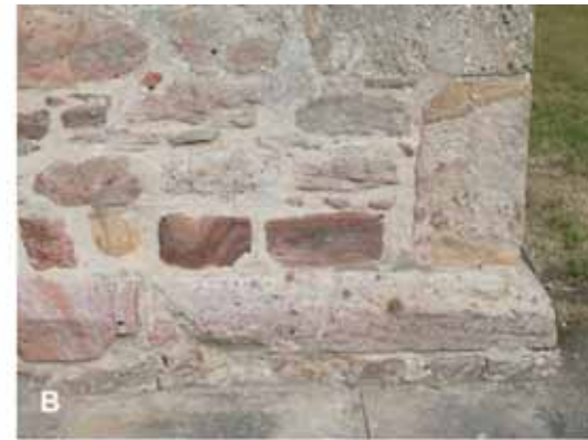
Abb. 81: Ibberbürener Sandstein. Recke, ev. Pfarrkirche, Anfang 12. Jh., A Untergeschoss der Westseite des Turms, B Detailansicht des rechten Sockels, mittel- bis grobsandige und konglomeratische Variante des Ibberbürener Sandsteins.
