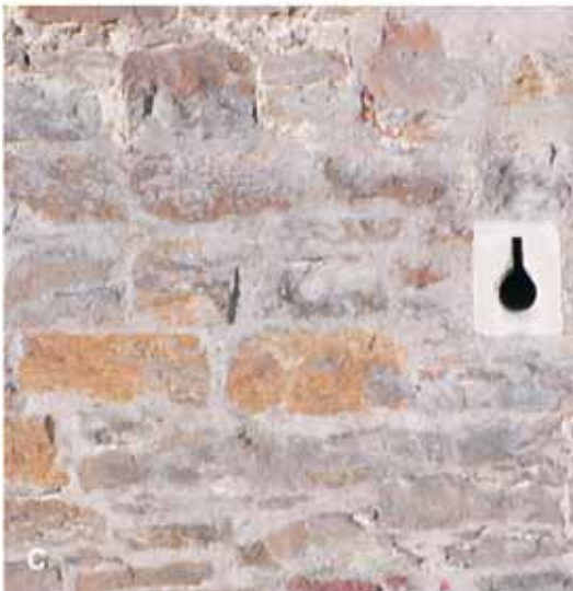
Abb. 66: Turbiditische Bruchsteine des Vorhelm-Members, Ahlen-Formation. A, C, E Herbern, Schloss Westerwinkel, A Westseite nordwestliches Eckbastion, 1663-1696, C Mauerwerksauschnitt, E turbiditischer Bruchstein des Vorhelm-Members, B, D Ascheberg, Haus Romberg, B Torhaus, 1618, C Sockel Torhaus, Tor- und Fenstergewänder sowie Schießscharten Baumberger Sandstein.
