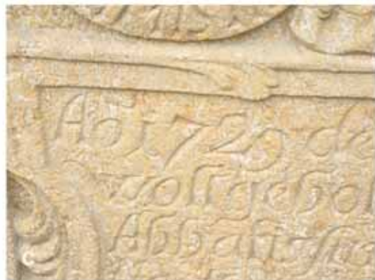
Abb. 21: Osning-Sandstein aus den Gebieten von Gravenhorst und Bevergern. A Gravenhorst, Kloster St. Bernhard, Epitaph an der erhaltenen nördlichen Klostermauer, links Gravenhorster Sandstein, rechts Bevergerner Sandstein, Mauer im Hintergrund Mischmauerwerk aus Gravenhorster und Bevergerner Sandstein, B Epitaph, Detailansicht, Gravenhorster Sandstein, 1681, C Epitaph, Detailansicht, Bevergerner Sandstein, 1729.
