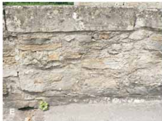
Abb. 66: Turbiditische Bruchsteine des Vorhelm-Members, Ahlen-Formation. A, C, E Herbern, Schloss Westerwinkel, A Westseite nordwestliches Eckbastion, 1663-1696, C Mauerwerksauschnitt, E turbiditischer Bruchstein des Vorhelm-Members, B, D Ascheberg, Haus Romberg, B Torhaus, 1618, C Sockel Torhaus, Tor- und Fenstergewänder sowie Schießscharten Baumberger Sandstein.
