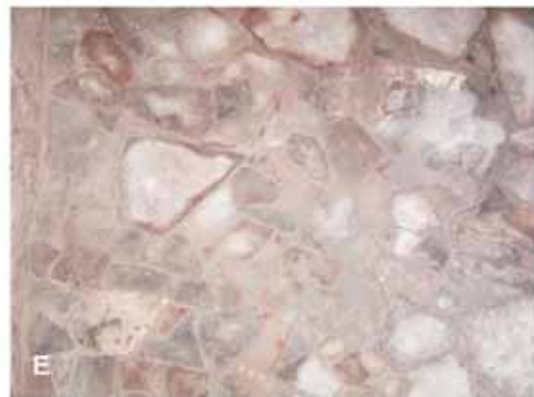
Abb. 65: Turbiditische Bruchsteine des Vorhelm-Members, Ahlen-Formation. A, D Freckenhorst, kath. Pfarrkirche St. Bonifatius, A Westseite, 11. Jh., D Südwestturm, Wand- ausschnitt, B, C Drensteinfurt, kath. Pfarrkirche St. Regina, B Westseite, C Mauerausschnitt, E Telgte, Haus Münsterstraße 6, freigelegter historischer Kellerfußboden, a Kalkturbidite des Vorhelm-Members, b Werksteine des Beckum-Members, Ersatz des 19. Jh., c Osning-Sandstein, Ersatz des 19. Jh., d Baumberger Sandstein.
