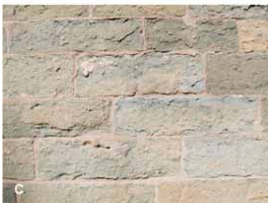
Abb. 51: Soester Grünsandstein als Naturbaustein im Stadtgebiet von Soest. A-C Kath. Probsteikirche St. Patrokli, 11. Jh. - 12. Jh., A Turm Westfront, B Wandausschnitt Langhaus-Nordseite, C Kreuzgang, D Ev. Brunstein-Kapelle, Süd- und Ostseite, a Soester Grünsandstein, b Rühthener Grünsandstein.
