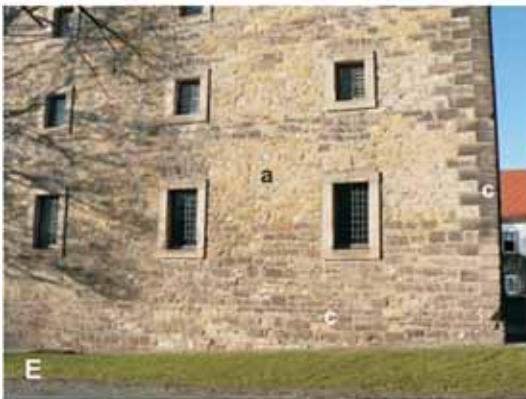
Abb. 84: Muschelkalk. A-C Neuenheerse, kath. Pfarrkirche St. Saturnina, A Turm 1. Viertel 12. Jh., Langhaus, Umbauten 14. Jh., B Langhaus Südseite, C Mauerausschnitt Turm, D Werther, ev. Pfarrkirche, 14. Jh., 1743 erneuert, E-F Hardehausen, Kornhaus, E Südseite, 18. Jh., F Mauerausschnitt Südseite, a Muschelkalk, b Osning-Sandstein, c Buntsandstein.
