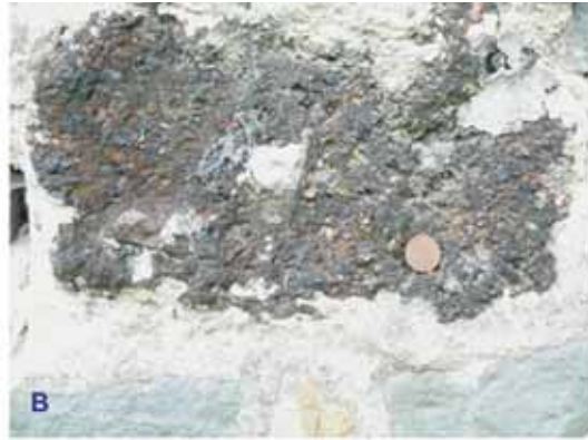
Abb. 77: Raseneisenstein A-B Vreden, kath. Pfarrkirche St. Georg, ehemalige Stiftskirche, Südwand des Langhauses. A Mauerwerksausschnitt, B Detailansicht eines mit kleinen Kiesel verbackenen Bruchsteins, Maßstab 2-Cent-Münze, a Eisenstein, b Bentheimer Sandstein, c Sandsteine der Unterkreide aus dem Raum Vreden-Lünten.
