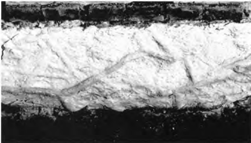
Abb. 21: Heile Knubbe mit Thalassinoides sp., senkrecht eingemauert, Hof Lütke-Dörhoff, Oelde-Keitlinghausen, Scheunenbau aus dem 19. Jahrhundert, Bildbreite ca. 95 cm.
