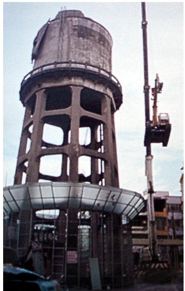
圖 10 高架水塔拆除時的最後序幕 時間：民國八十九年十二月（2000 年 12 月）
