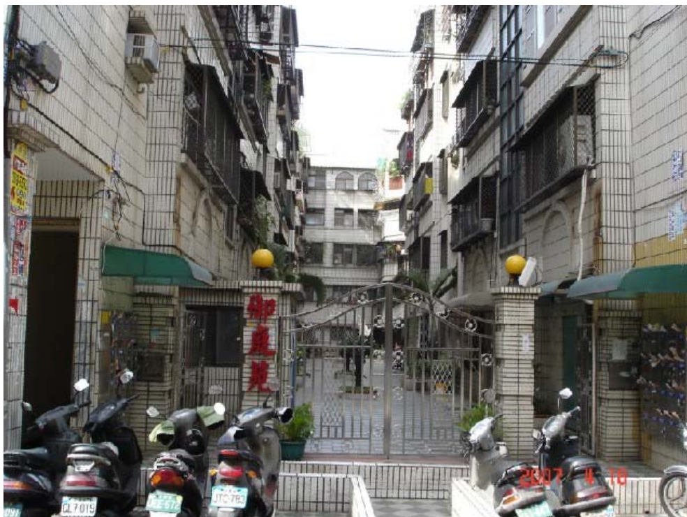
圖 12 鳳山水道氣曝塔位置
