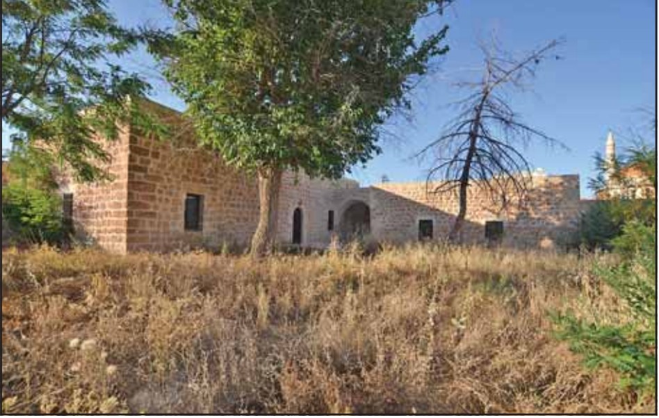
Resim 9: Bardakçı (Bate) Köyü, Süryani Katolik Kilisesi, güneybatı cephesinden genel görünüm.
