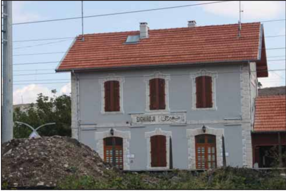
Resim 10: Akçapınar, Gar Binası.
