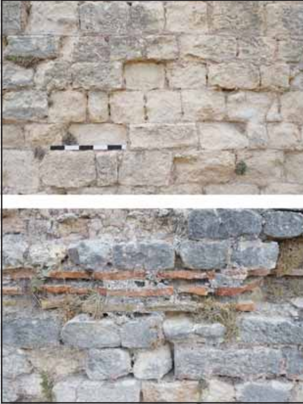
Resim 8: Kuzey ve güney rezervuarlarının duvar örgüleri.
