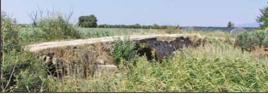
Resim 5: Okuf Köprüsü genel görünüm.
