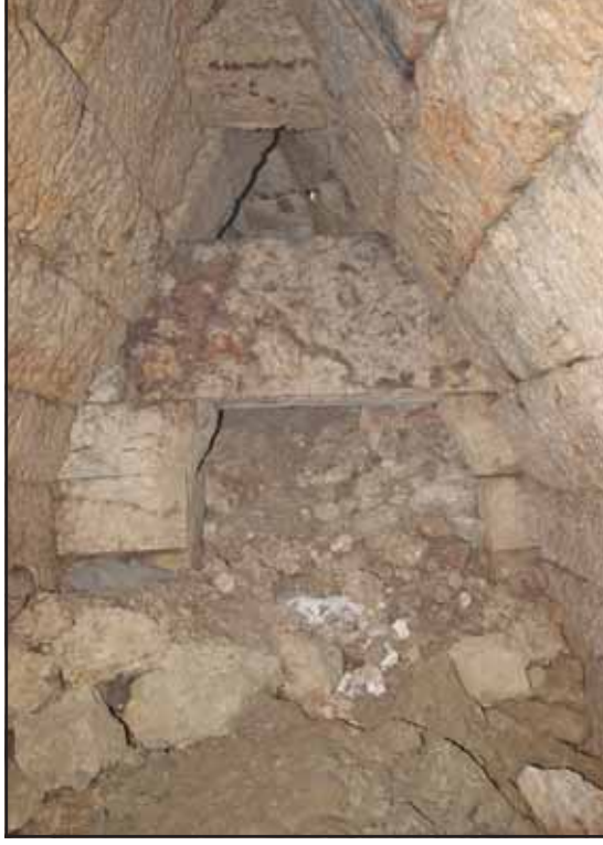
Resim 3: Dromoslu Yapı-Paşa Deliği içten görünümü.
